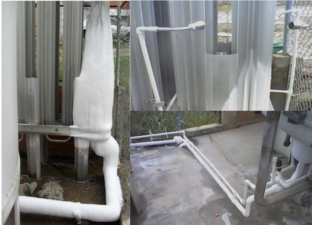
**Figura 9. Izq. Evaporador completamente congelado. Der. Arriba, vaporizador más sistema de riego. Abajo, tubería externa más sistema de riego<sup>4</sup>**
