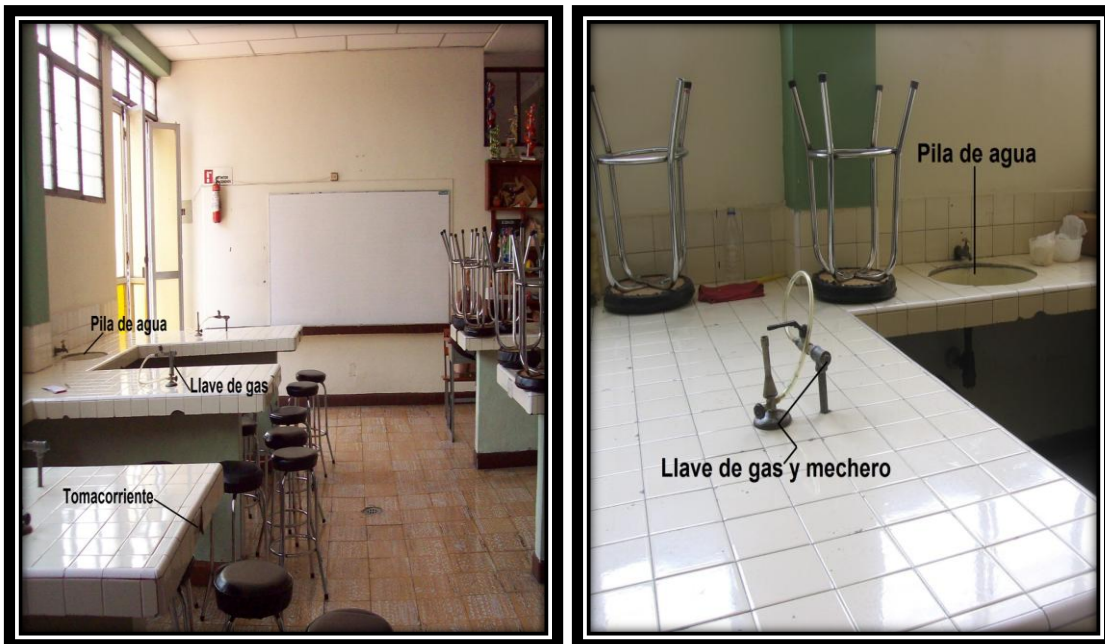
Figura 3.13. Instalaciones hidráulicas y de gas
