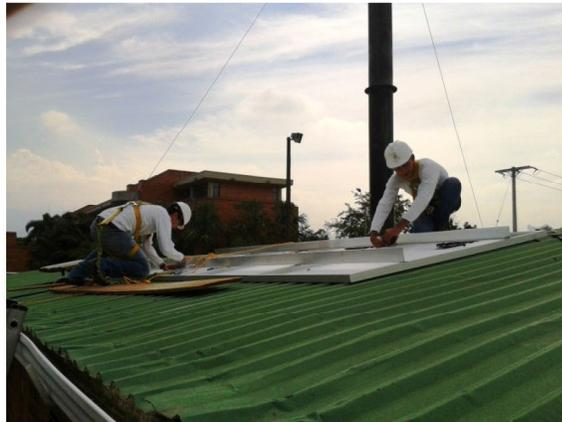
**Figura 16. Instalación módulo solar fotovoltaico en la Universidad Autónoma de Occidente Cali**
