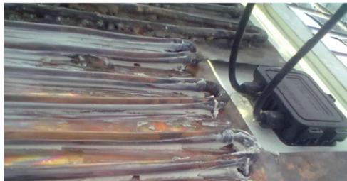
**Figura 13. Intercambiador de calor placa-tubo con silicona conductora**
