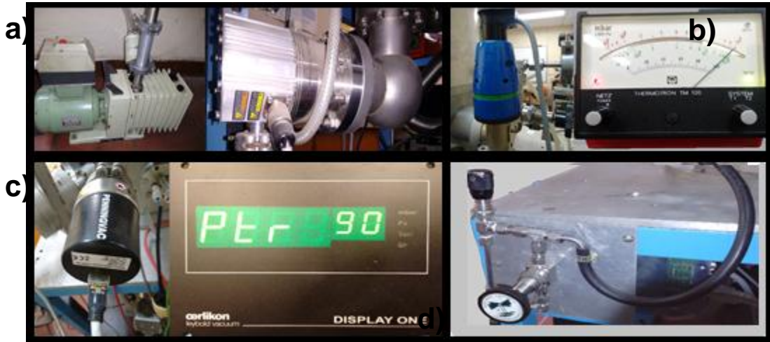
Figura 0-5: Sistema de vacío(a) sistema de bombas. (b) sensor PIRANI-COLD CATHODE. (c) sensor OERLIKON PENNING VAC- PRT90 LEYBOLD VACUUM. (d) Sistema Bypass.
