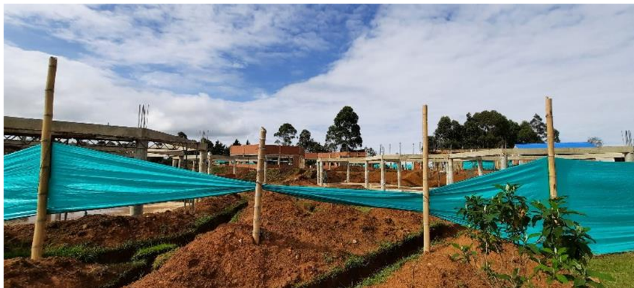
Figura 4. Aulas en construcción en la Institución Educativa Palacé
