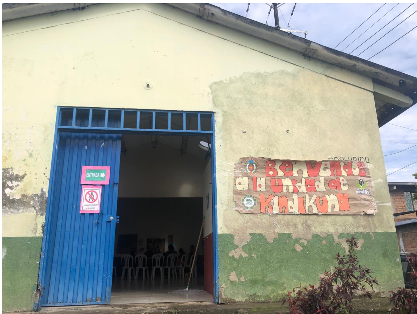
Fotografía .1 Fachada Espacio Semillas de Vida
