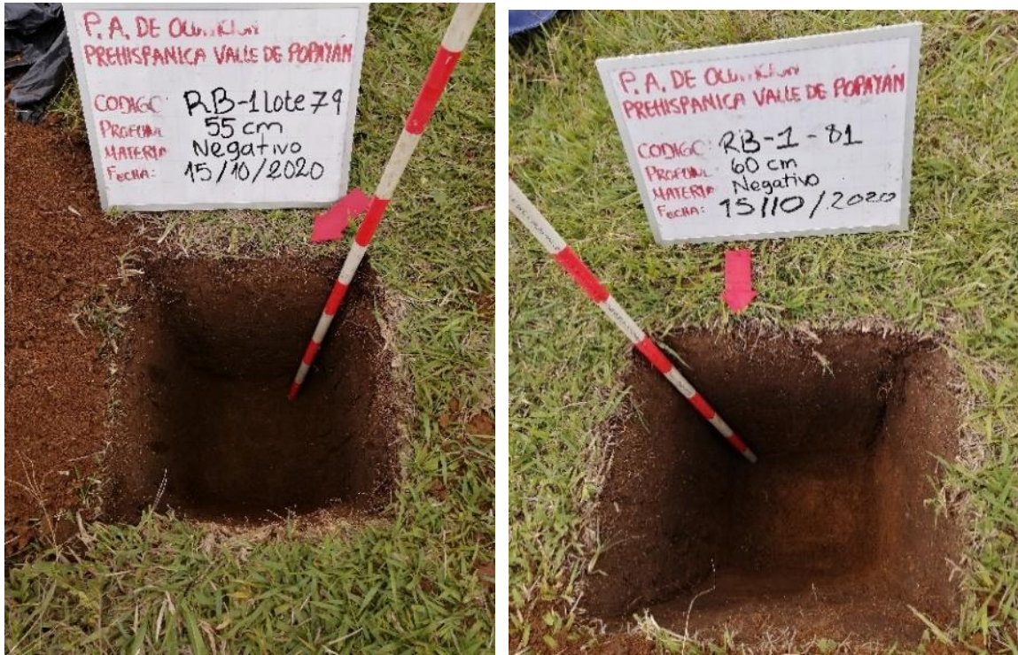
Figura 10. Pozos de sondeo zona 1. Fuente: foto propia
