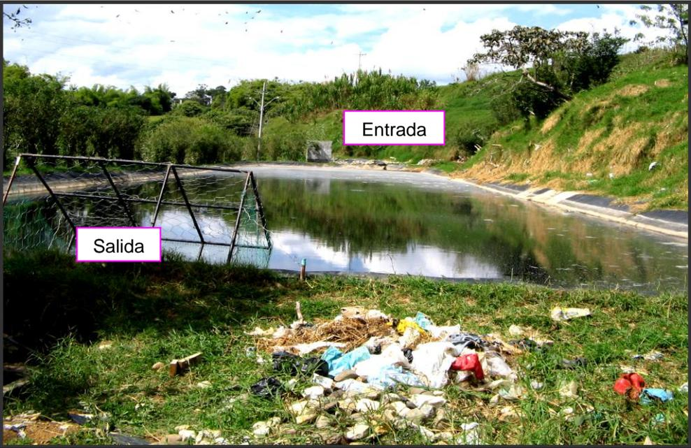
El tratamiento de los lixiviados en el relleno sanitario se realiza en una laguna de estabilización ubicada al costado izquierdo del relleno. Esta laguna tiene aproximadamente 14 m de ancho, 76.5 m de largo y una profundidad de 1,60 m (figura 4).
