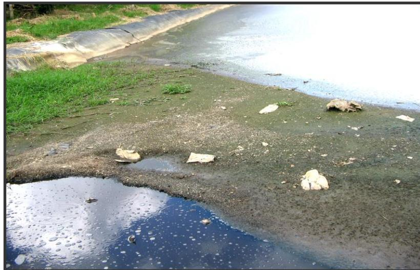
Si se ha disminuido la profundidad, podría esperarse que se hayan afectado las condiciones anaerobias de la laguna, porque ya los rayos solares podrían incidir al fondo de la laguna y provocar la proliferación de algas, como consecuencia de los procesos de fotosíntesis que se pueden desarrollar; lo que podría traer también la
