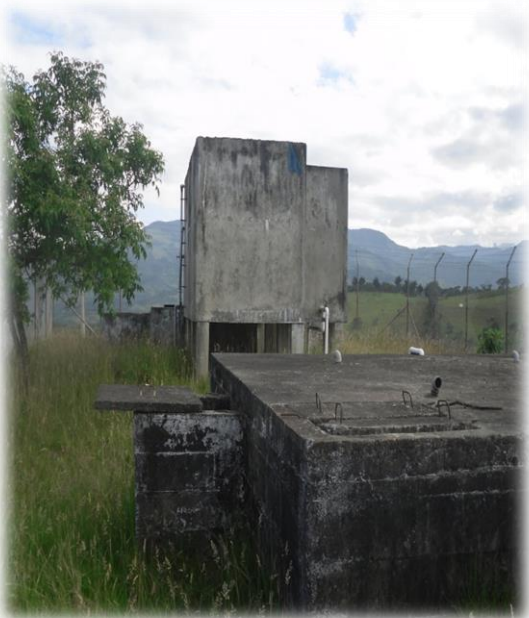
Anexo 62. Tanques de almacenamiento
