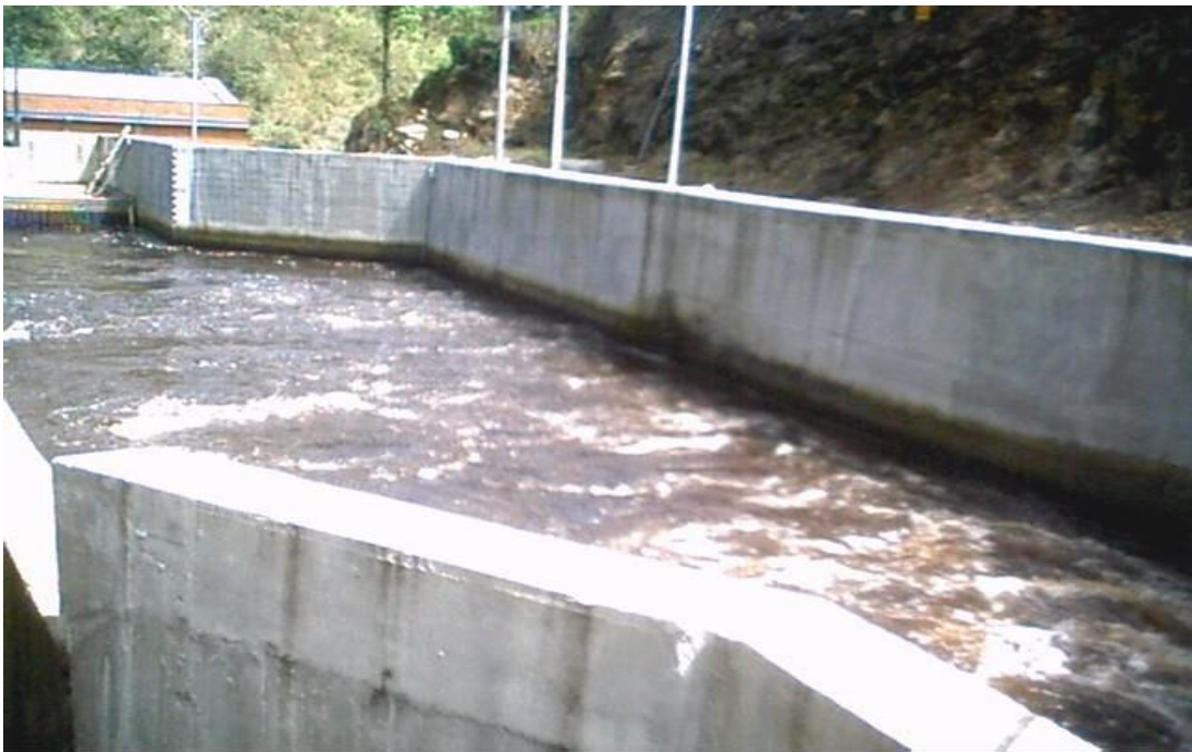
Foto 3. Canal abierto que conduce el agua hacia la tubería de carga
