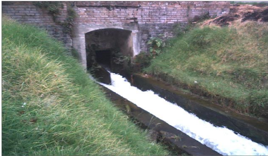
Figura 25. Caída de agua río Grande- Central hidroeléctrica- Coconuco
