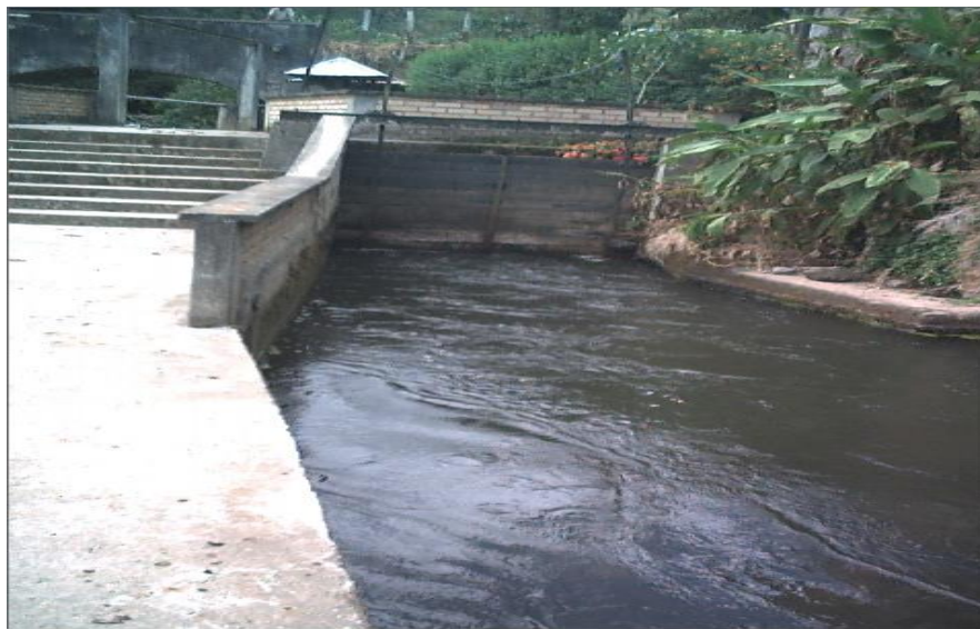
Figura 21. Estación No 4 Desvío río Grande
