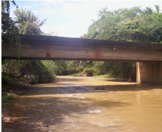
Figura 4. Puente sobre la quebrada Las Tallas
