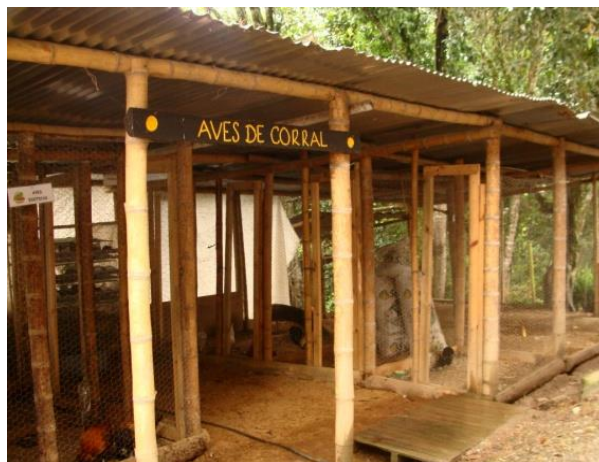
Figura 36: Sector destinado al alojamiento de codornices
