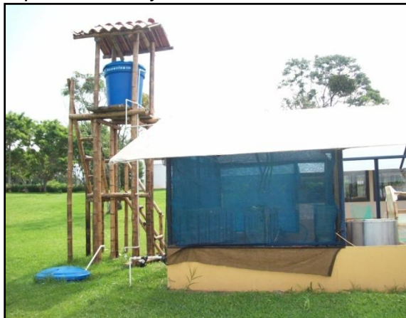
Figura 2. Instalaciones para el ensayo
