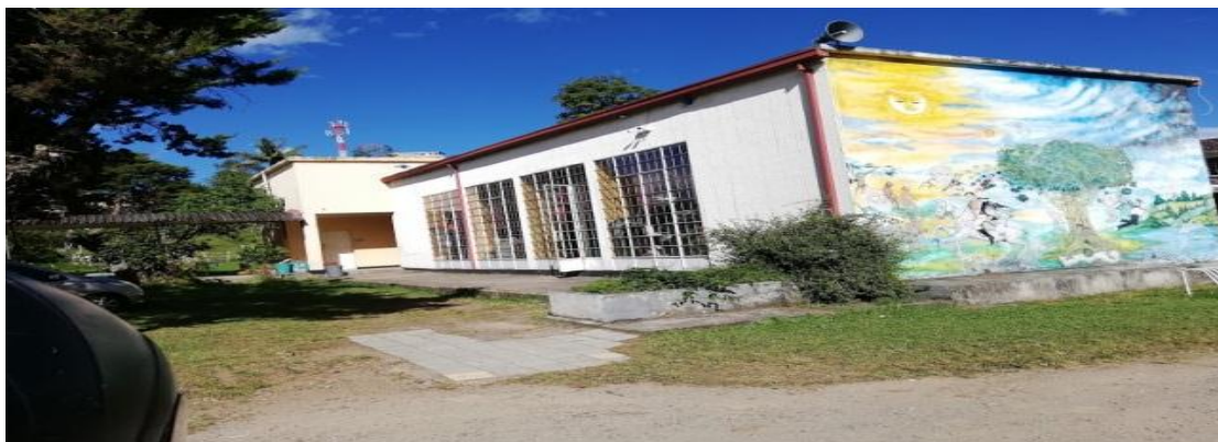
Figura 2. Bloque final Escuela Normal Superior.
