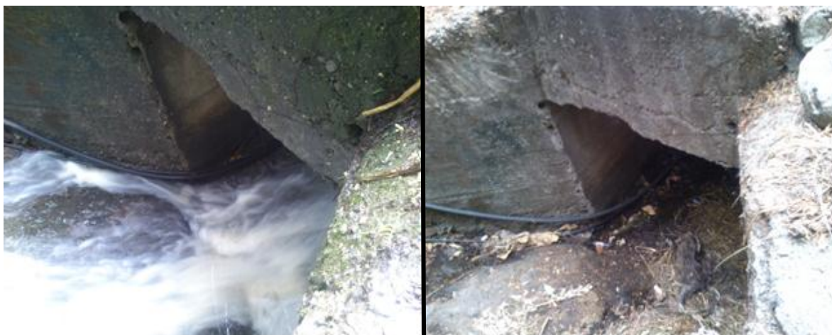
Figura 19. Alcantarillas existentes en la vía Panamericana.
