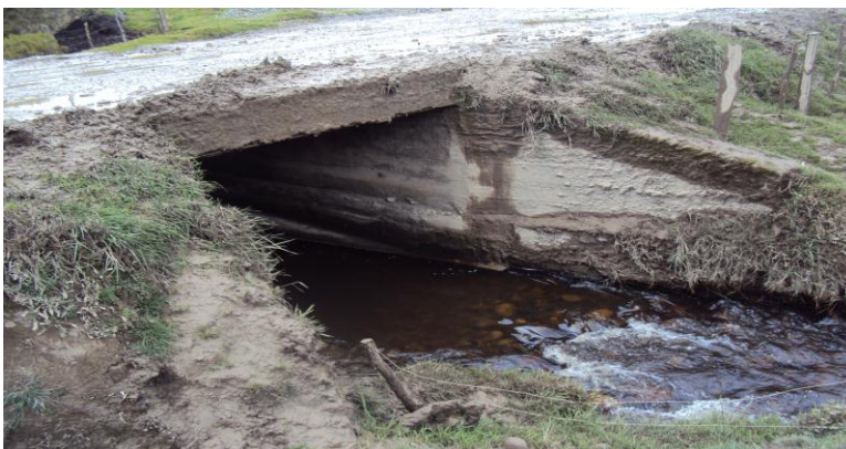
Figura 10. Puente Quebrada Yerbabuena.
