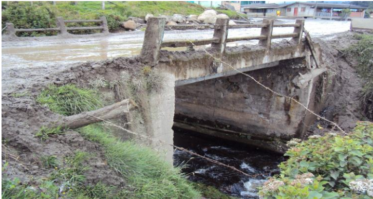
Figura 7. Puente rio Blanco
