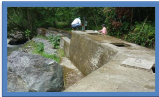
Figura 2. Bocatoma del acueducto regional Piendamó – Morales ubicada en la vereda de la Estrella municipio de Silvia.
