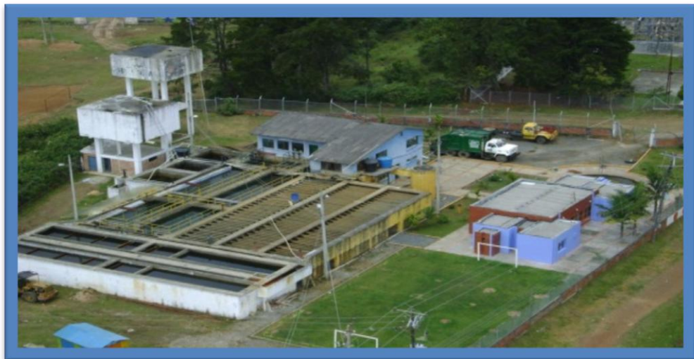
Figura 4. Vista general de la Planta de tratamiento del Acueducto regional Piendamó- Morales.
