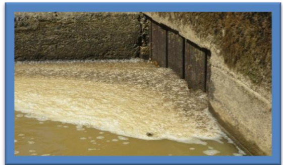
Figura 3. Panorámica general del sistema de captación del acueducto regional Piendamó – Morales.
