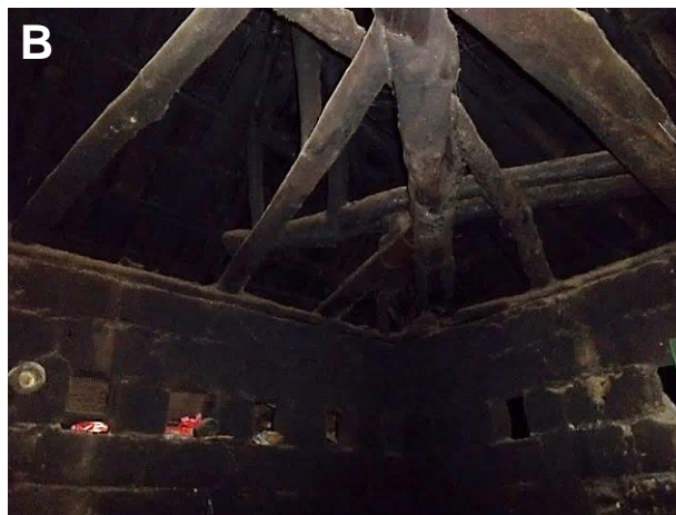
Anexo 15. Características de la vivienda que modulan la exposición. A) Pequeñas aberturas hacia el interior de la vivienda. B) Grandes aberturas hacia el interior de la vivienda. C) y D) acumulación de hollín en el techo y paredes de la cocina. (Fuente propia)
