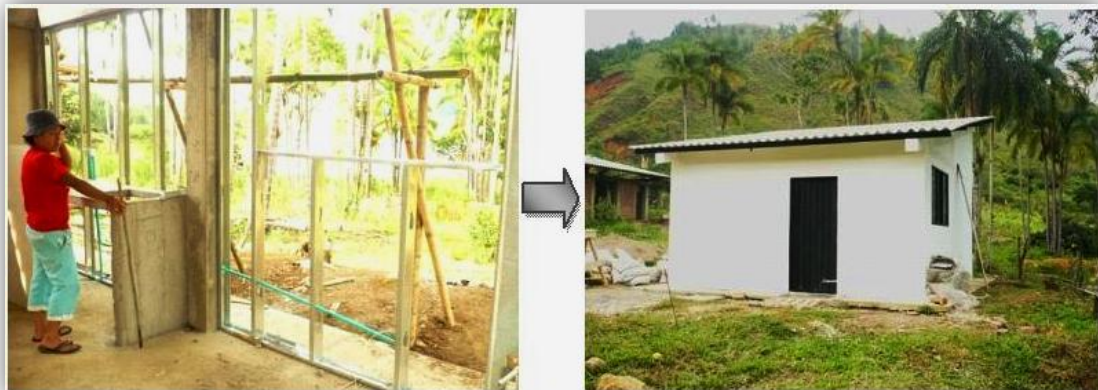
Figura 9. Construcción de planta procesadora
