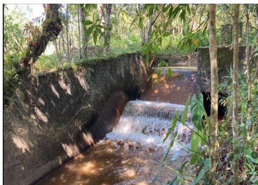
**Figura 5.** Desarenador del agua
