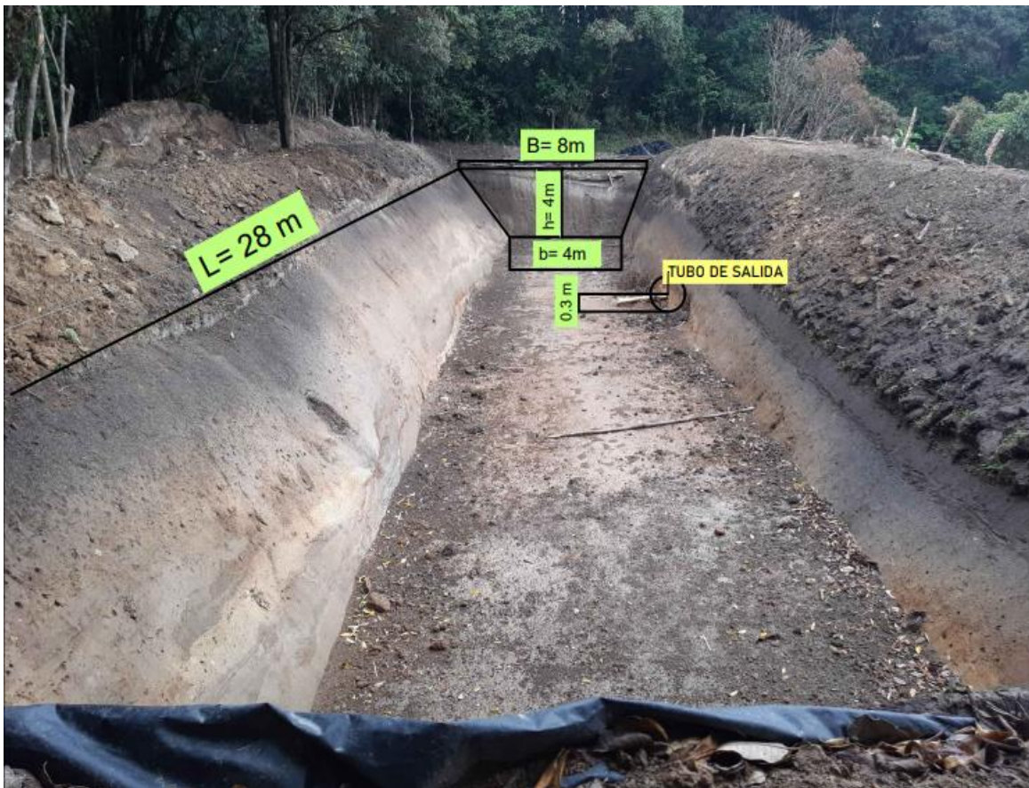
Figura 62. Dimensiones del reservorio.
