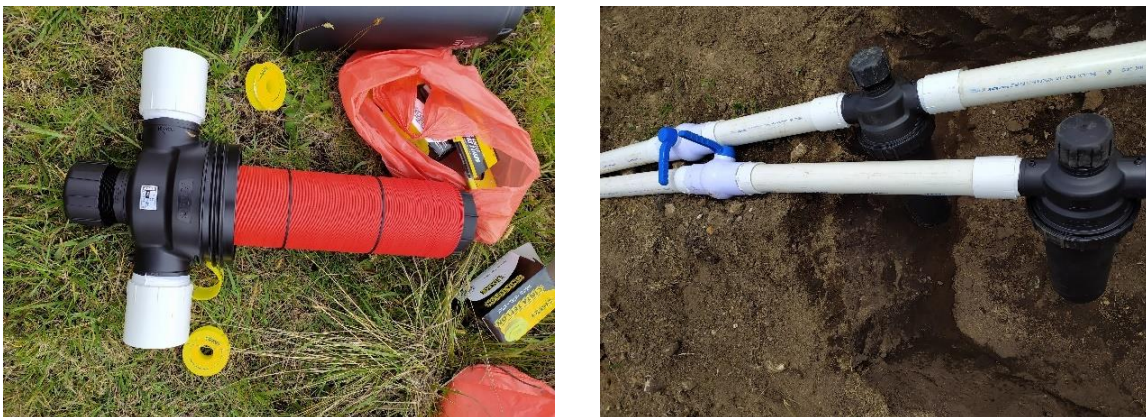
Figura 64. Filtro de anillos. Detalle válvulas de control.
