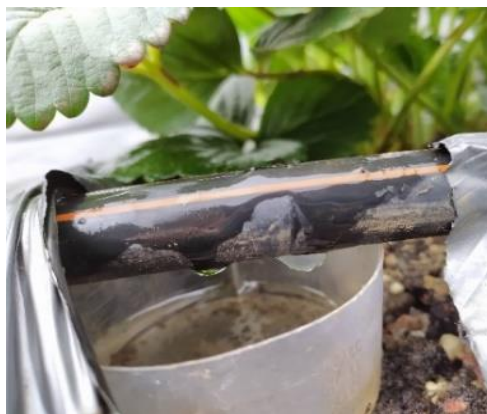
Figura 11. Descarga de cinta de riego.
