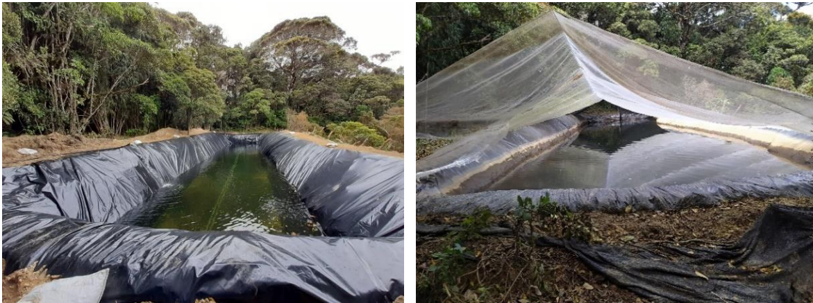
Figura 63. Aspecto de reservorio de agua en proceso de llenado. Protección con malla.
