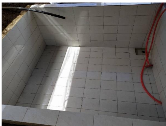
Figura 78. Tanque de mezcla en concreto, enchapado en cerámica.
