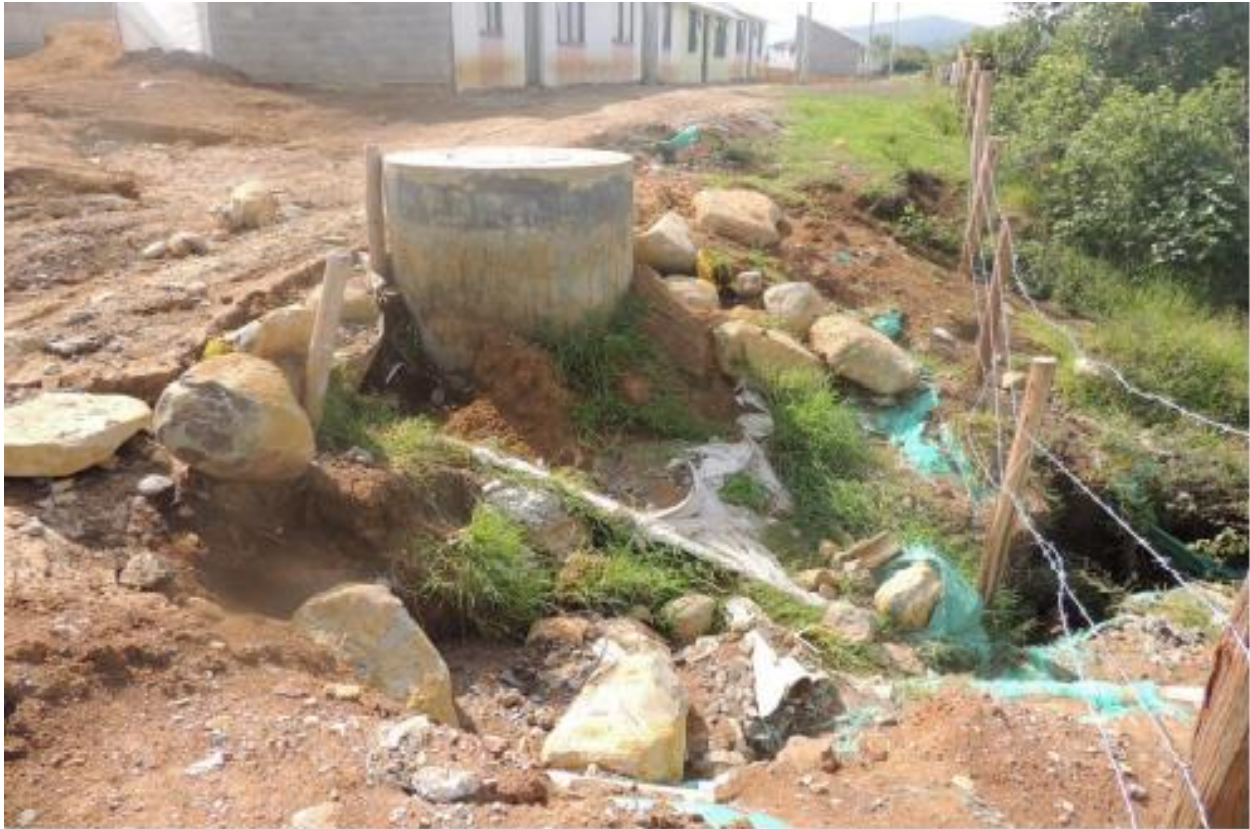
Fotografía 26. Obras de Alcantarillado y de vías, aun generando impactos sobre el humedal.
