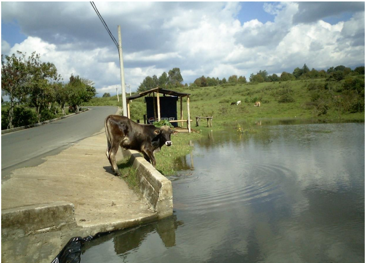
Fotografía 1. Box Coulvert para habilitar el paso por el complejo de humedales. 2004
