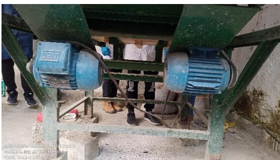
Ilustración 9. Motores de rotación excéntrica que ejercen vibración para compactar la mezcla
