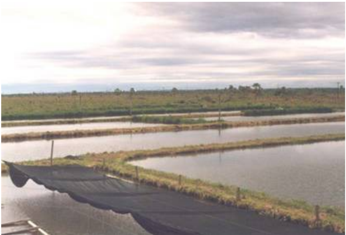
Figura18. Construcción de los estanques
