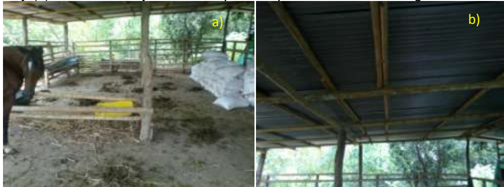
Figura 6. Características estructurales del área de alimentación, (a) vista del piso en concreto y (b) cubierta en teja de zinc soportada por transversales en guadua.
