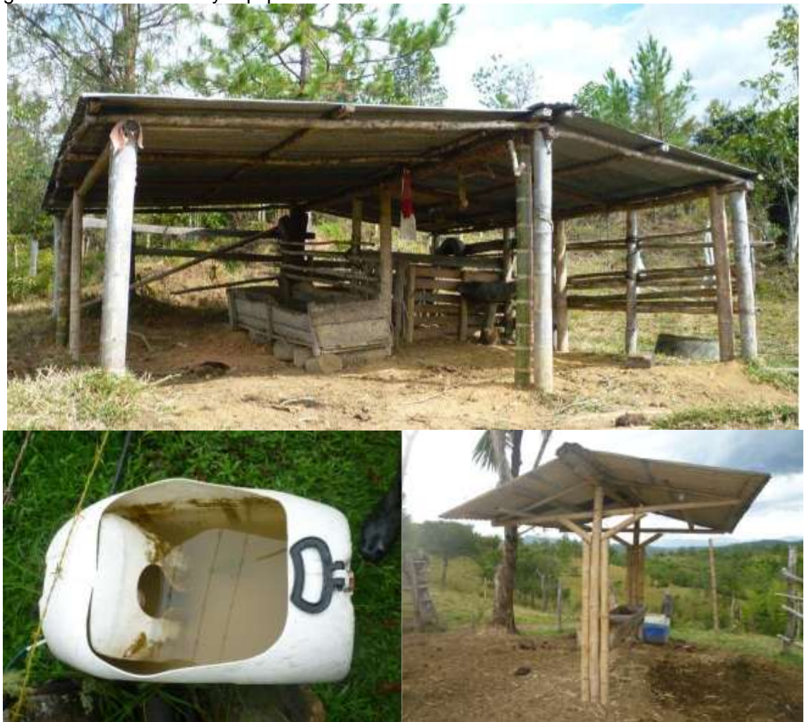
Figura 10. Instalaciones y equipos
