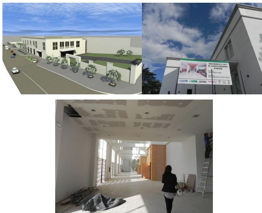
Figura 22. Centro de convenciones “Casa de la Moneda”
