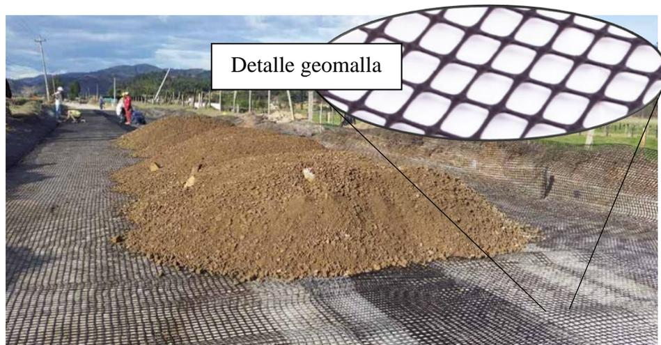
*Nota:* La figura presenta la instalación de geomalla y colocación de afirmado en una obra de infraestructura vial, así como el detalle de la geomalla. Fuente: *Tomado de Geomatrix.*
