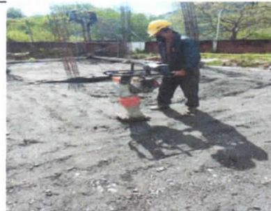
Relleno con suelo fino limoso compactado hasta el 90% de la densidad máxima del P.M. Inc. Suministro de material
