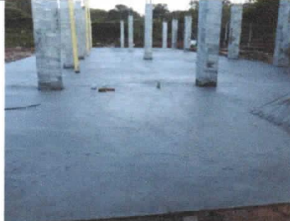
Losa Contrapiso concreto 2500 Psi E=10CM
