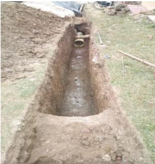
Ilustración 5.. Excavación manual.
