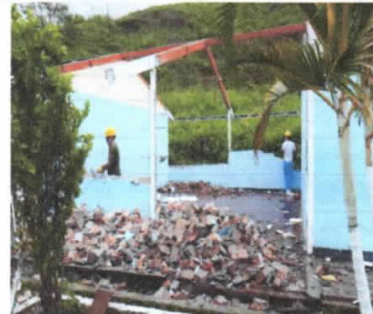
Demolición de muros en ladrillo
