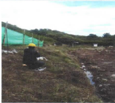
Localización y replanteo
