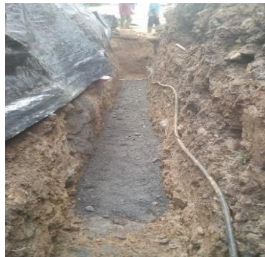
Ilustración 6.. Encamado de la tubería, h=0,15.
