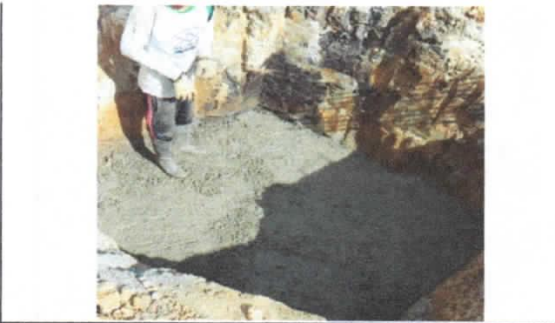
Solado de concreto espesor = 5 cms. En concreto clase F (14 MPA)
