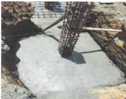
Zapata Concreto de 2.00 x 2.00 de 21 Mpa
