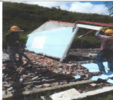
Demolición de cemento en concreto
