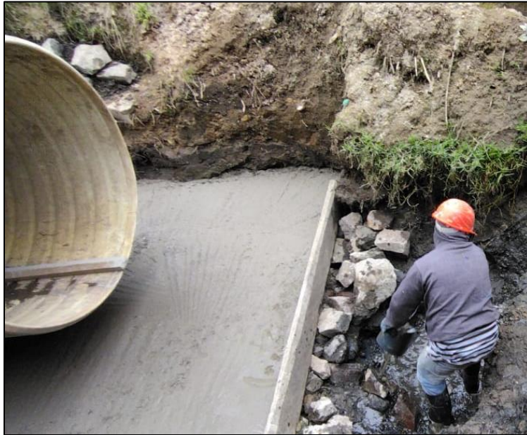
Ilustración 35 Losa de cimentación, Box Couvert las Ánimas
