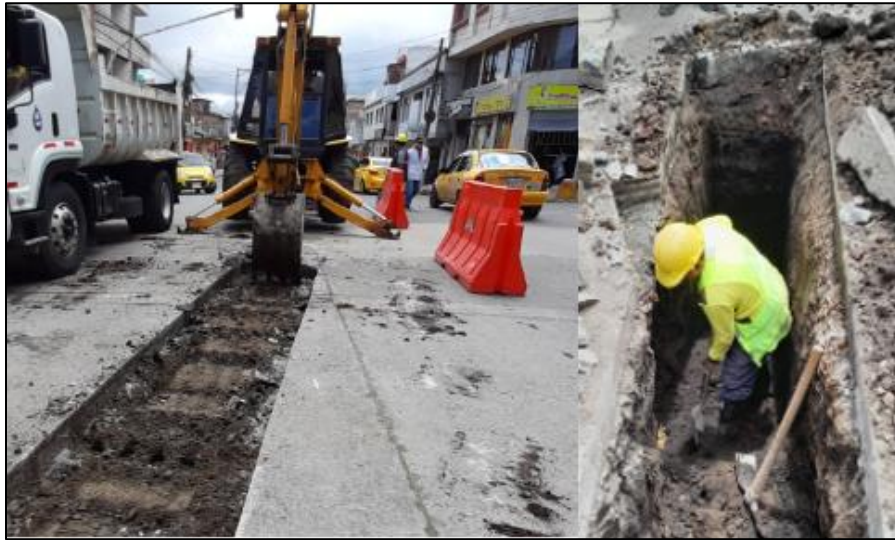
Ilustración 6 Demolición de Pavimento, Proyecto: Carrera 6
