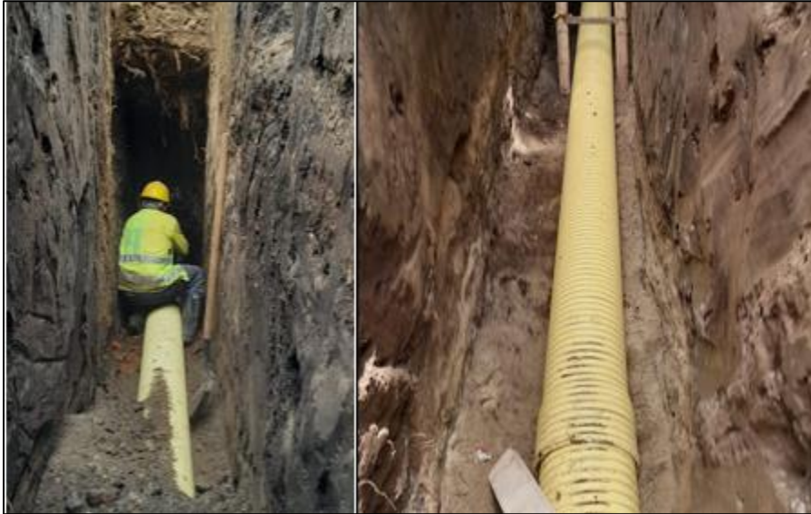
Ilustración 9 Instalación Tubería corrugada, Proyecto: Carrera 6
