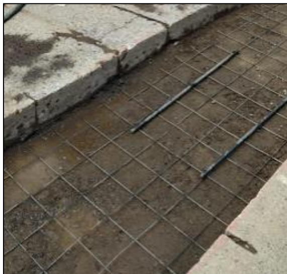
Ilustración 15 Refuerzo Losa de concreto, Proyecto: Carrera 6
