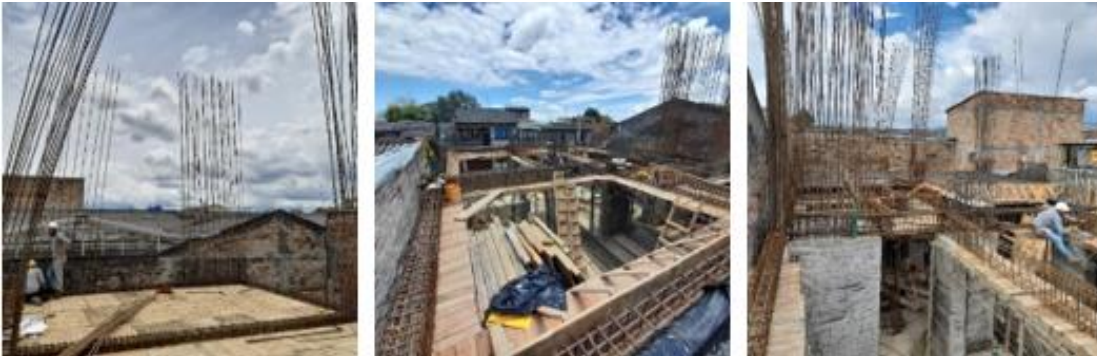
Figura 29- Armado de vigas. N +5.76.
