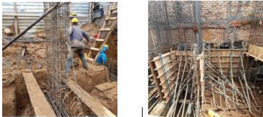
Figura 9- Armado y encofrado de pantallas.
