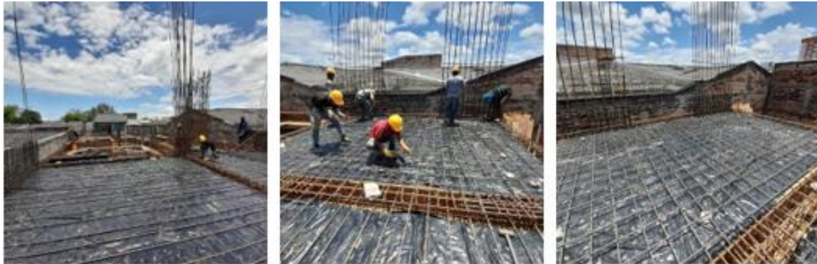
Figura 30.- Armado de parrilla en dos direcciones para la losa de entrepiso.
