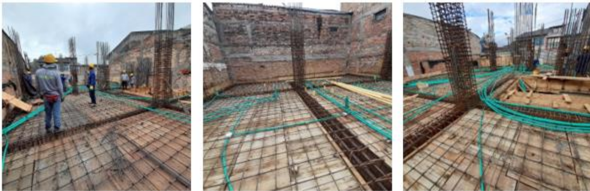
Figura 18- Chequeo de instalaciones hidrosanitarias e instalaciones eléctricas.
