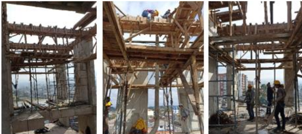
Figura 63.- Armado de formaleta de soporte doble nivel para el encofrado de viguetas nivel N+18,36
