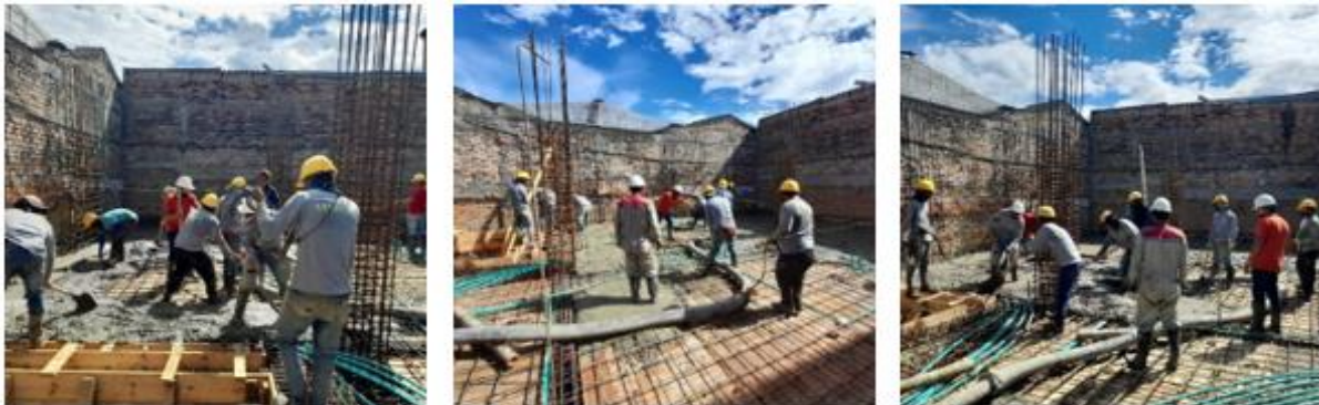
Figura 19- Actividades de vaciado de concreto.
