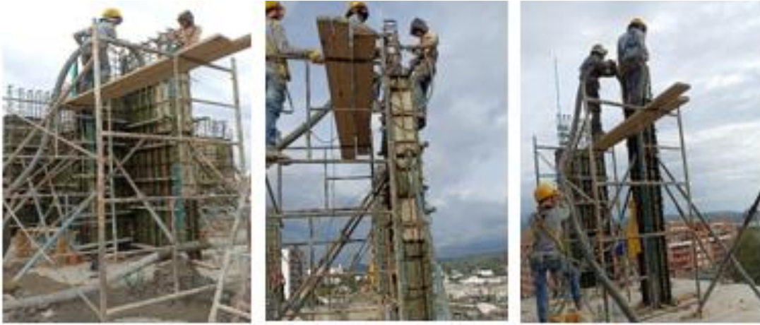
Figura 67.- Vaciado de concreto ejerciendo trabajo seguro en alturas.
