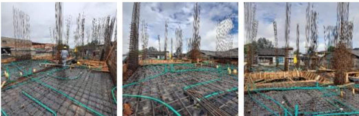
Figura 31.- Actividades previas al vaciado losa de entrepiso #2.
