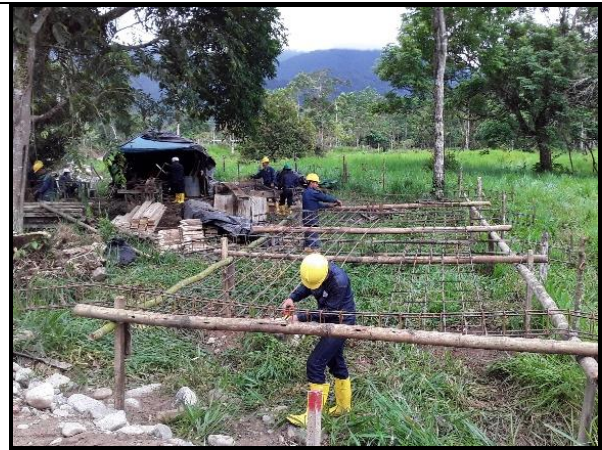
Fotografía 20. Refuerzo pre-armado.
