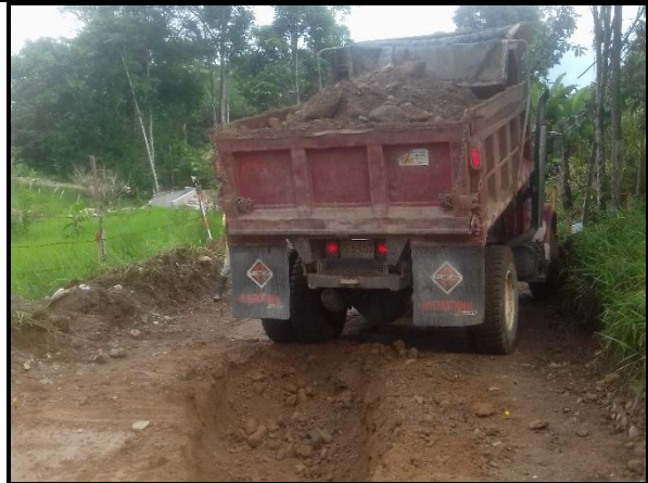
Fotografía 8. Cajeo puntual en subrasante.
