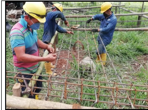
Fotografía 19. Armado previo del refuerzo.
