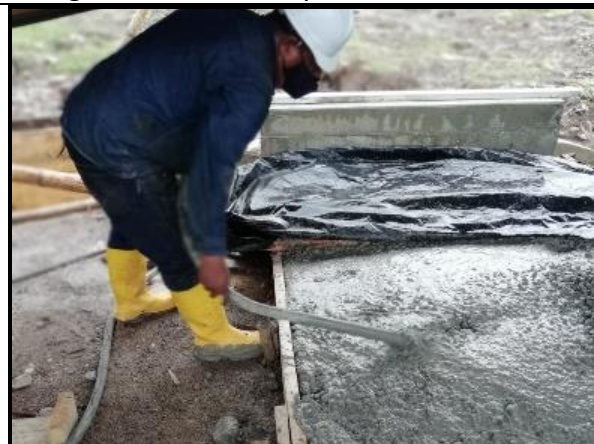
Fotografía 29. Vibrado del concreto.
