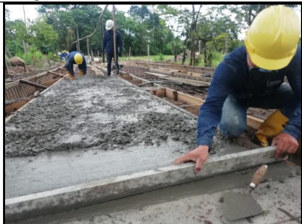
Fotografía 30. Acabados del concreto.
