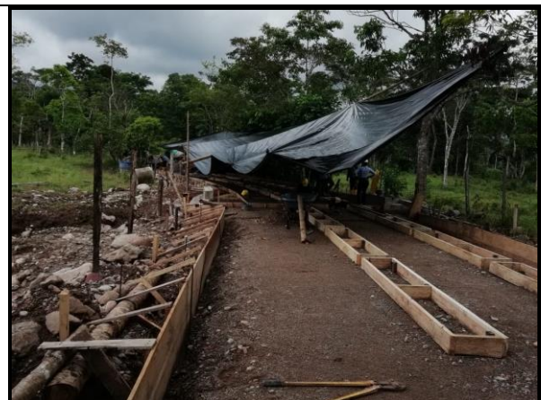
Fotografía 24. Protección de la zona de trabajo.
