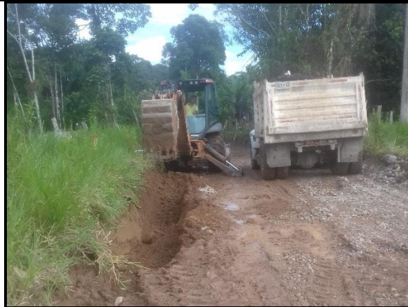
Fotografía 7. Cajeo longitudinal en subrasante.
