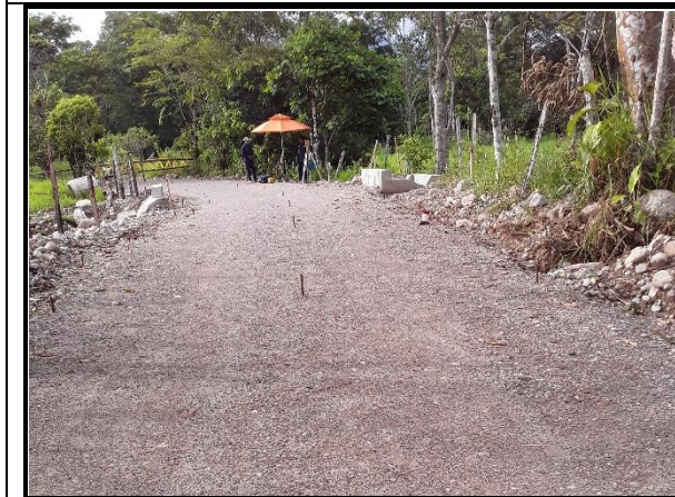
Fotografía 21. Localización de elementos de la placa-huella.
