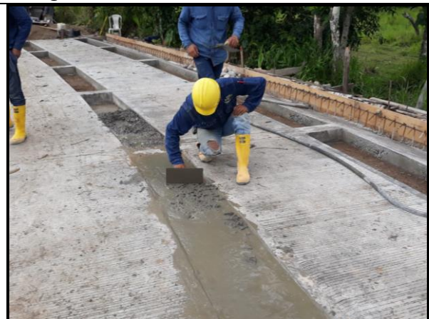
Fotografía 36. Fundición de entrehuellas.
