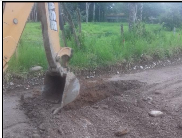
Fotografía 9. Relleno de cajeos.
