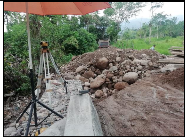
Fotografía 2. Relleno del sector box coulvert
