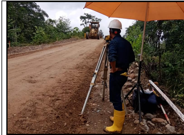
Fotografía 13. Chequeo de la altimetría.
