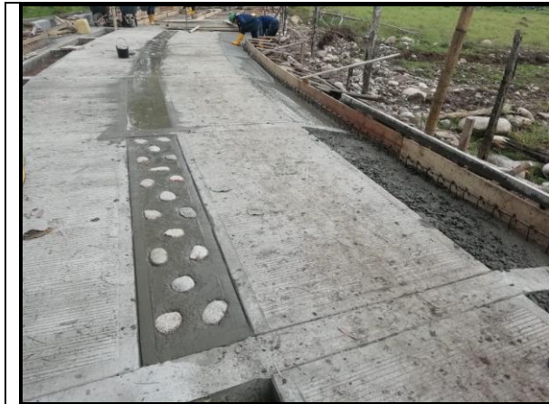
Fotografía 37. Colocación de piedra pegada.
