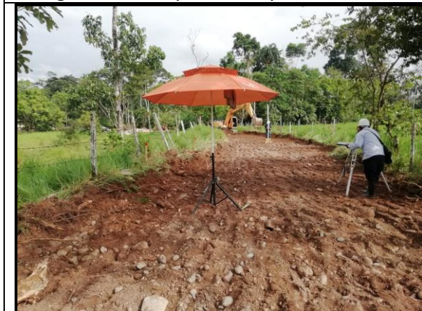
Fotografía 5. Conformación de subrasante.
