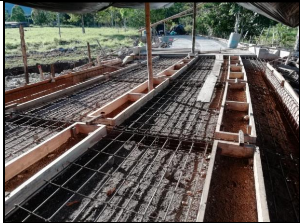
Fotografía 26. Instalación de acero de refuerzo de huellas, riostras y bordillos.
