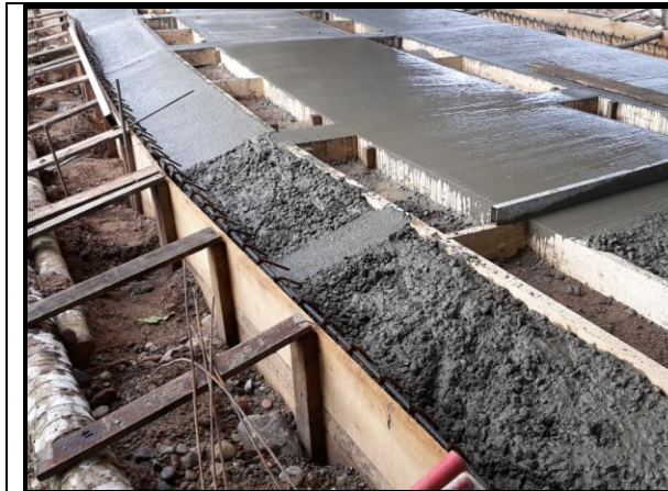
Fotografía 31. Fundición de placa-huella.
