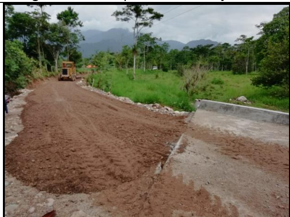
Fotografía 12. Conformación de subbase.
