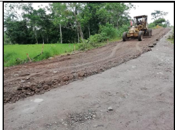
Fotografía 4. Conformación de subrasante.
