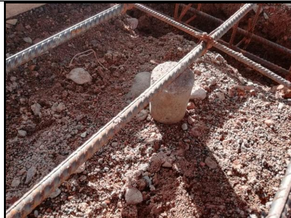
Fotografía 27. Paneles para el recubrimiento.
