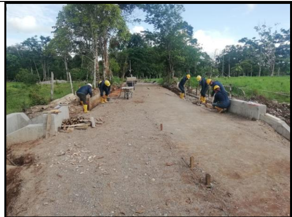
Fotografía 22. Excavación manual para la instalación de formaleta en bordillos.
