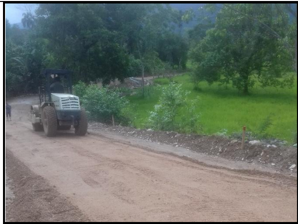
Fotografía 14. Compactación de subbase.
