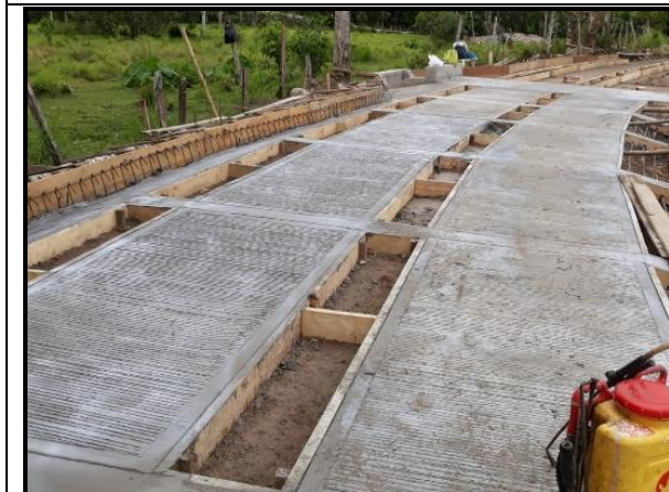
Fotografía 33. Aplicación del antisol.
