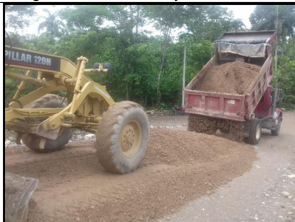
Fotografía 11. Extendido de subbase.
