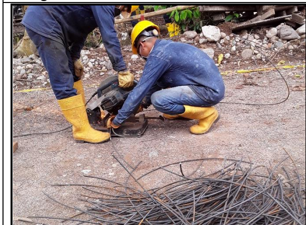
Fotografía 17. Corte del acero de refuerzo.
