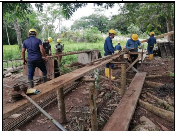
Fotografía 18. Corte y figurado del refuerzo.
