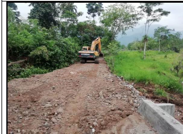
Fotografía 3. Compactación y conformación.
