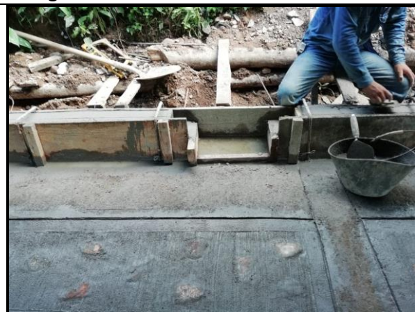
Fotografía 40. Espacio dispuesto para la construcción de cajilla de alcantarillado.
