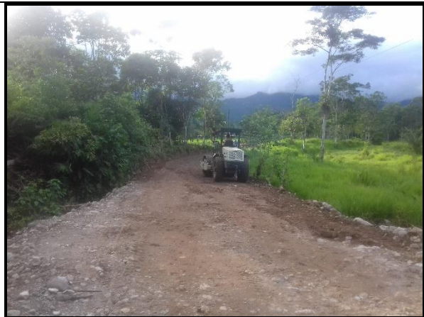
Fotografía 10. Compactación de cajeos.
