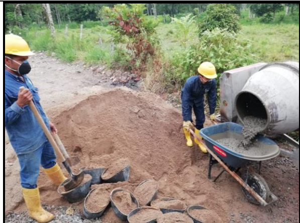
Fotografía 28. Elaboración del concreto.
