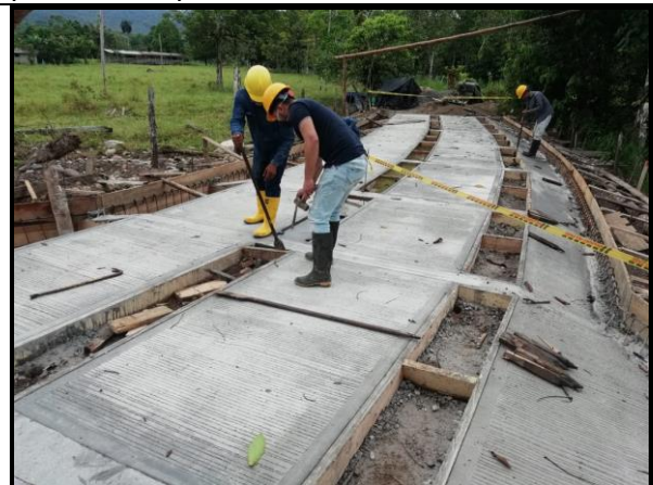
Fotografía 34. Retiro de formaletas.
