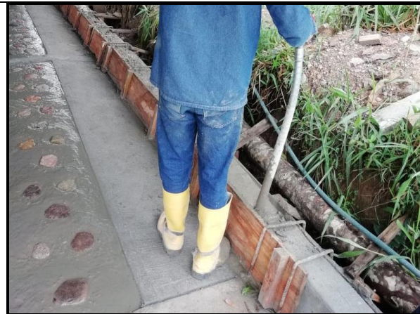
Fotografía 38. Fundición de bordillos.
