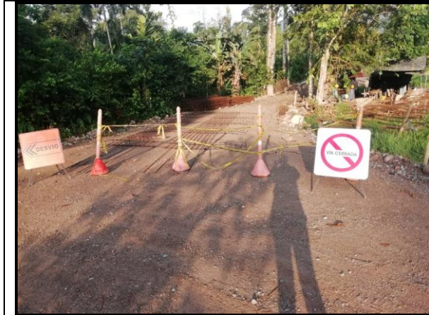
Fotografía 1. Señalización y cierre de la vía.
