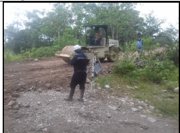
Fotografía 6. Compactación de subrasante.
