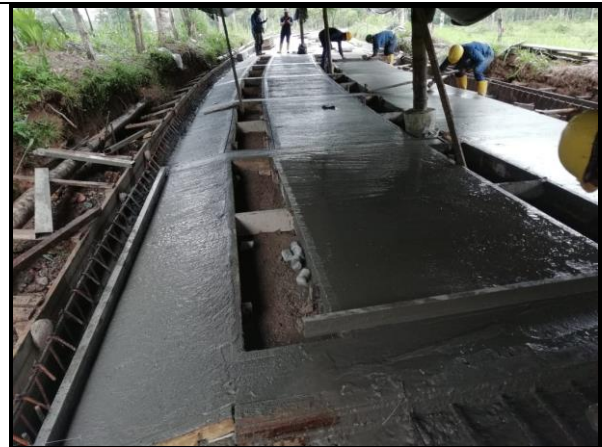
Fotografía 32. Terminado de placa-huella, primera etapa constructiva.
