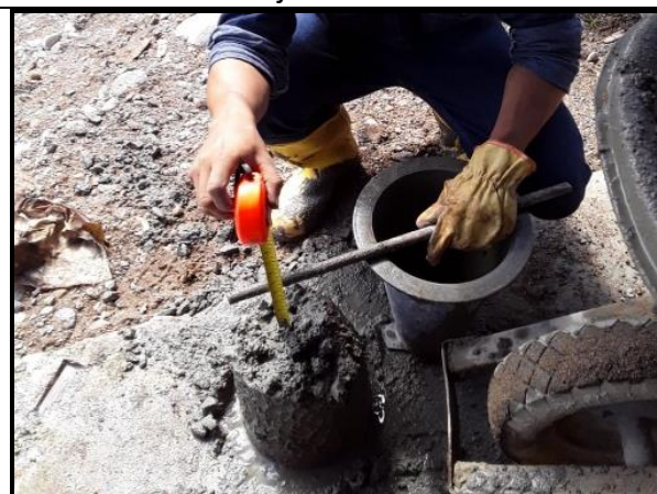
Fotografía 42. Ensayo de asentamiento para el concreto (Slump).
