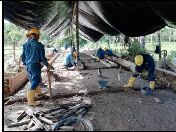
Fotografía 25. Excavación manual.
