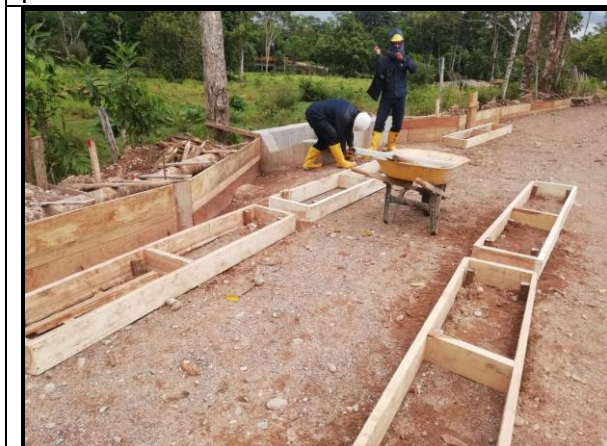
Fotografía 23. Instalación de formaletas para huellas y entrehuellas.
