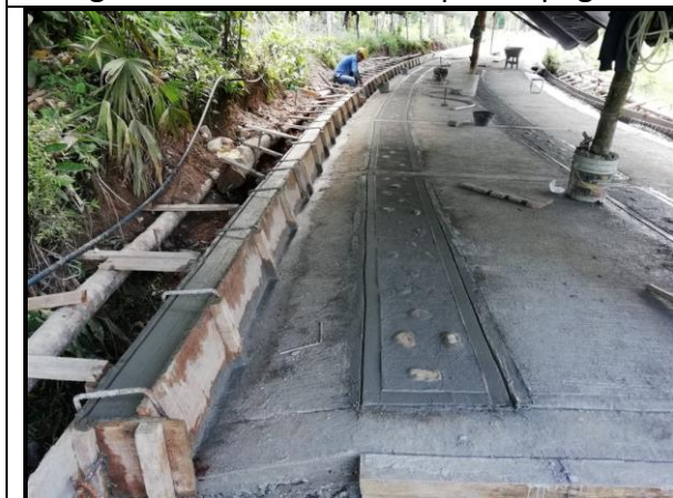
Fotografía 39. Terminado de placa-huella, segunda etapa constructiva.
