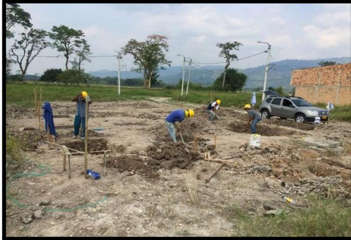
**Imagen 19. Excavaciones varias para fundación**
