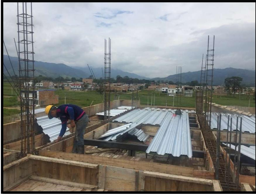
**Imagen 63. Colocación de láminas sobre formaleta**
