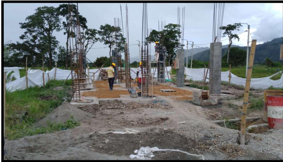
Imagen 56. Mejoramiento de suelo para fundición de losa de contrapiso
