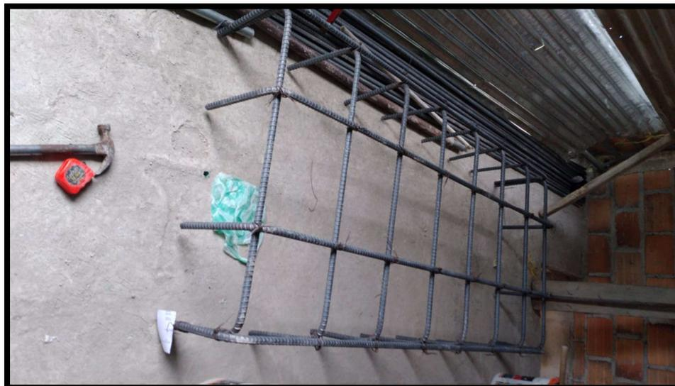
Imagen 30. Armado de zapata C1
