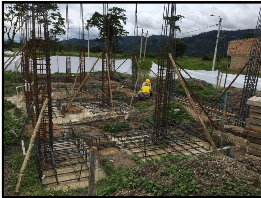
**Imagen 34. Colocación de castillos de acero según diseño**
