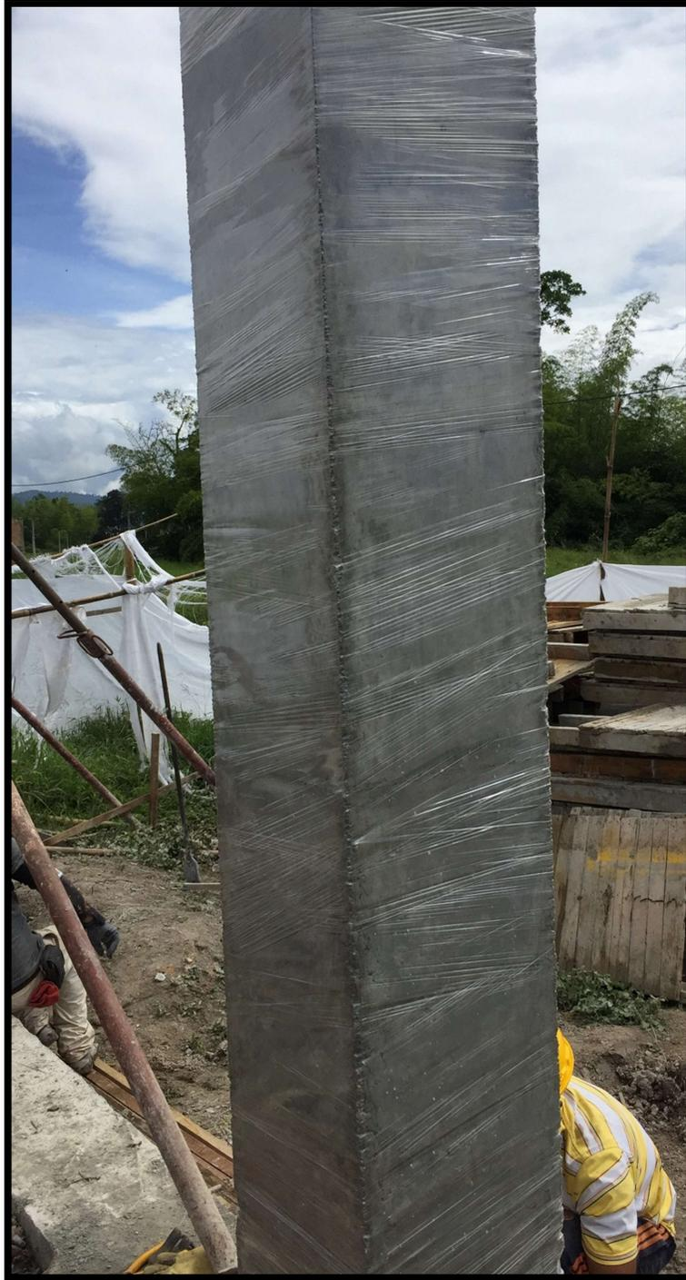
**Imagen 46. Utilización de membranas de polietileno para curado del concreto de columnas**
