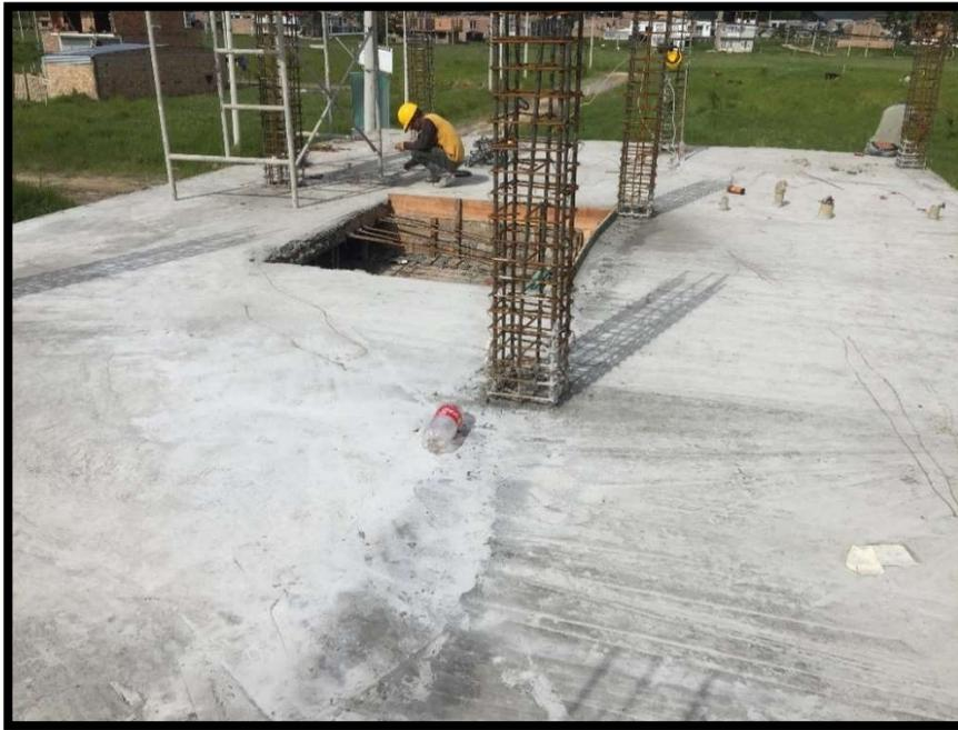
**Imagen 49. Vigas y losa 1 fundidas**
