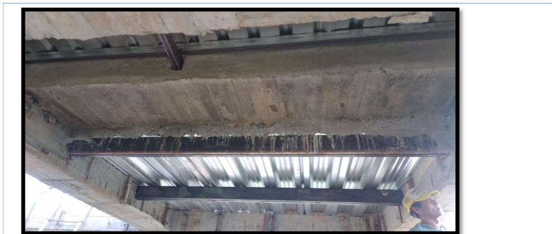
**Imagen 62. Láminas sobre viguetas en acero**
