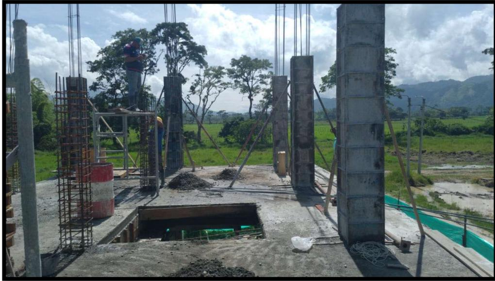
**Imagen 68. Encofrados metálicos para columnas**
