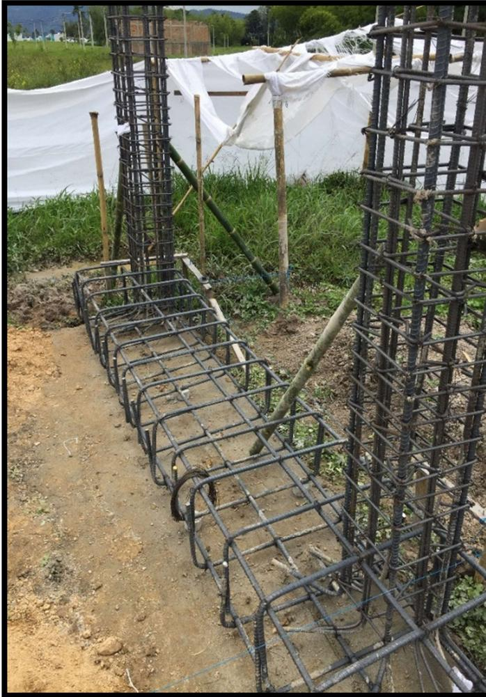
**Imagen 35. Colocación de castillos de acero según diseño**
