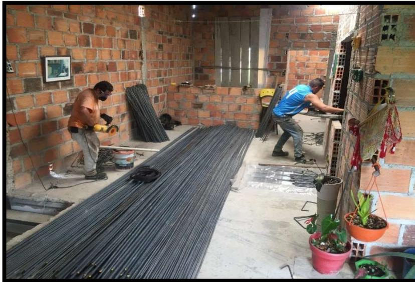
**Imagen 23. Corte de acero de refuerzo**
