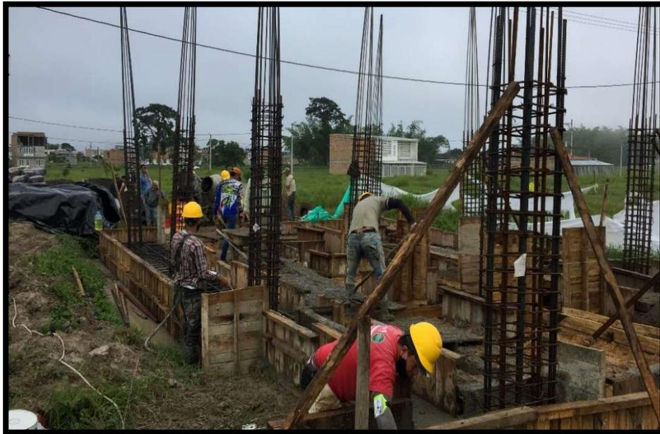
**Imagen 65. Colocación de formaleta para zapatas y vigas de atado**
