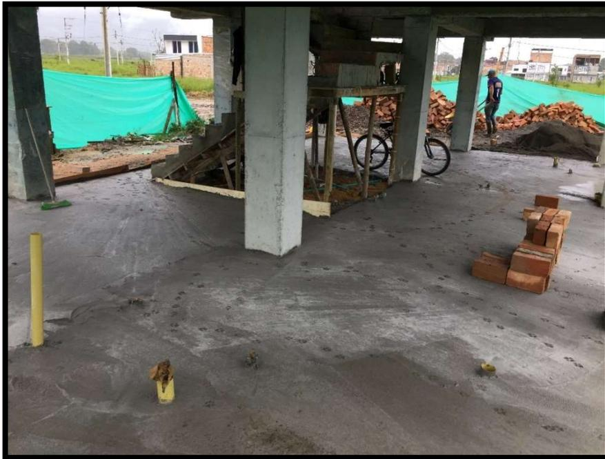
**Imagen 57. Fundición de placa de contrapiso**
