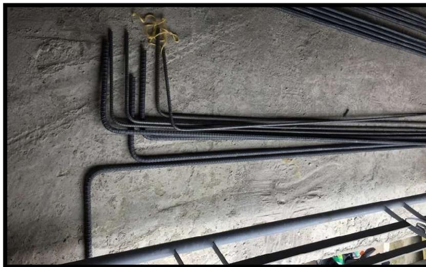
**Imagen 24. Figurado de acero, despiece de columnas**
