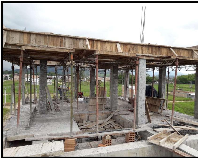
**Imagen 50. Fundición de vigas y losa 1**
