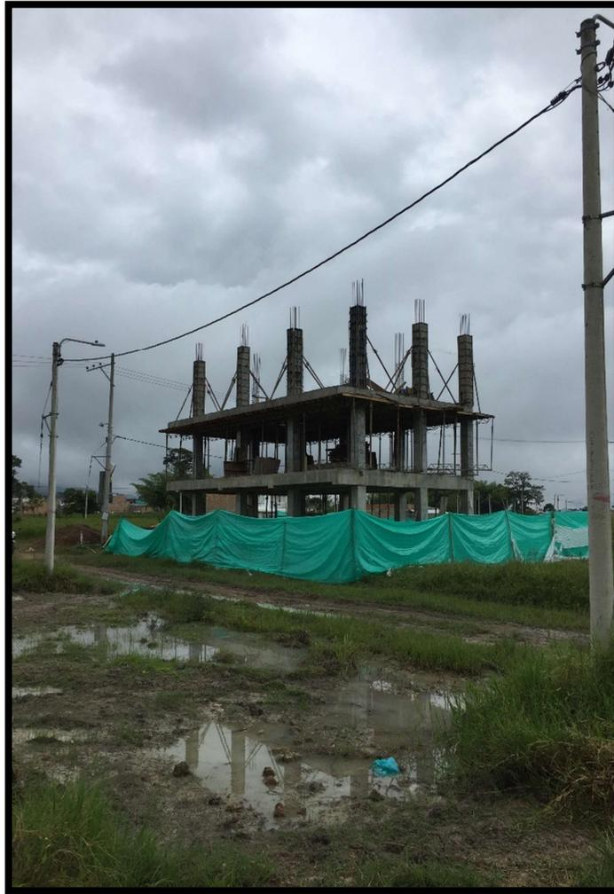
**Imagen 53. Fundición de columnas 3 piso**
