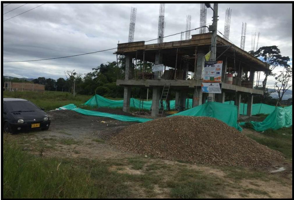
Imagen 52. Fundición de vigas y losa 2
