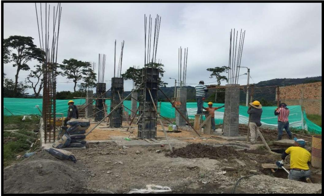
**Imagen 48. Fundición de columnas losa 1**
