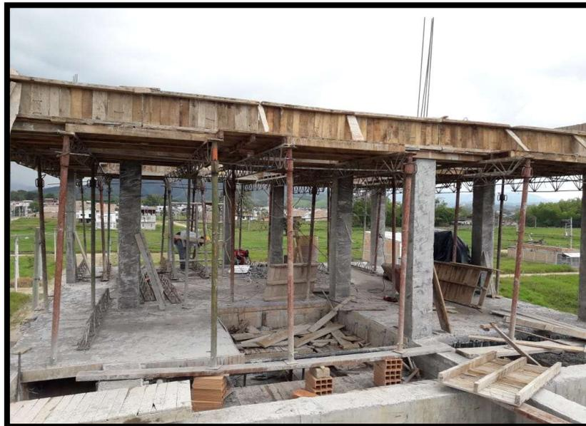
**Imagen 58. Tendido apoyado para losa 1**
