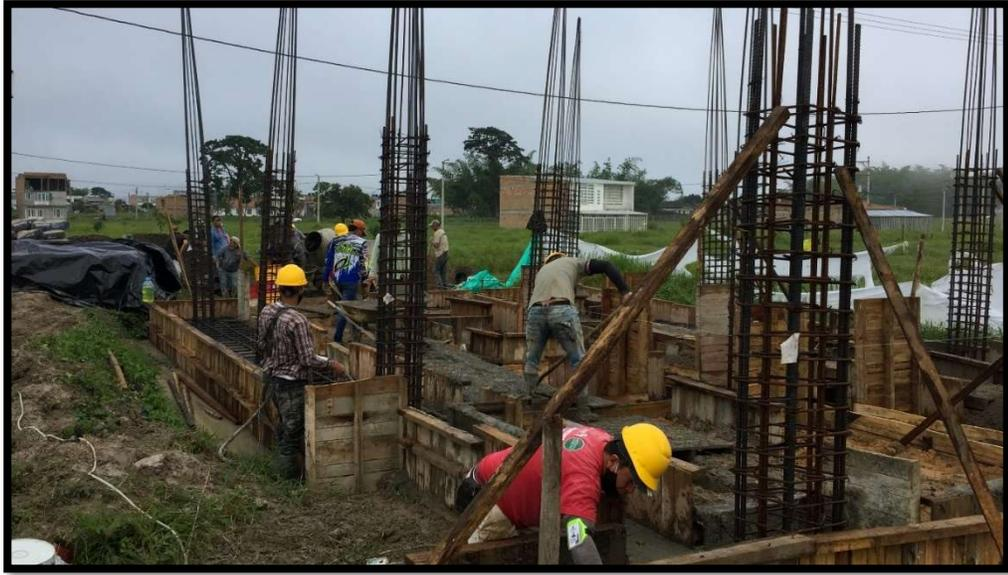
**Imagen 47. Fundición de zapatas y vigas de atado**
