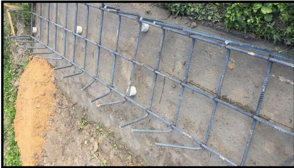
**Imagen 32. Colocación de acero para zapatas en obra sobre separadores en concreto**
