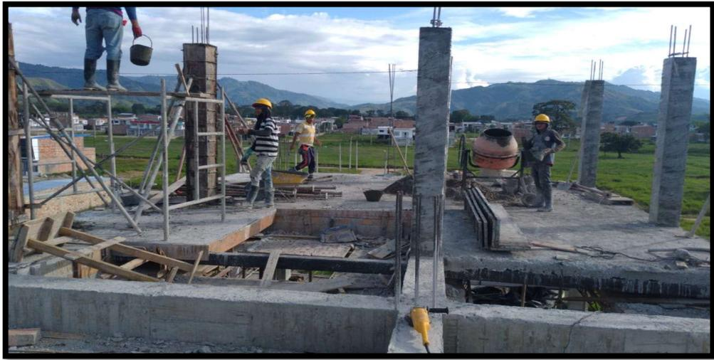
Imagen 51. Fundición de columnas segundo piso
