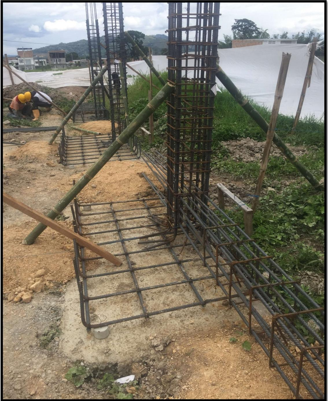
**Imagen 40. Colocación d acero de zapatas, columnas y vigas de atado**
