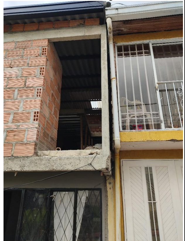
Junta sísmica en segundo nivel.
