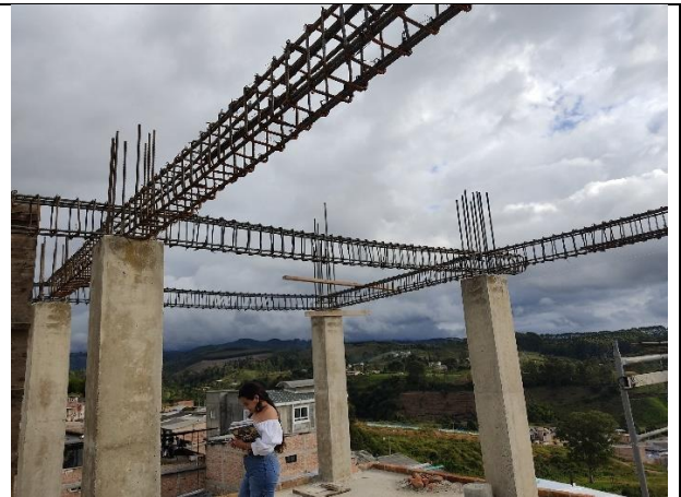
Armado de viguetas para repame en ultimo nivel.
