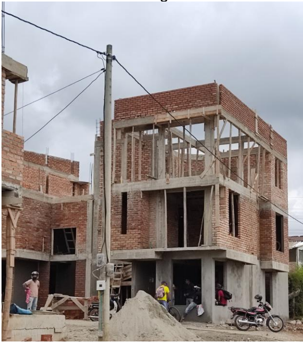
Fachada del lugar visitado.
