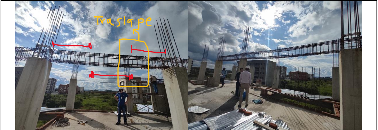
Sótano con muros sin dilatación con el sistema aporticado, losa en Steel Deck.
