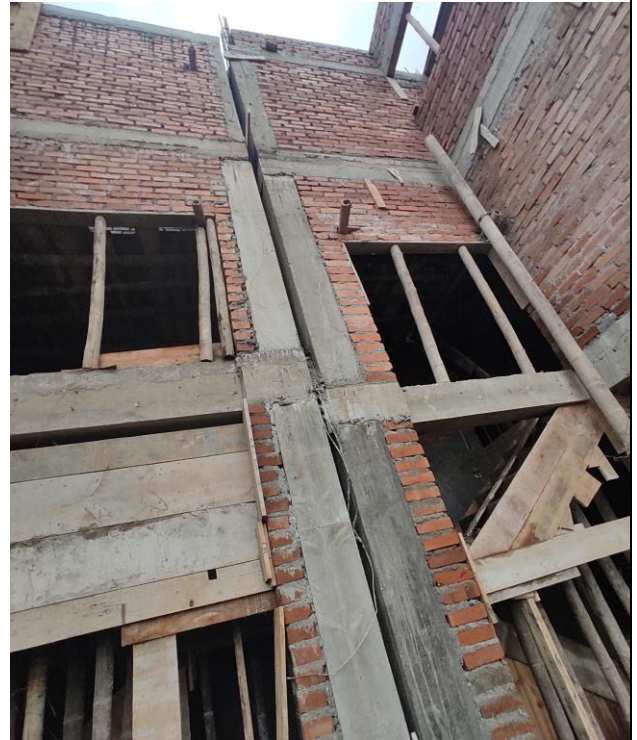
Junta sísmica de las viviendas.
