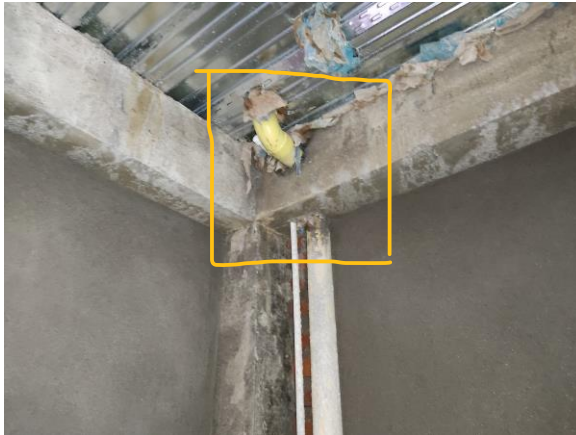
Secciones estructurales intervenidas con tubería sanitaria.
