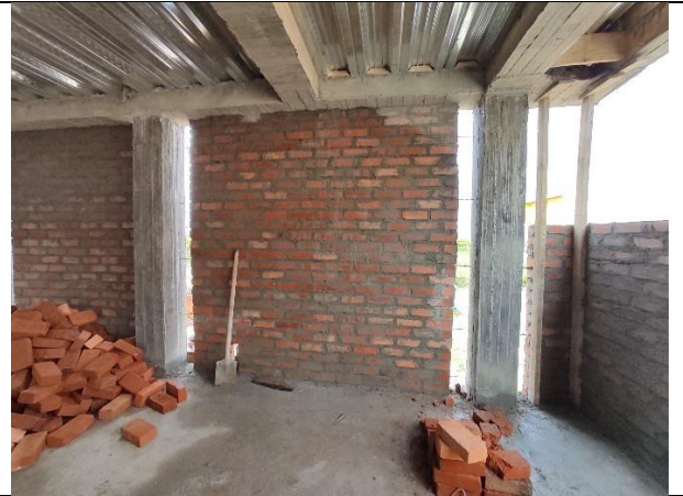
Muros en primer nivel dilatados y fijados con pernos al sistema resistente.
