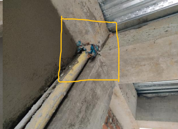
Secciones estructurales intervenidas con tubería sanitaria.
