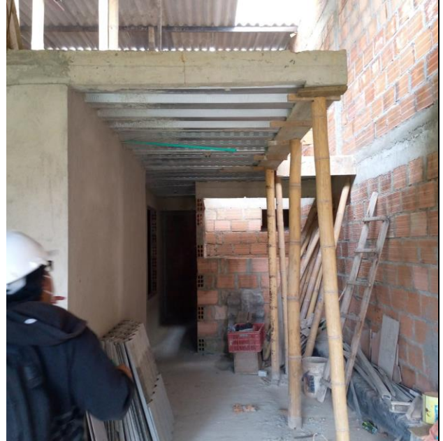
Voladizo de 1.5m con Steel Deck soportado con guadua.
