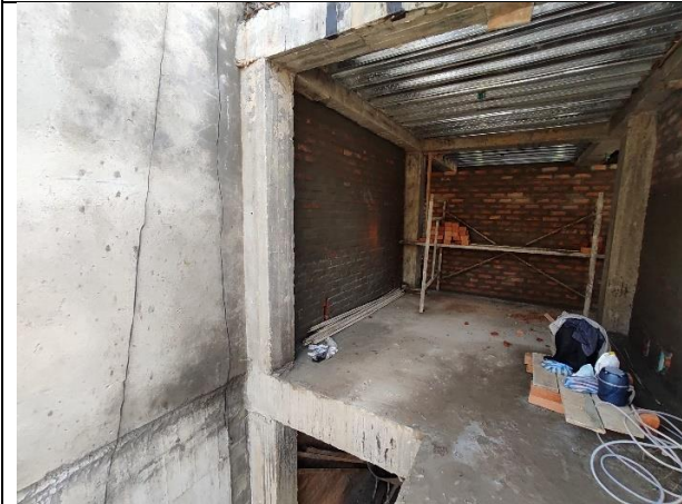
Columna compartida con la casa colindante del costado derecho.
