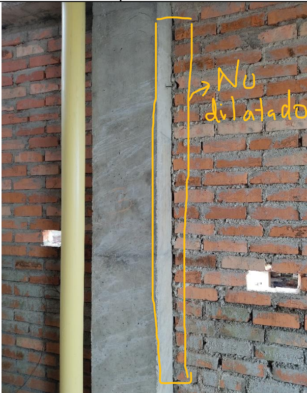
Las secciones estructurales principales se respetan ni son intervenidas por tuberia.
