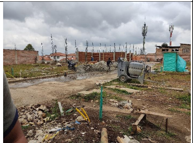
Avance de obra.
