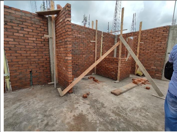
Muros del primer nivel, con buitrones para ocultar tuberías.
