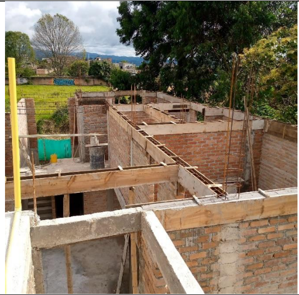
Distribucion de muros estructurales aproximadamente equivalente en ambas direcciones en segundo nivel
