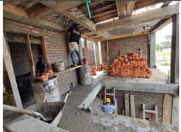
Vacio para gradas y sistema estructural visible, los aen lamina colaborante.
