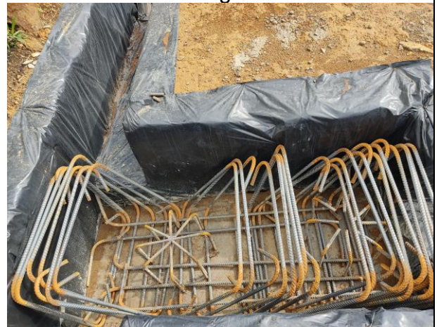
Acero de refuerzo para cabezal poligonal.
