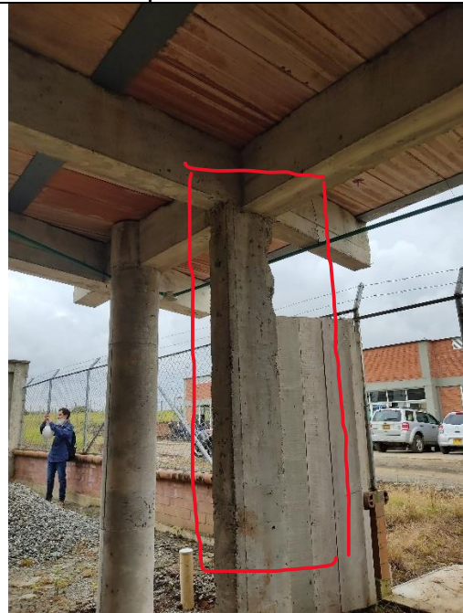
Sección muy esbelta soportando gran afección de cargas.
