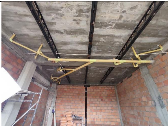
Losa de entepiso con cerchas metálicas
