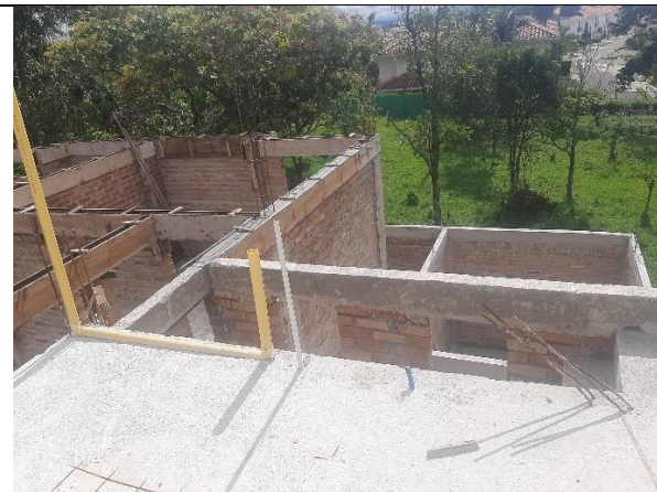
Muros estructurales en segundo nivel
