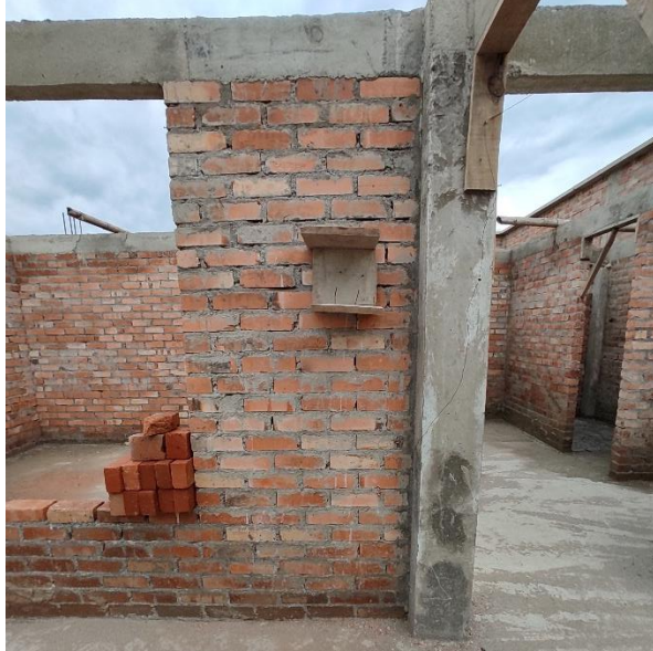
Secciones reducidas del sistema porticado
