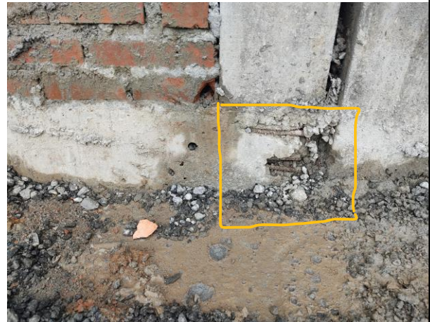
Hormigqueo en base de secciones estructurales.
