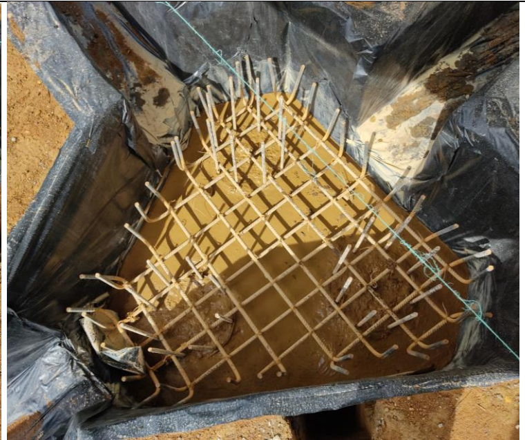
Otra sección de la cimentación está en proceso de armado para cabezales.
