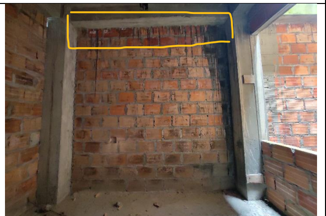
Muros sin dilatar con respecto al sistema porticado.
