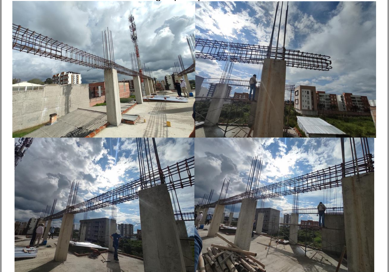
Armado de vigas principales del tercer nivel.
