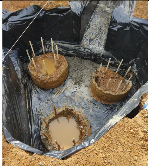
Acero de refuerzo para cabezal rectangular.
