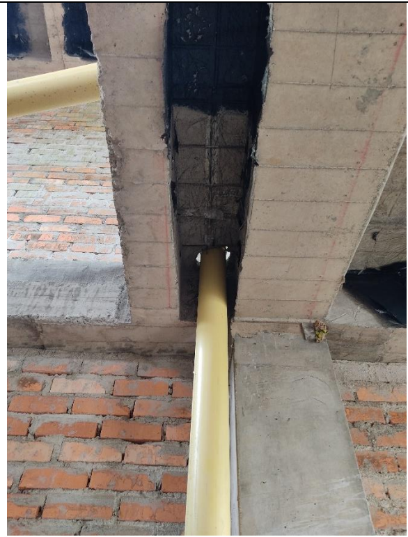
Las secciones estructurales principales se respetan ni son intervenidas por tuberia.
