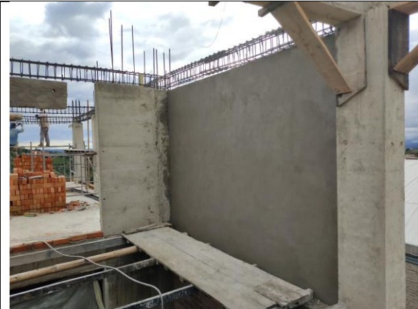
Pantalla en concreto y muro repellado en mortero.
