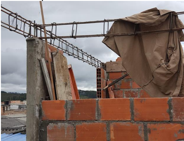
Estribos muy separados en aproximadamente 35 cm.
