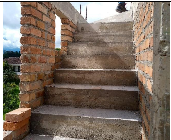
Escaleras para ingreso a segundo nivel.
