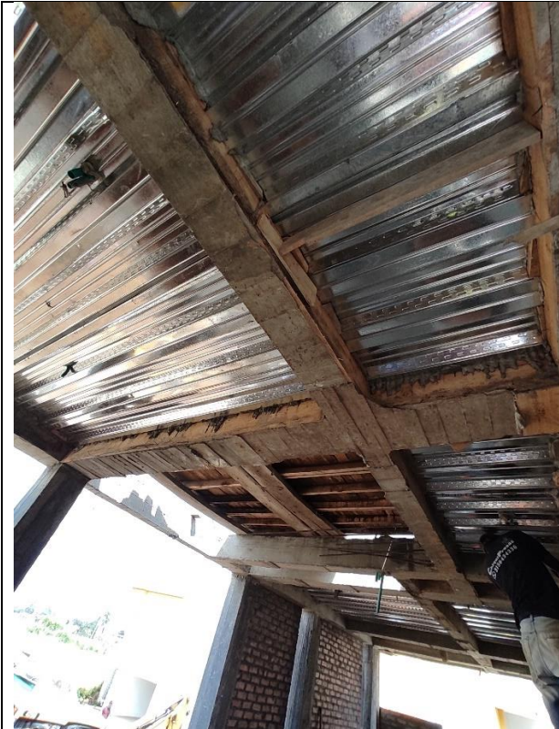
Losa en la mina colaborante.
