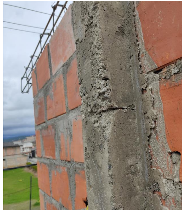
Presencia de hormigueos en columnas con secciones de 13cm x 20cm.
