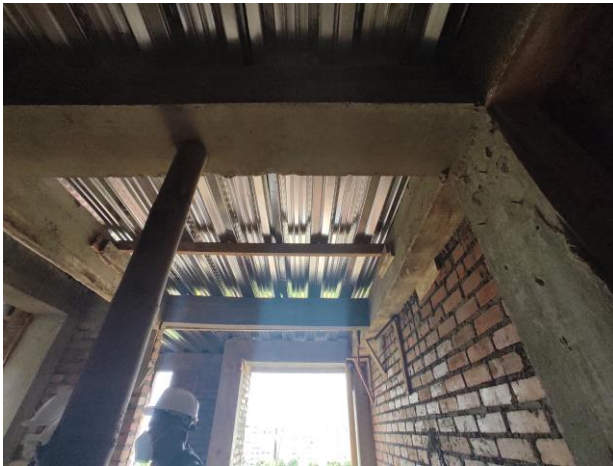
Losa en Steel Deck
