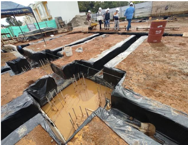
Acero de refuerzo para cabezal poligonal.
