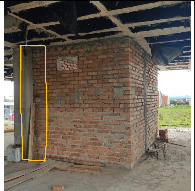
Muros no estructurales no dilatados del sistema porticado.
