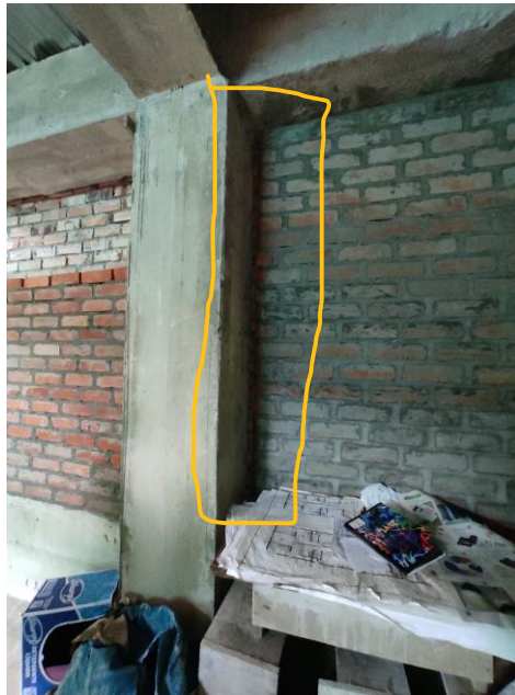
Sótano con muros sin dilatación con el sistema aporticado, losa en Steel Deck.
