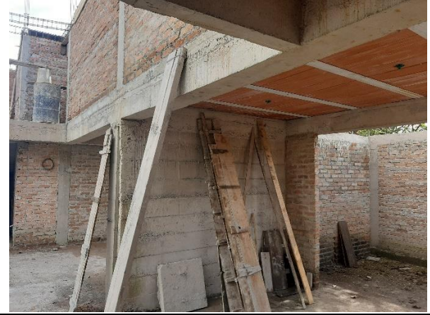
Muro en concreto reforzado en primer piso.
