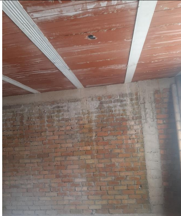
Losas de entrepiso aligerada en bloquelon.
