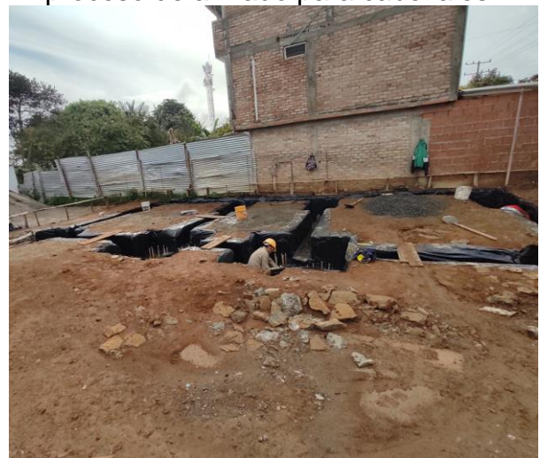
Otra sección de la cimentación está en proceso de armado para cabezales.
