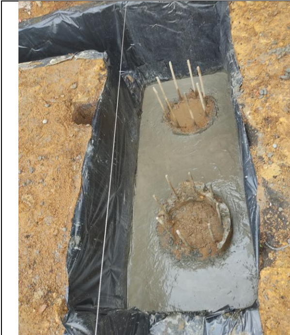
Cabezales centrales de la cimentación.
