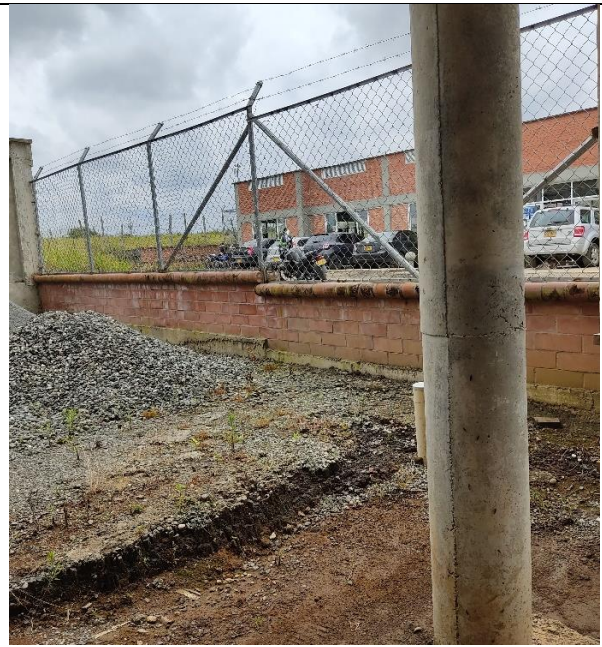
Cerramiento en reja metalica y ladrillo.
