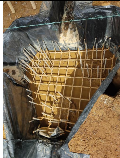
Conjunto de pilotes sin cabezal.
