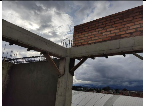
Viguetas y muros en ladrillo macizo para remates de la estructura.
