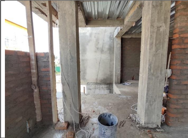
Columnas del sistema porticado.
