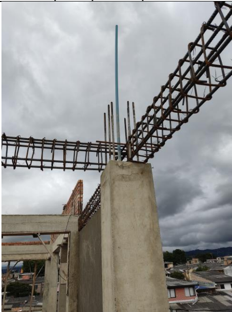
Armado de acero remate de la estructura en viguetas.
