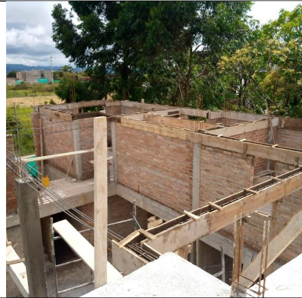
Distribucion de muros estructurales aproximadamente equivalente en ambas direcciones en segundo nivel
