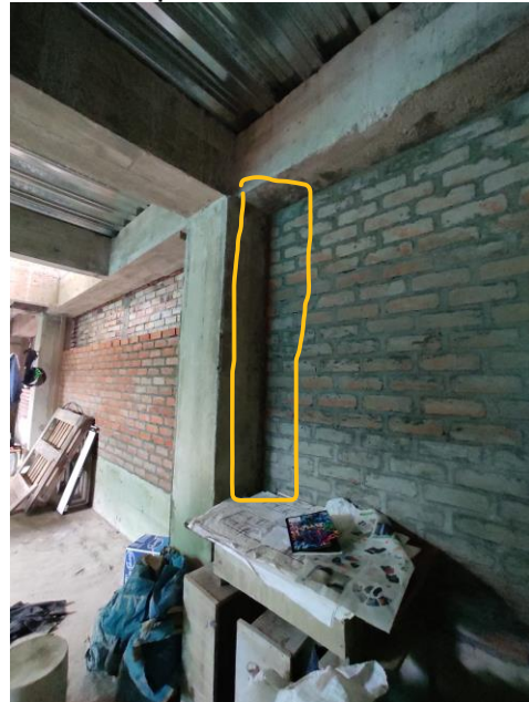
Sótano con muros sin dilatación con el sistema aporticado, losa en Steel Deck.
