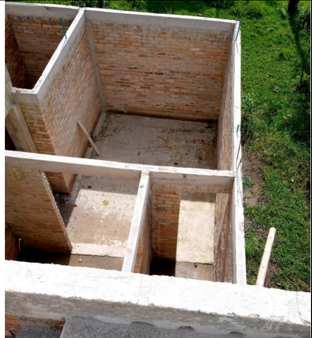
Muros estructurales en parte trasera.
