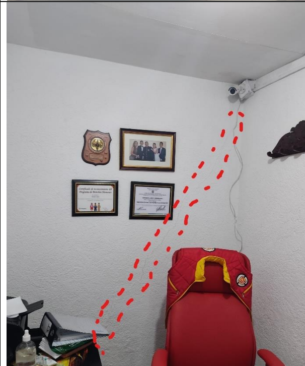
Muros internos y externos afectados por los asentamientos
