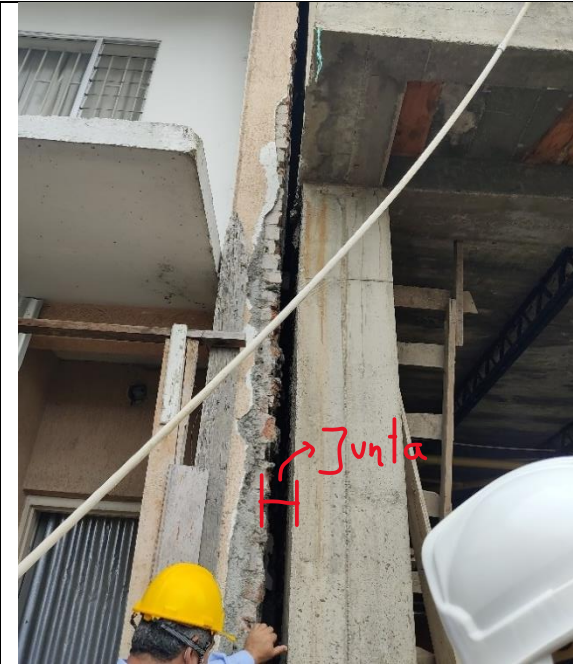
Junta sismica de aproximadamente 10cms
