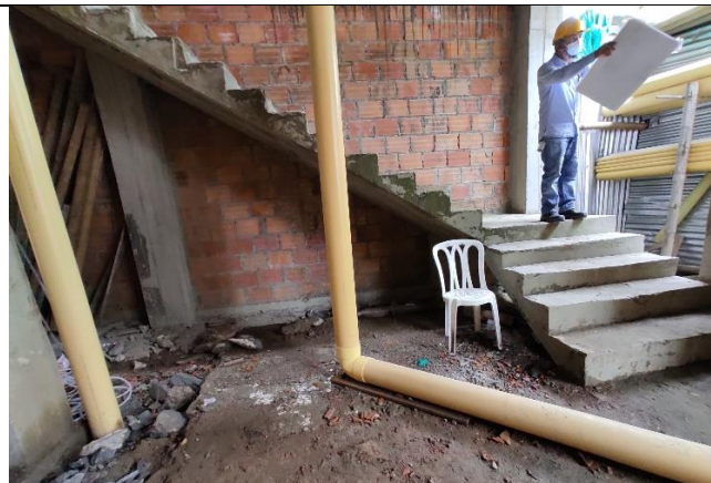
Escaleras modificadas hacia el segundo nivel.
