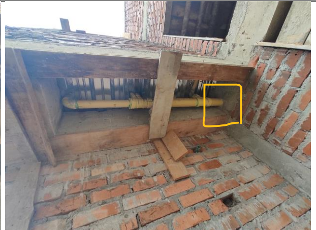
Hormigqueo en base de secciones estructurales.
