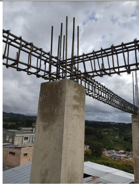
Armado de acero remate de la estructura en viguetas.
