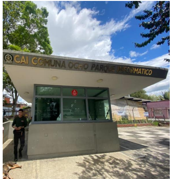
Imagen 22. Revestimiento en pintura y estuco CAI Comuna 8 Parque Informático
