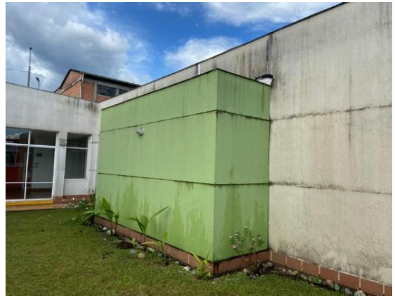
Imagen 37. Cubierta plana y humedad revestimiento plástico.
