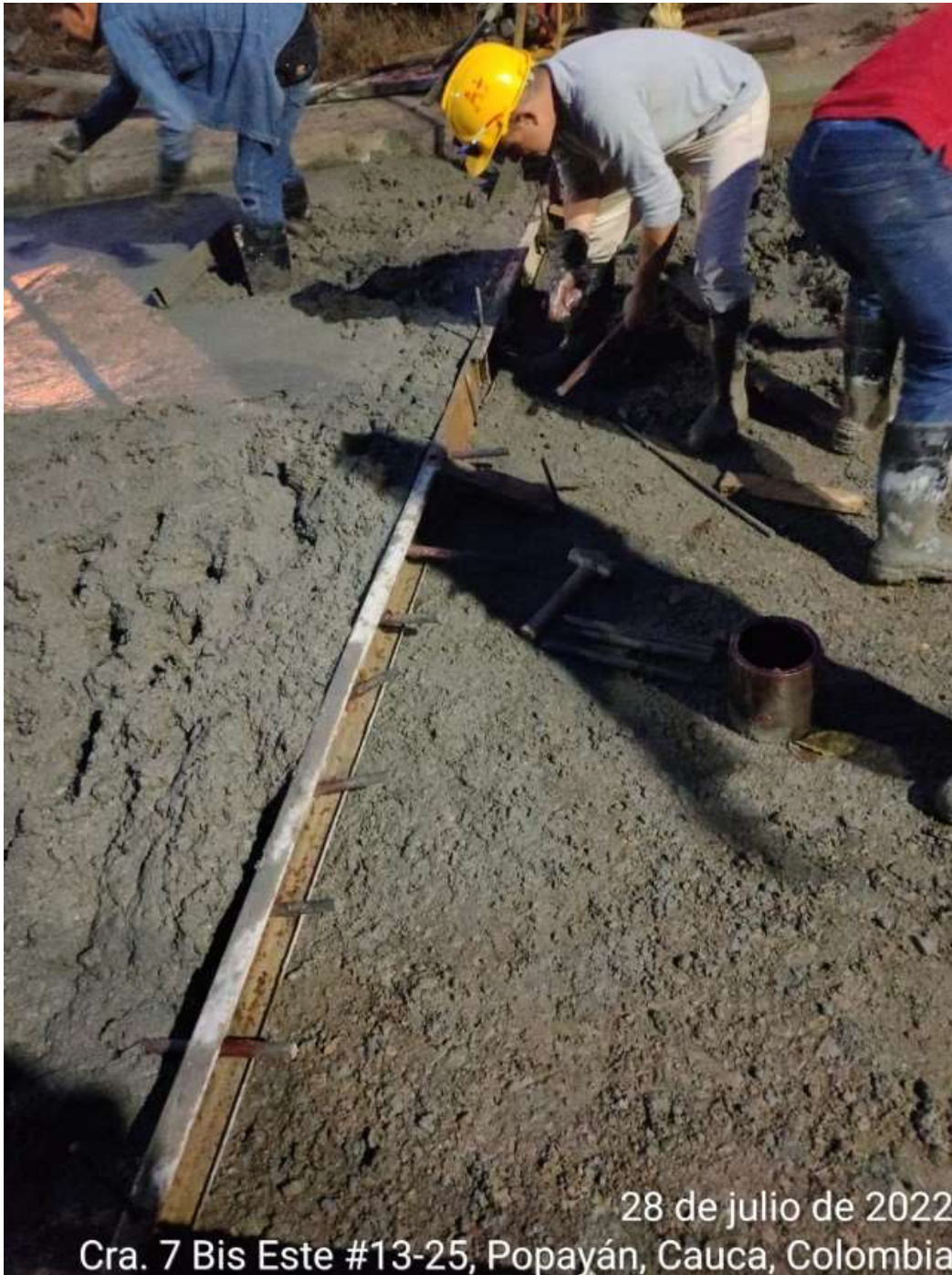
Imagen 28. Junta de construcción
