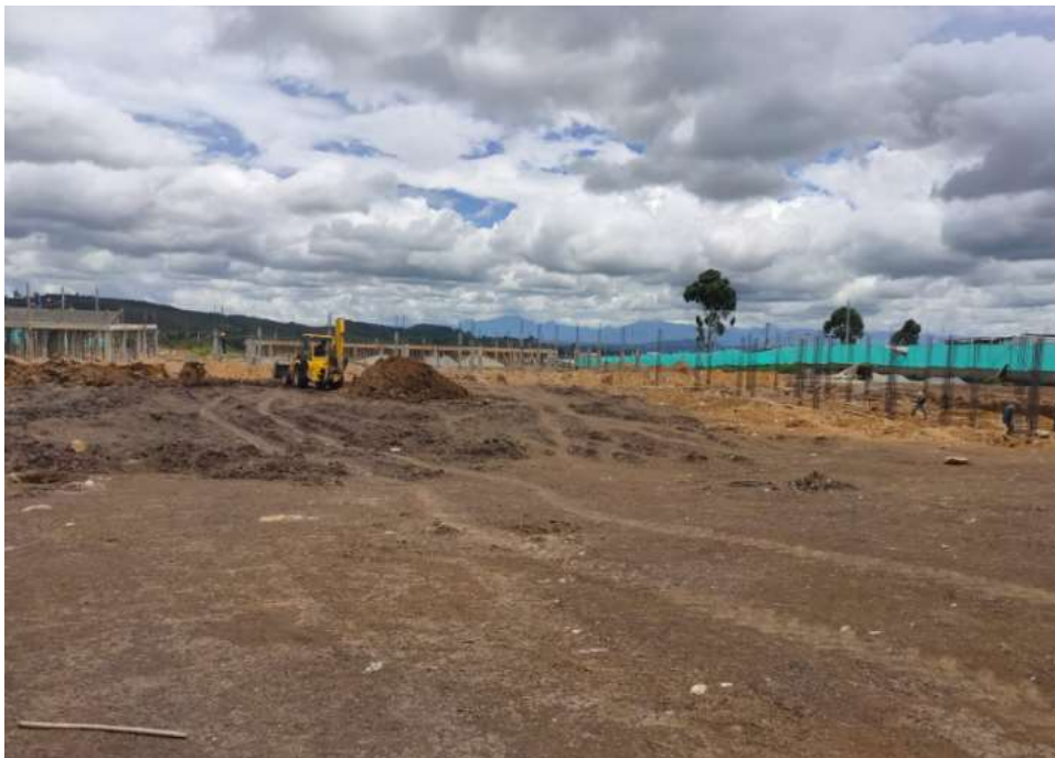
Imagen 13. Descapote y excavación en el refugio animal
