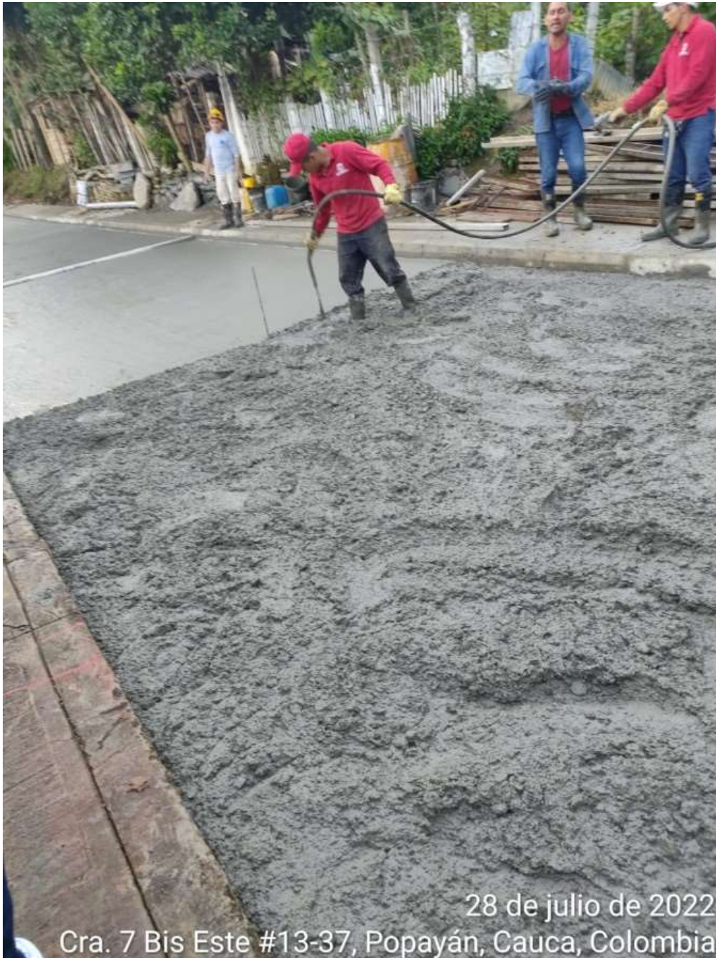
Imagen 25. Vibrado del concreto
