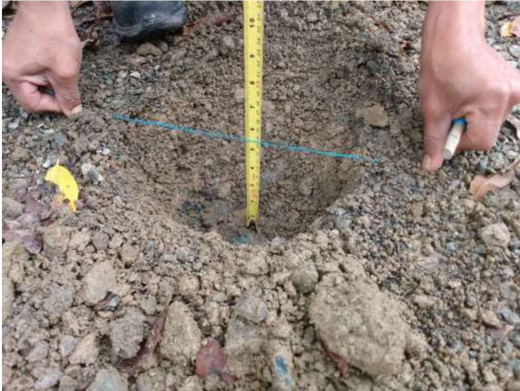
Imagen 19. Verificación de espesores de las capas del andén
