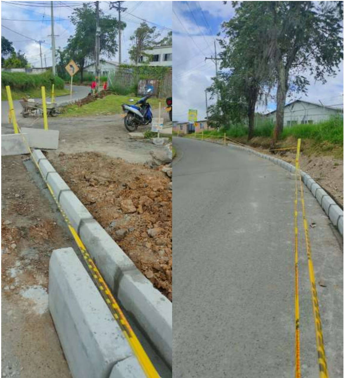
Imagen 18. Descapote y colocación de sardineles
