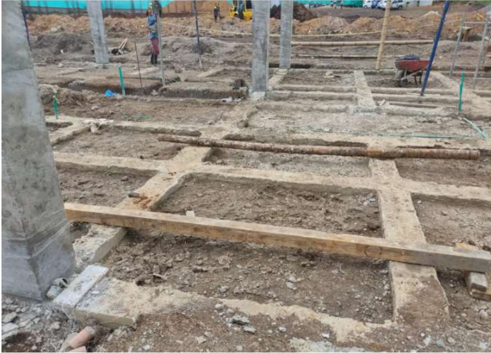
Imagen 16. Avance de obra bloque de felinos
