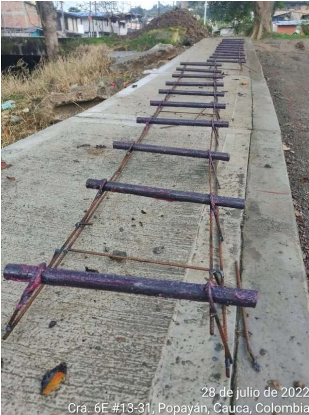
Imagen 24. Verificación de la grasa en las barras lisas en las juntas de contracción
