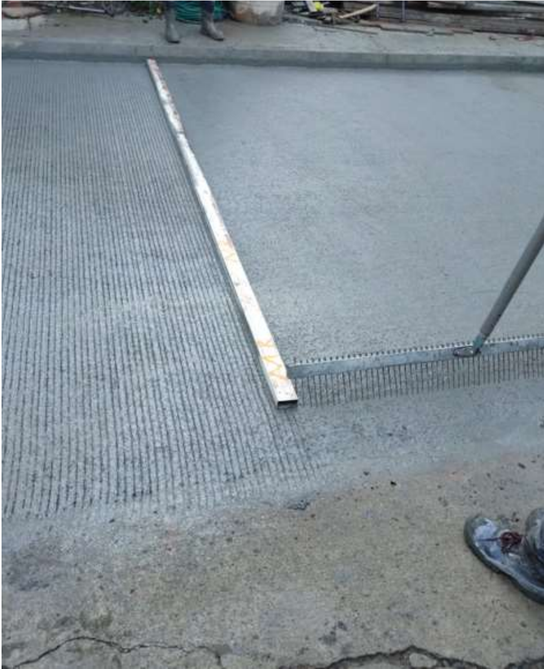
Imagen 26. Nivelación y texturizado del concreto
