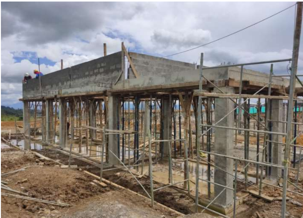
Imagen 17. Avance de obra bloque de equinos
