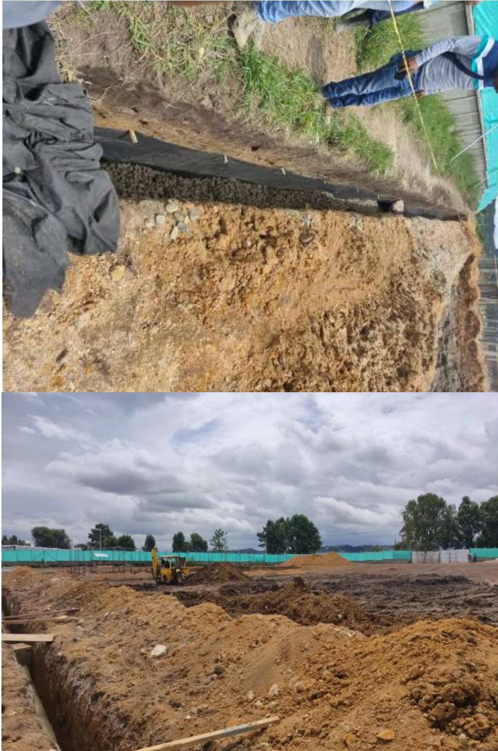
Imagen 14. Dren con geotextil y material granular
