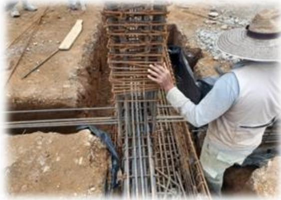
Figura 43: Proceso constructivo cabezal CA5.
