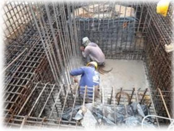
Figura 63: Proceso armado de pantalla perimetrales foso
