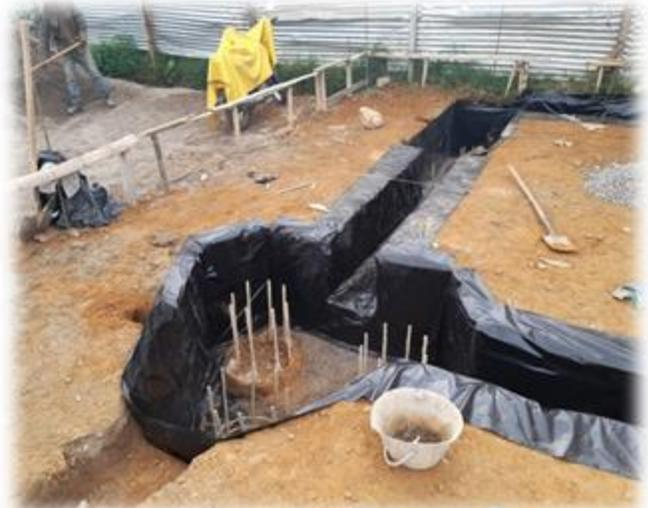
Figura 22: Proceso de instalación del plástico
