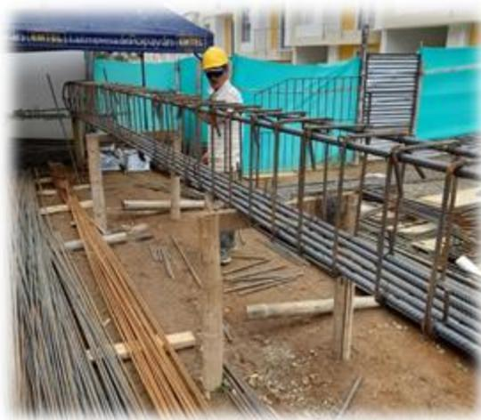
Figura 33: Armado viga cimentación
