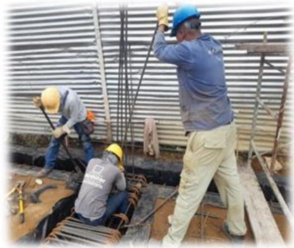
Figura 50: Proceso armado columnas y de cabezal simultáneamente.
