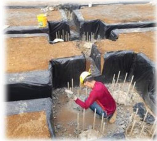
Figura 26: Fundición de solado.
