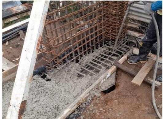
Figura 84: Vibración del concreto.
