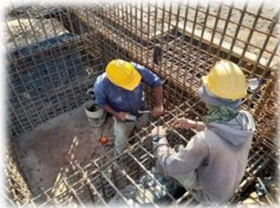
Figura 61: Proceso armado de pantalla perimetrales foso
