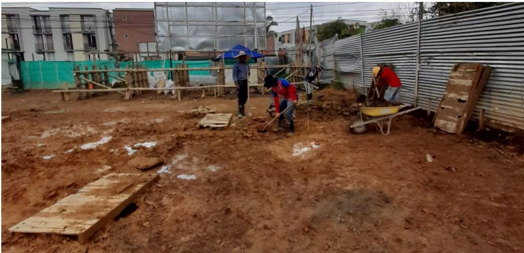
Figura 99: Proceso de limpieza y nivelación del terreno.
