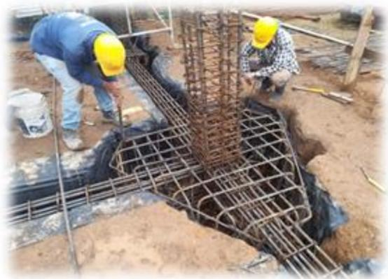
Figura 37: Proceso constructivo cabzal CA3.
