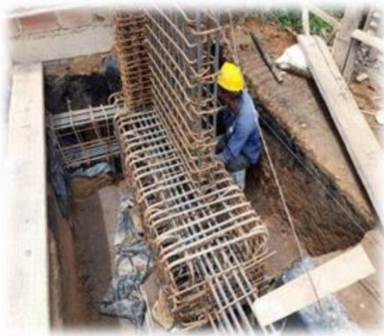
Figura 57: Proceso armado de pantalla A, D
