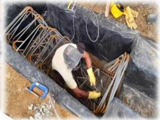
Figura 40: Proceso constructivo cabezal
