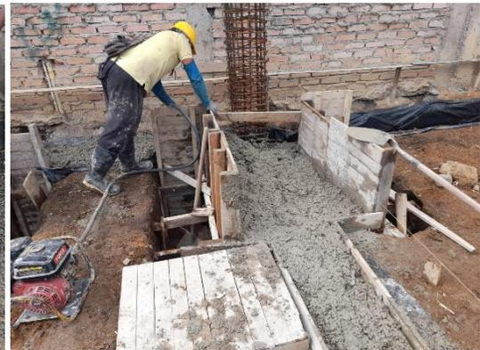
Figura 90: Proceso de vibrado.
