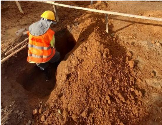
Figura 91: Excavación para cambio de ubicación de tubería.
