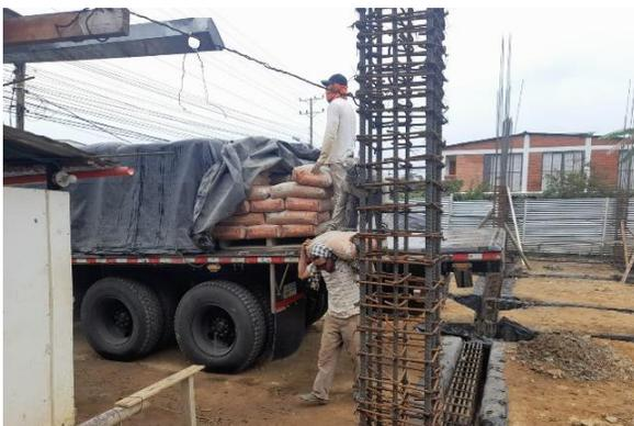
Figura 106: Descargue de cemento
