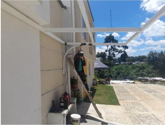
Figura 100: Proceso armado e instalación cubierta externa.
