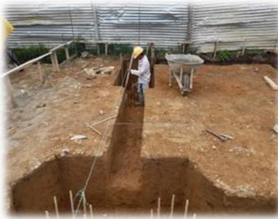
Figura 17: Proceso de excavación
