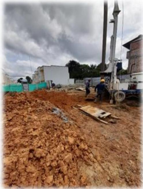
Figura 11: Perforación pilotaje.
