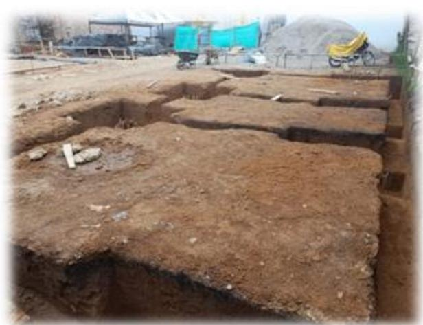
Figura 20: Proceso de excavación
