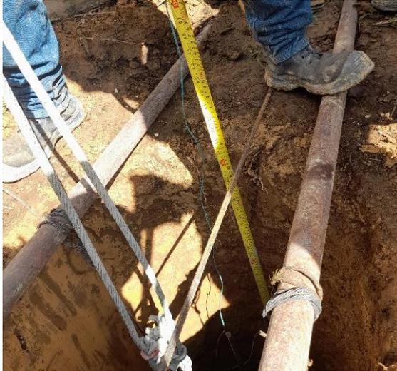
Figura 77: Proceso de llevar a nivel el acero del pilote.
