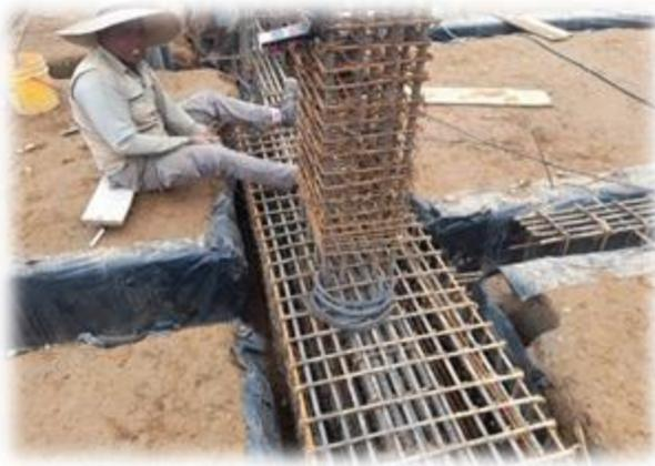
Figura 39: Proceso constructivo cabezal CA4.
