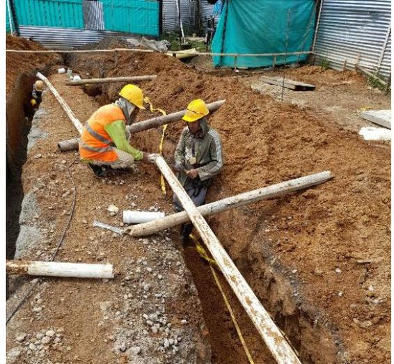
Figura 94: Cambio de tubería.
