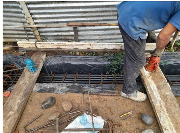
Figura 60 Proceso elevación con gatos
