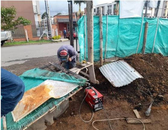
Figura 104: Proceso armado reparación y refuerzo cerramiento.
