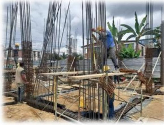
Figura 53: Proceso armado de columna.
