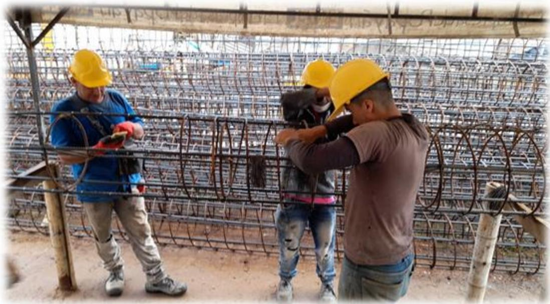
Figura 28: Proceso de armado del acero de refuerzo del pilote.
