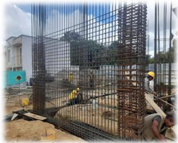
Figura 58: Detalle Armado de pantalla 3, 4
