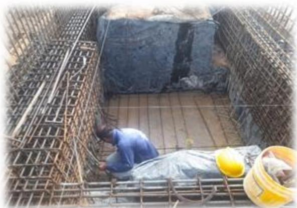
Figura 62: Detalle Armado losa del foso
