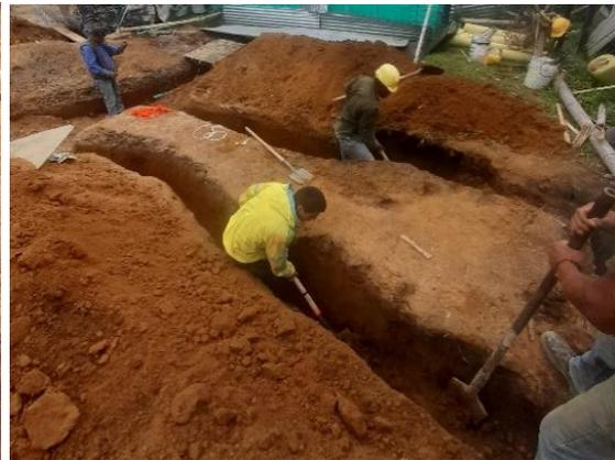
Figura 92: Excavación para cambio tubería agua, energía y gas.
