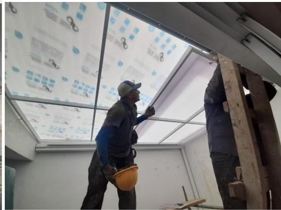
Figura 103: Proceso instalación cubierta interna.
