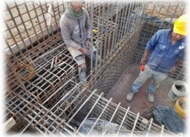
Figura 64: Detalle Armado losa del foso
