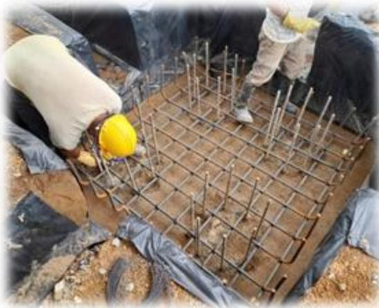
Figura 41: Proceso constructivo cabezal CA6.
