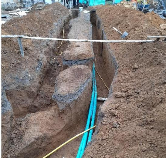
Figura 93: Cambio de tubería.
