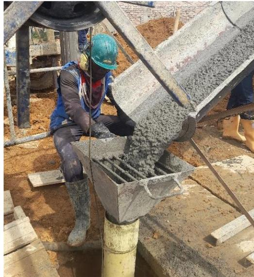
Figura 76: Proceso de fundición manual.
