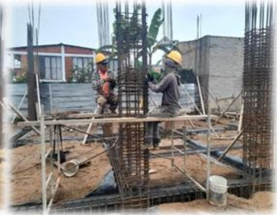
Figura 54: Proceso armado columnas.
