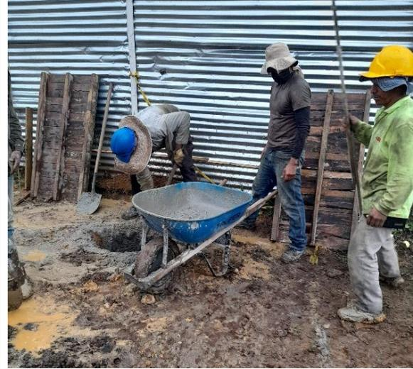
Figura 78: Concreto excedente de la fundición del pilote.
