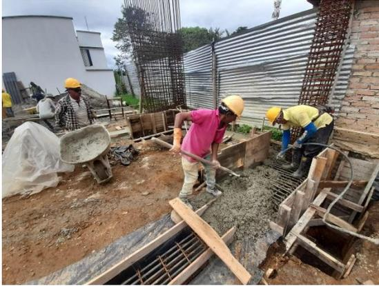
Figura 85: Vaciado del cabezal.
