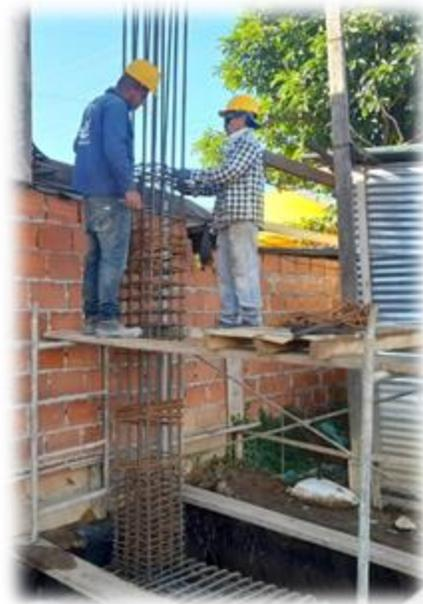
Figura 52: Proceso armado columnas.
