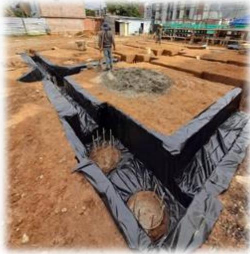
Figura 21: Proceso de instalación del plástico
