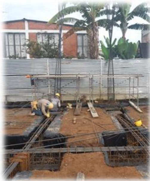
Figura 51: Proceso armado de columna y simultáneamente se arma viga.
