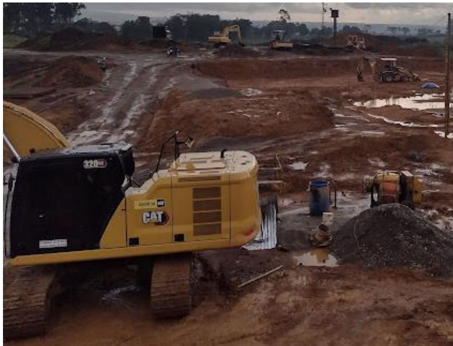
Ilustración 17. Vista de maquinaria disponible en la obra.
