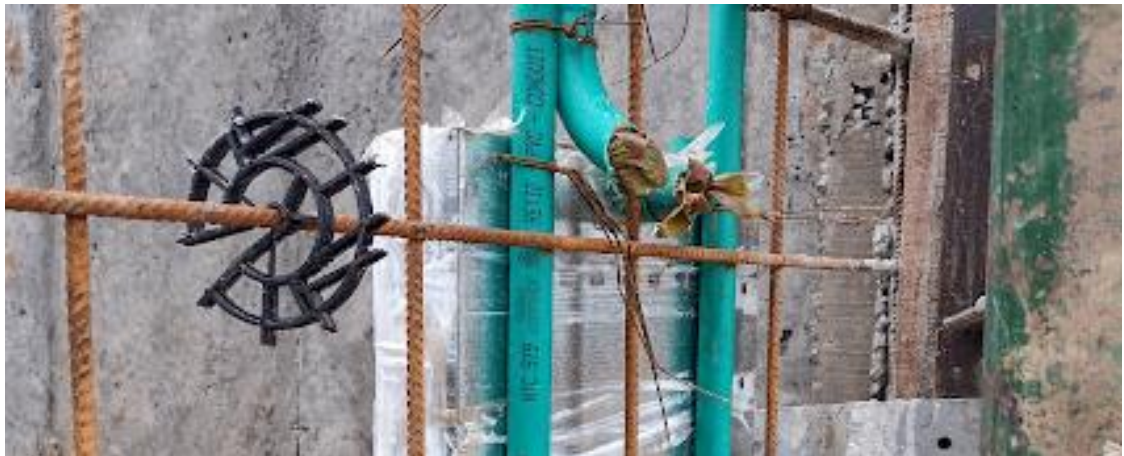
Ilustración 83. Rueda de posicionadora de polipropileno.
