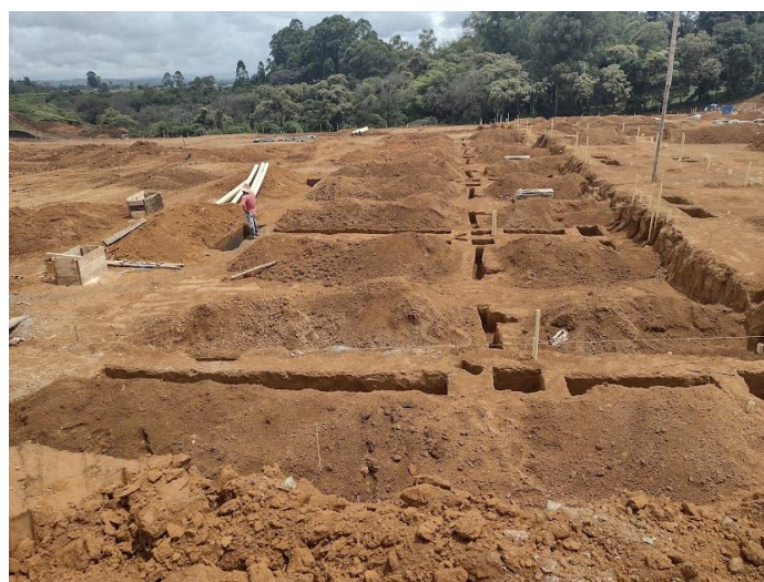
Vista de la manzana 3, instalación de las casas 132 a la 138.
