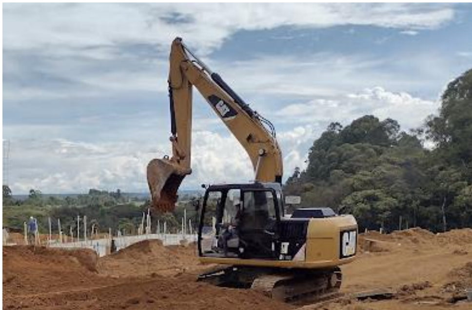
Ilustración 41. Excavadora Caterpillar 312 D2 GC.
