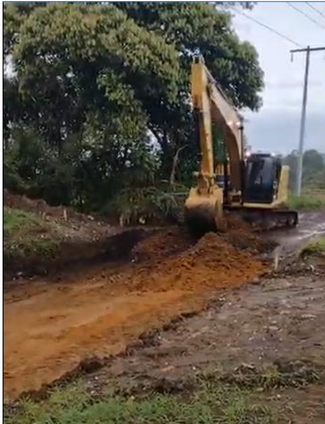
Vía de acceso al proyecto Calle 63 Norte.
