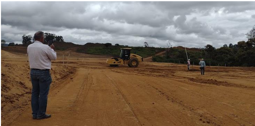
Ilustración 22. Inspección zona relleno.
