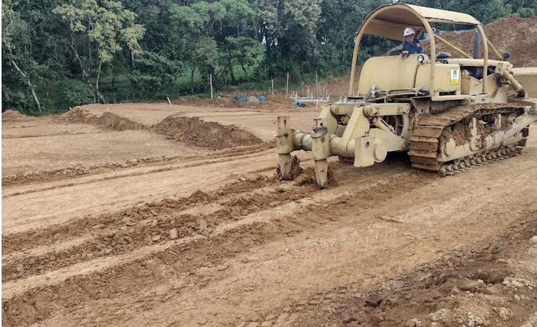
Escarificación pacha de casas 40-41 y 92-93 de la manzana 2 – 2ª.
