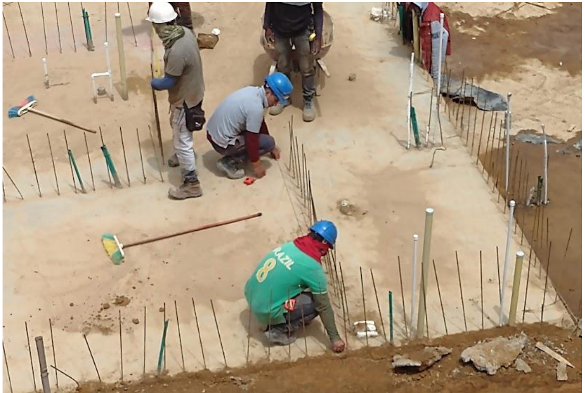
Ilustración 76. Proceso de cimbra sobre la losa de cimentación.
