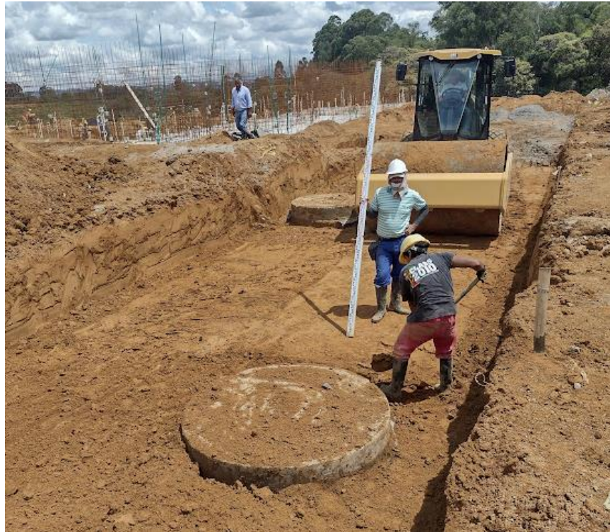
Vista de recamara Pluvial P1 en seriado de Vía interna 1.
