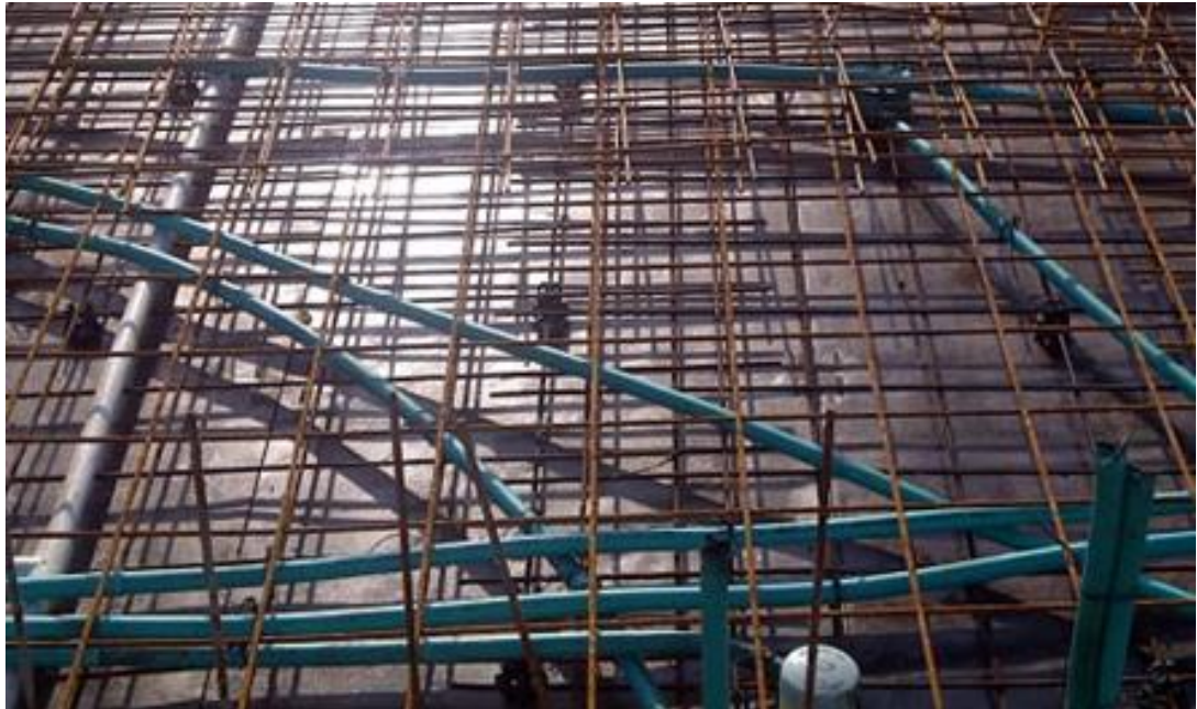
Ilustración 82. Distanciador canastilla plástico.
