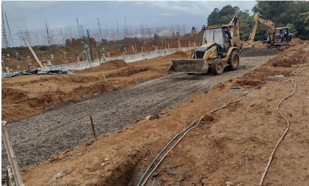
Riego de material de Sub Base Vía 1 interna.
