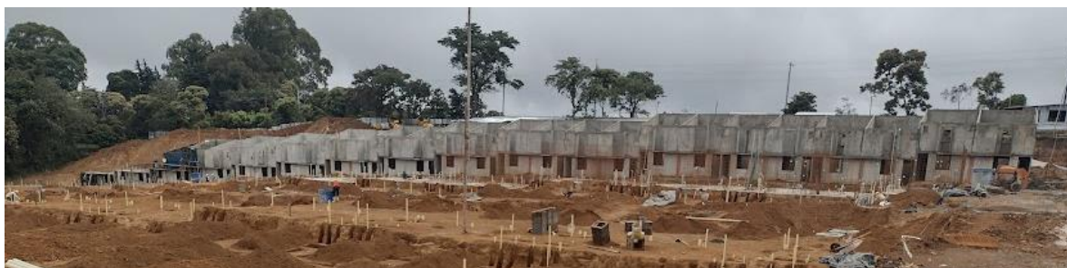
Avance de fundición de estructuras de primer y segundo piso en la manzana 1.
