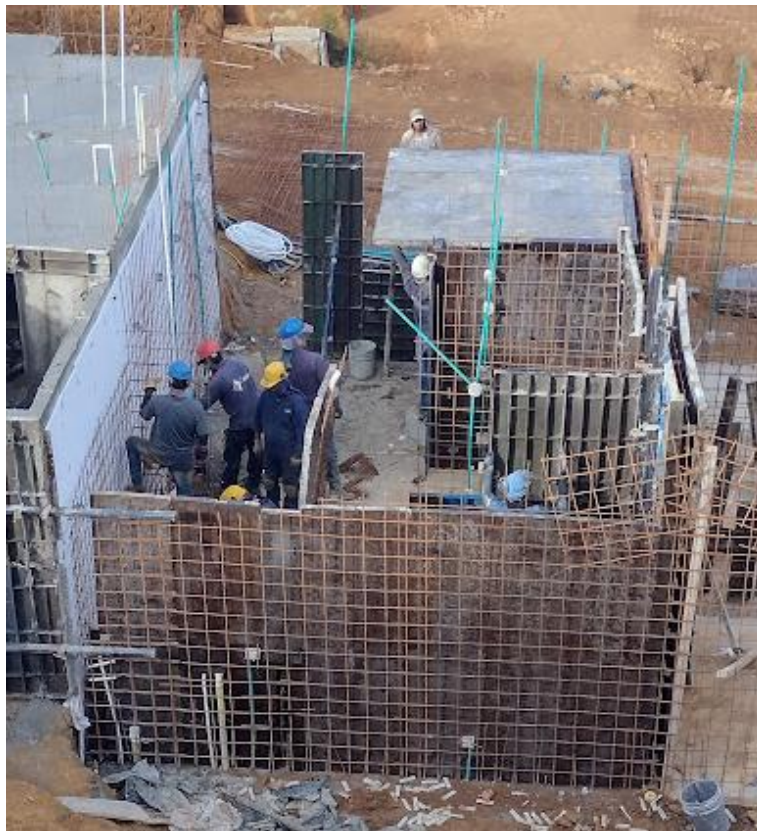
Vista instalación de formaletas primer piso casa 24 manzana 1.
