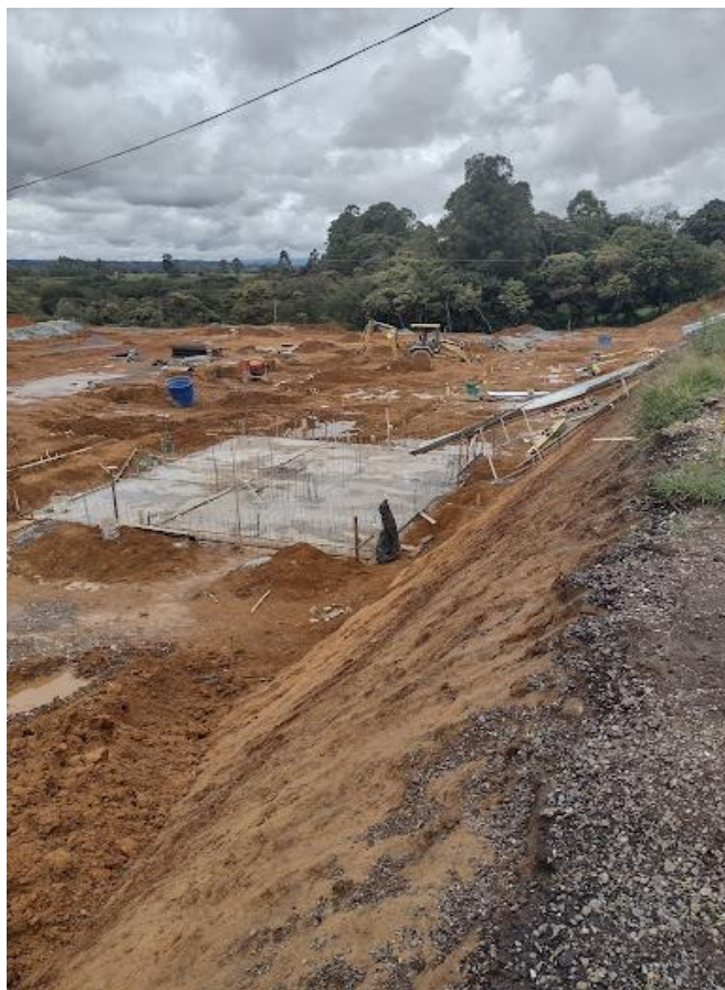
Vista manzana 1 casas 1-1A desde campamento de ingenieros.
