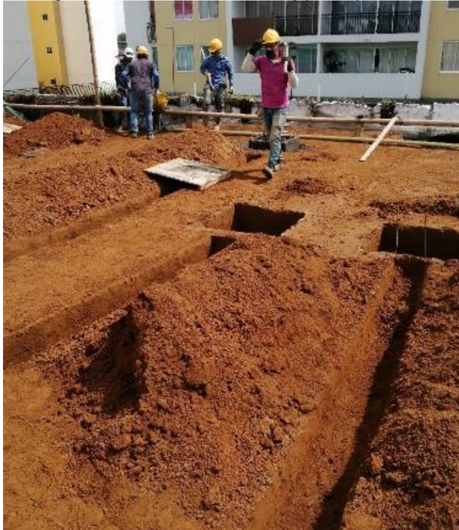
Imagen 24 Excavación red sanitaria y pluvial primer nivel
