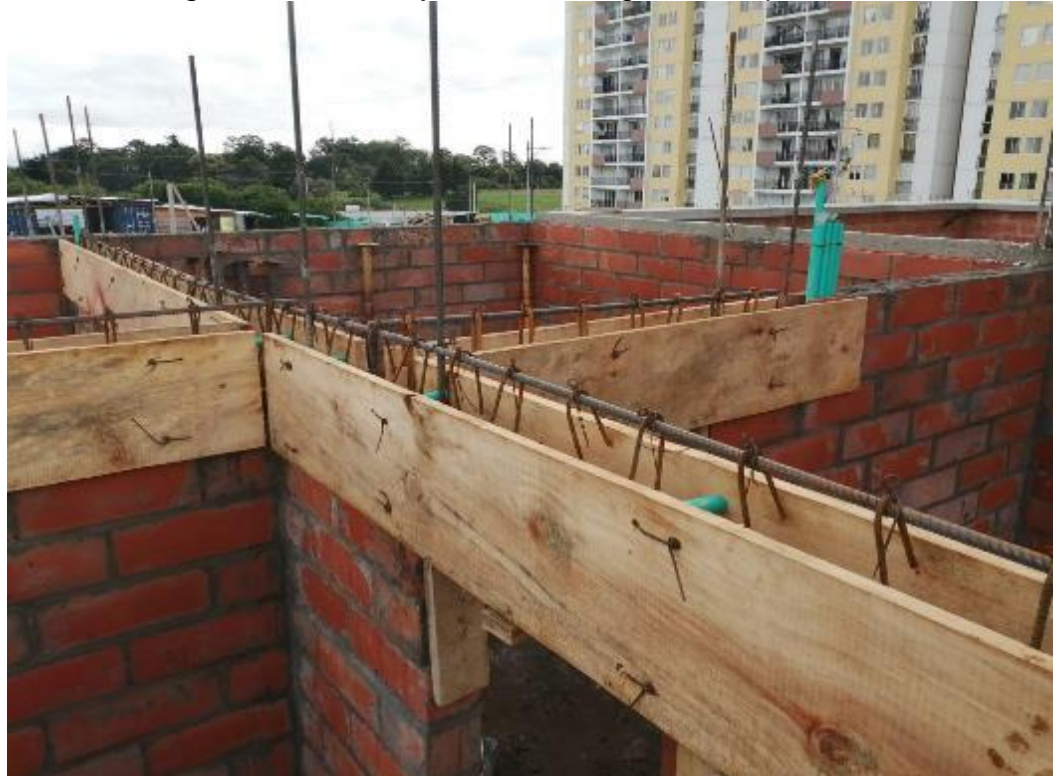
Imagen 38 Armado y encofrado vigas dintel primer nivel
