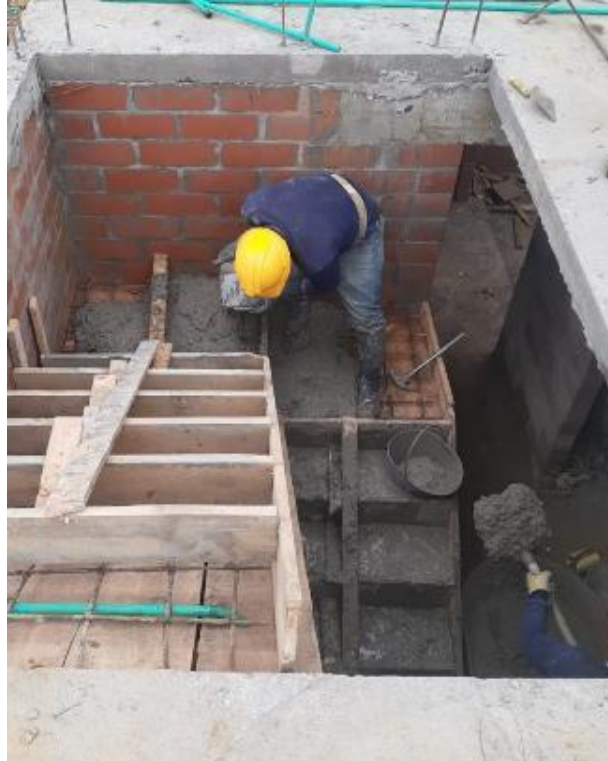
Imagen 46 Fundición escalera en concreto
