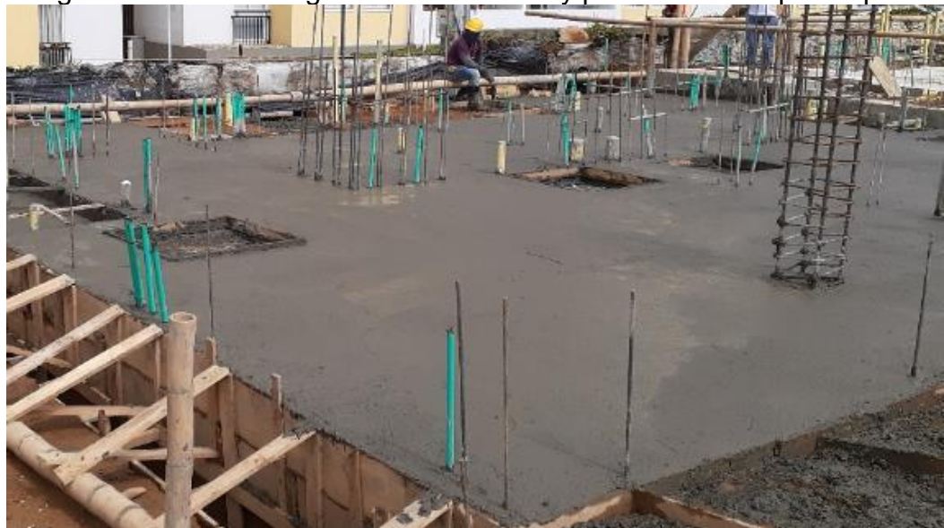
Imagen 31 Fundición vigas de cimentación y placa de contrapiso 1 pacha
