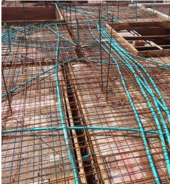
Imagen 43 Instalación ductos eléctricos losa de entpiso
