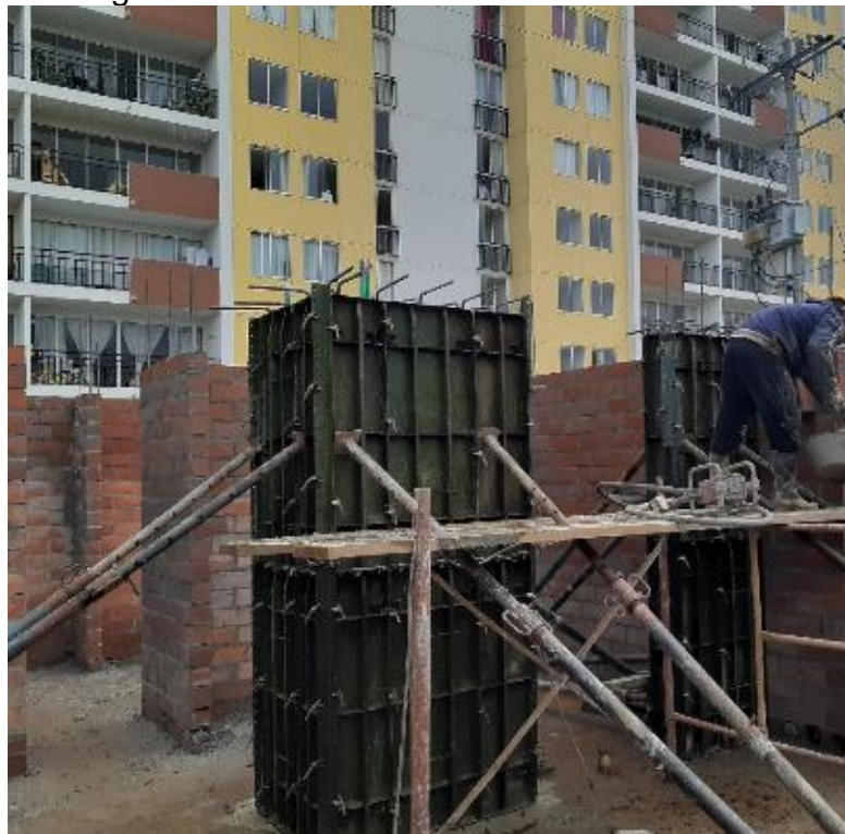
Imagen 36 Pantalla en concreto casa medianera
