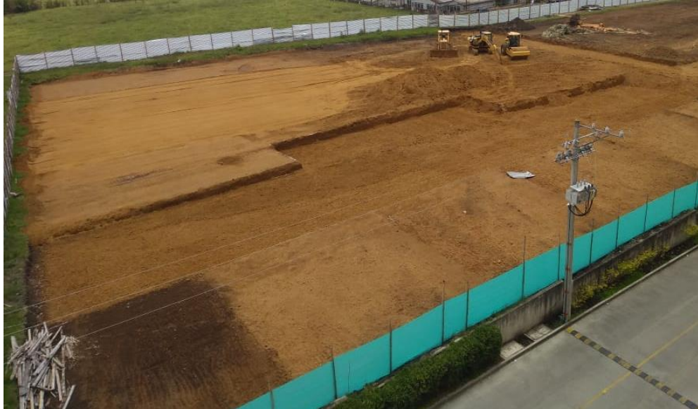
Imagen 3 Movimiento de tierra etapa 1
