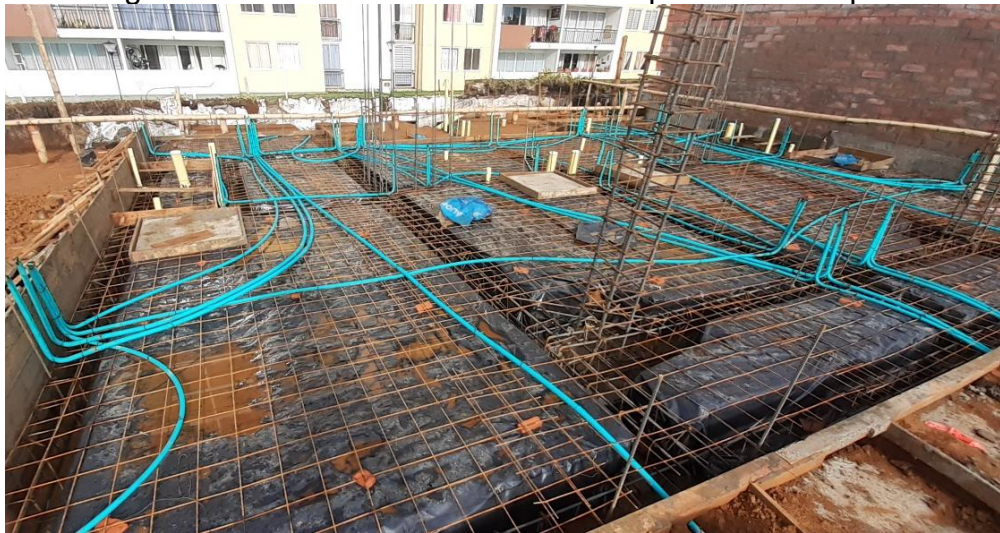
Imagen 30 Instalación ductos eléctricos primer nivel 1 pacha
