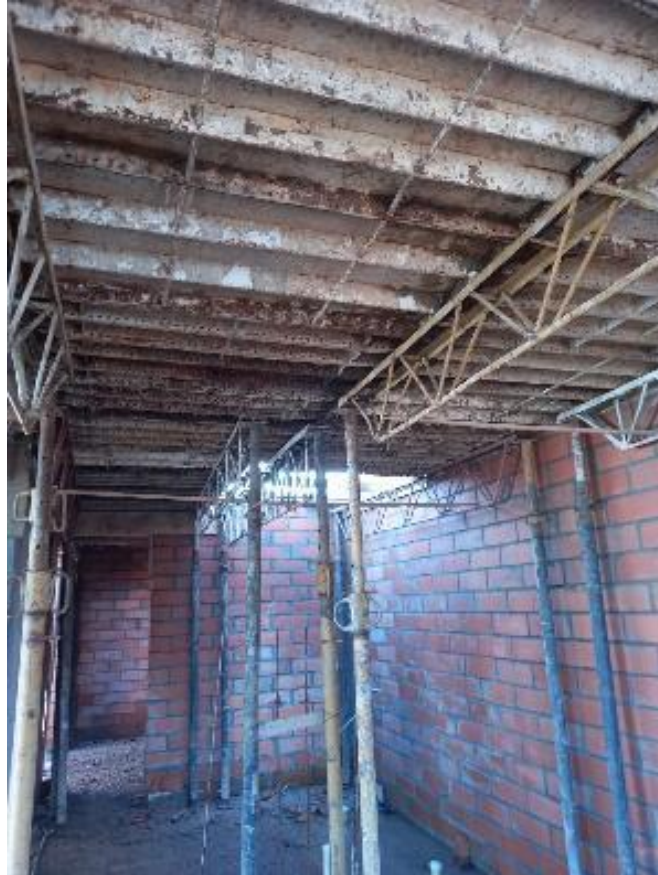
Imagen 39 Instalación formaleta metálica losa de entrepiso
