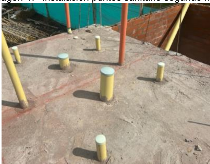
Imagen 47 Instalación puntos sanitario segundo nivel
