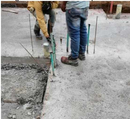
Imagen 32 Cimbra muros primer nivel
