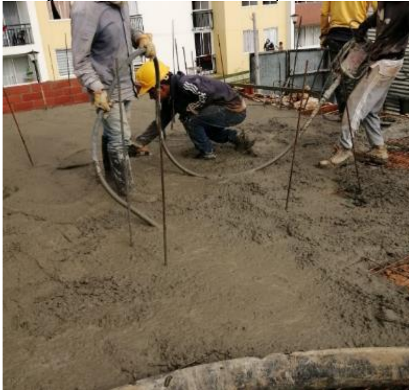
Imagen 44 Fundición losa de entrepiso en concreto
