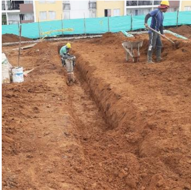
Imagen 51 Compactación relleno excavación red sanitaria tramo CS11-CS4
