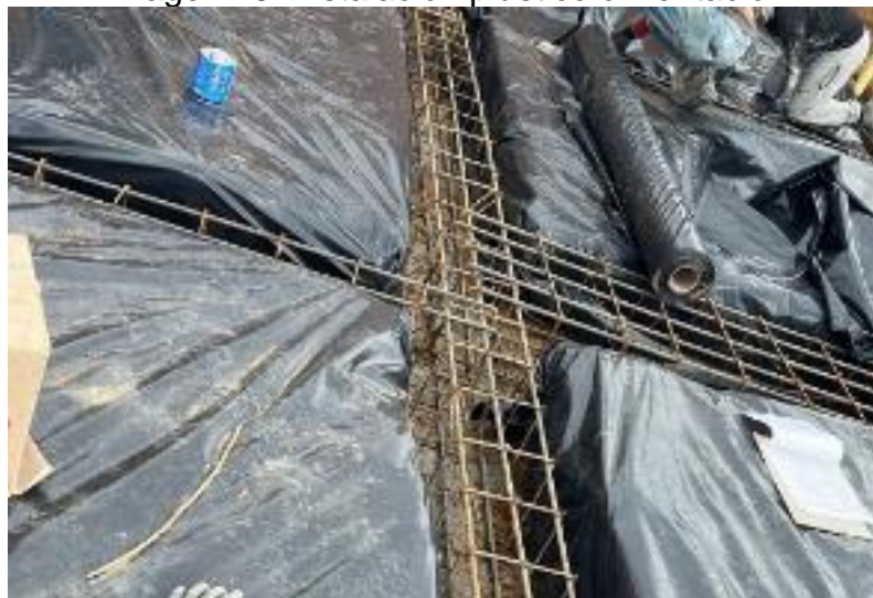
Imagen 25 Instalación plástico cimentación
