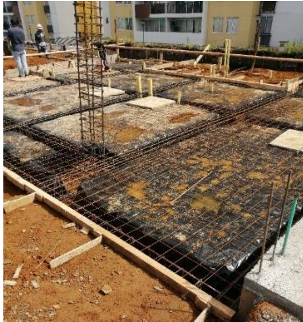
Imagen 26 Refuerzo cimentación 2 casas medianeras (1 pacha)
