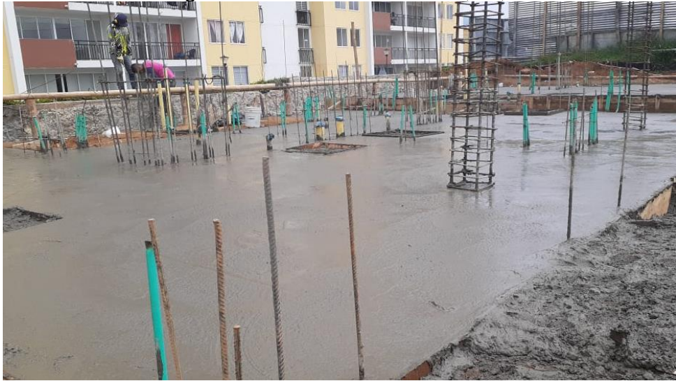
Imagen 4. Cimentación casa C1,C2,C3
