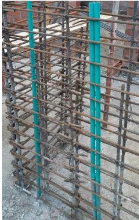
Imagen 35 Refuerzo muro en concreto (ELE)
