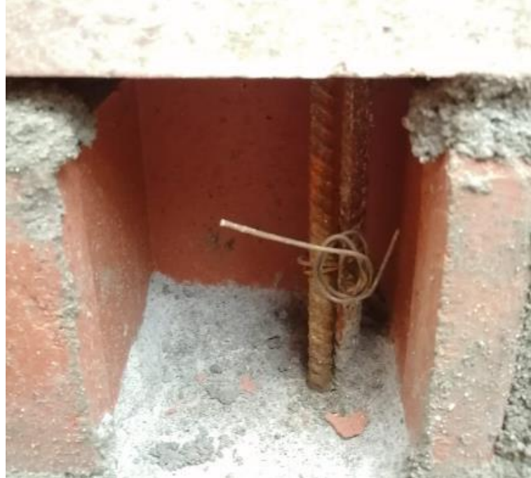
Imagen 34 Caja de inspección e instalación refuerzo vertical
