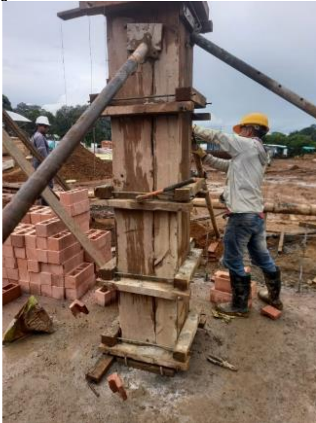
Imagen 37 Instalación formaleta columna en concreto
