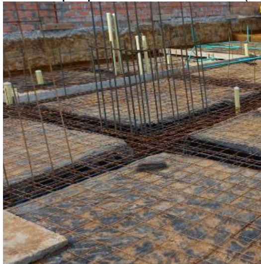
Imagen 27 Arranque pantallas en concreto (muro 17-23)
