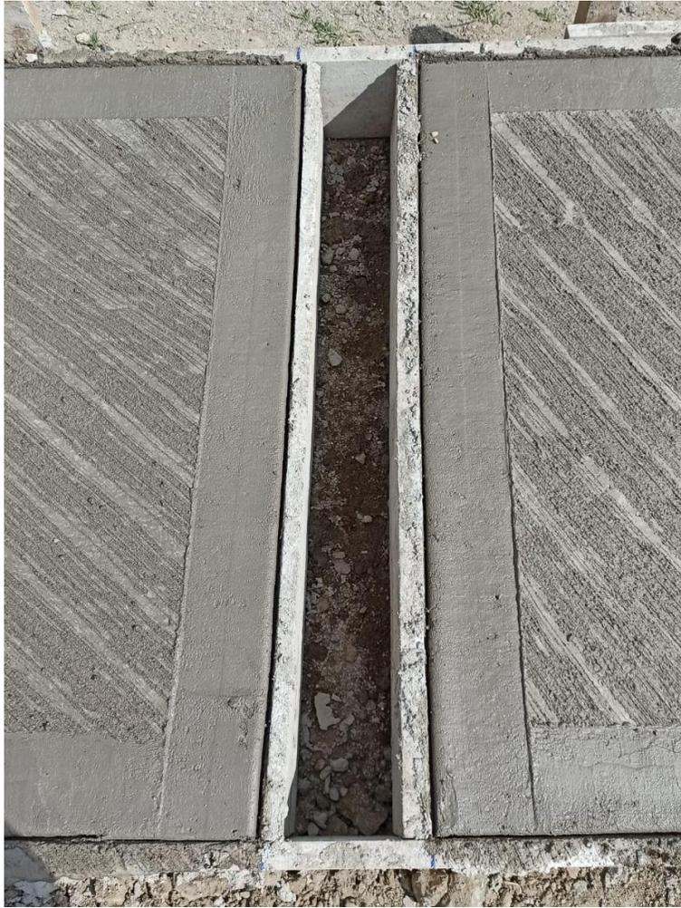
*Detalle constructivo, losas monolíticas de concreto de 21Mpa.*
