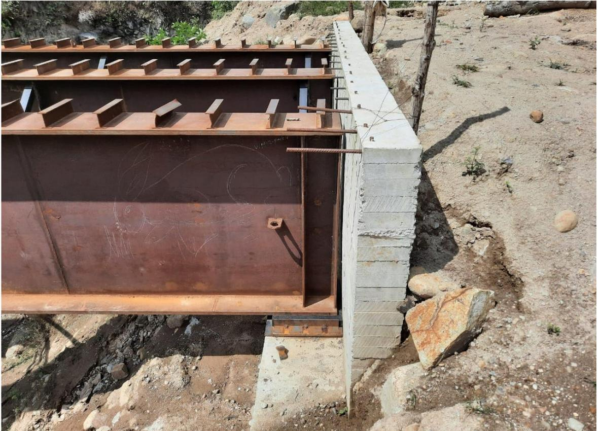
*Colocación de vigas metálicas del Puente Piedras Rio Moras.*
