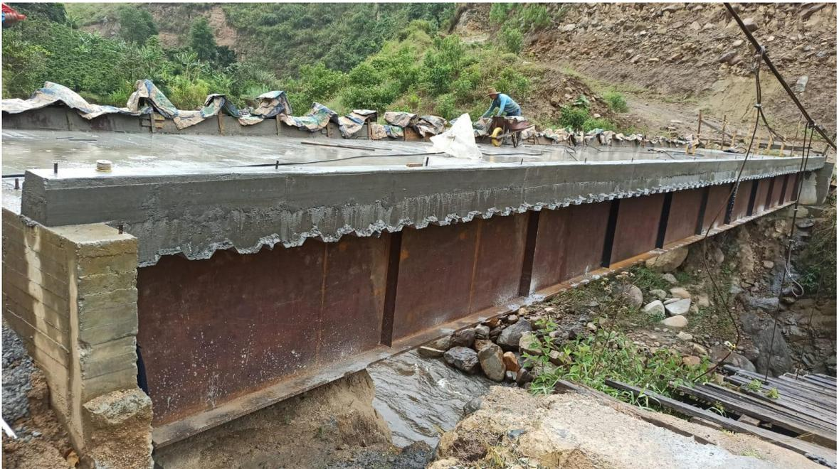
*Fundición de losa del puente piedras, Rio Moras*
