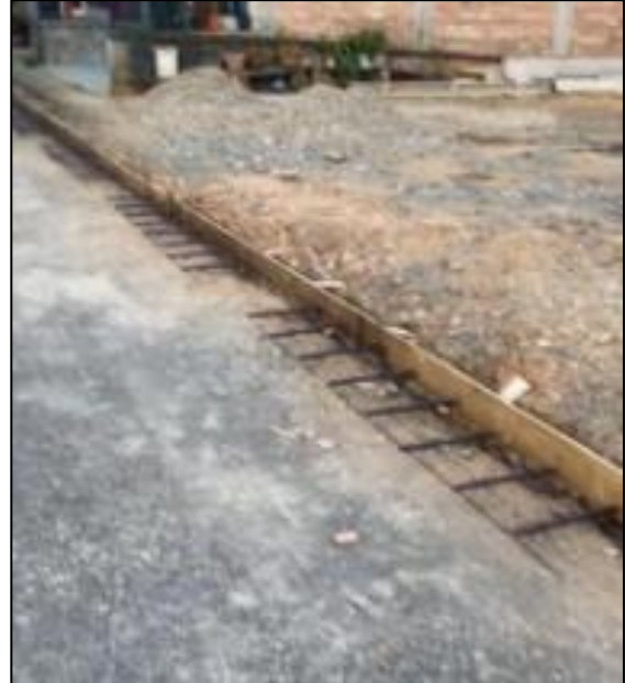
Imagen 22. Fuente propia: Refuerzo en Acero
