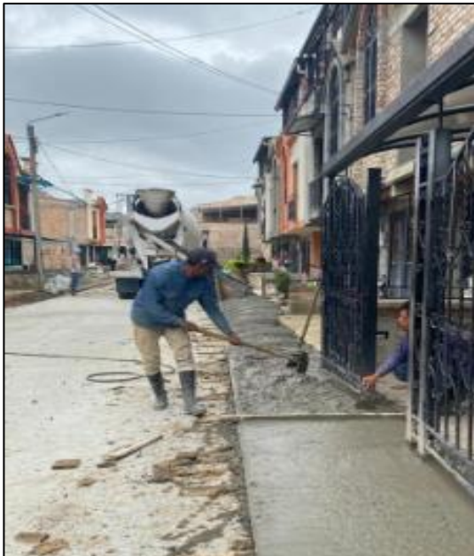
Imagen 42. Fuente propia: Fundición de Andén
