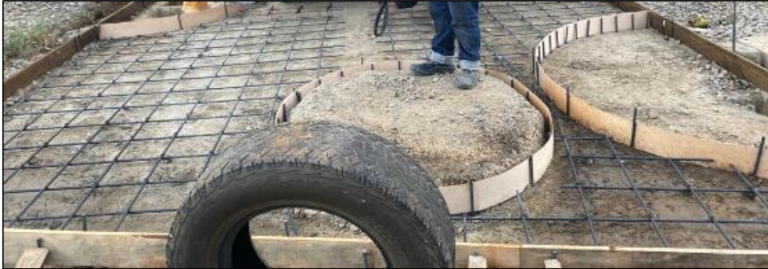
Imagen 24. Fuente propia: Refuerzo en Acero (Parrilla)
