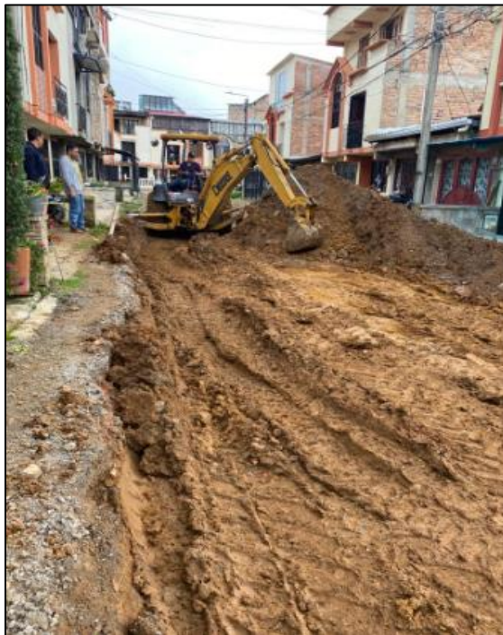
Imagen 10. Fuente propia: Excavación y carga de sobrantes
