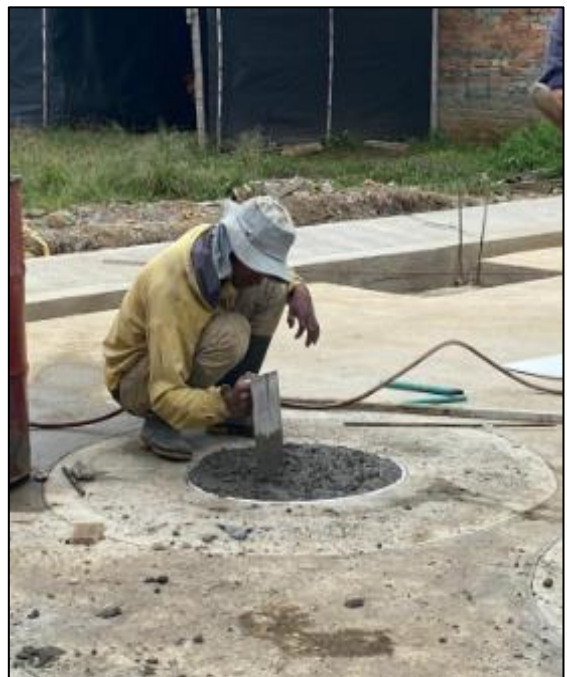
Imagen 53. Fuente propia: fundición tapa
