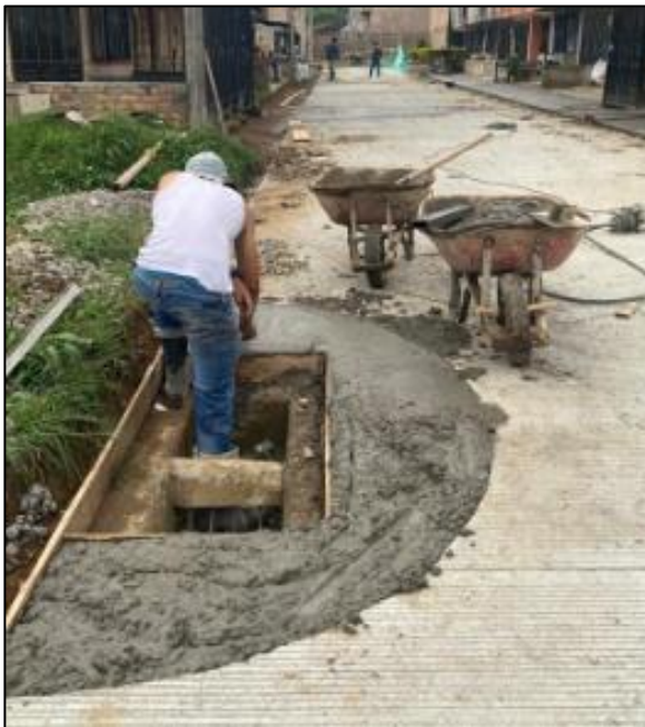
Imagen 50. Fuente propia: Fundición sumidero
