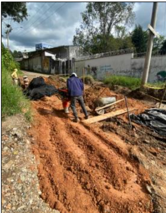
Imagen 67. Fuente propia: Relleno con tierra amarilla
