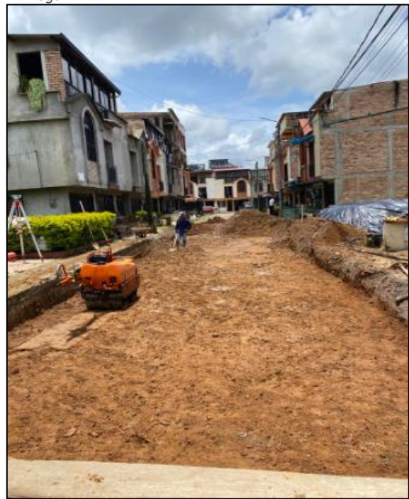
Imagen 9. Fuente Propia: Excavación y cajeo Pinar de la Vega
