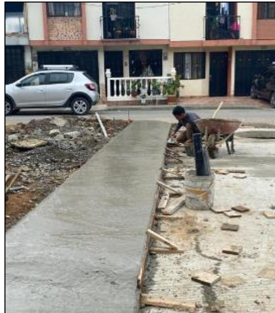
Imagen 43. Fuente propia: Fundición de Andén
