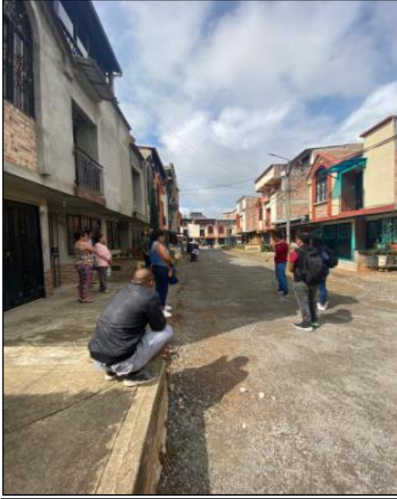
Imagen 17. Fuente propia: Revisión de la Subbase
