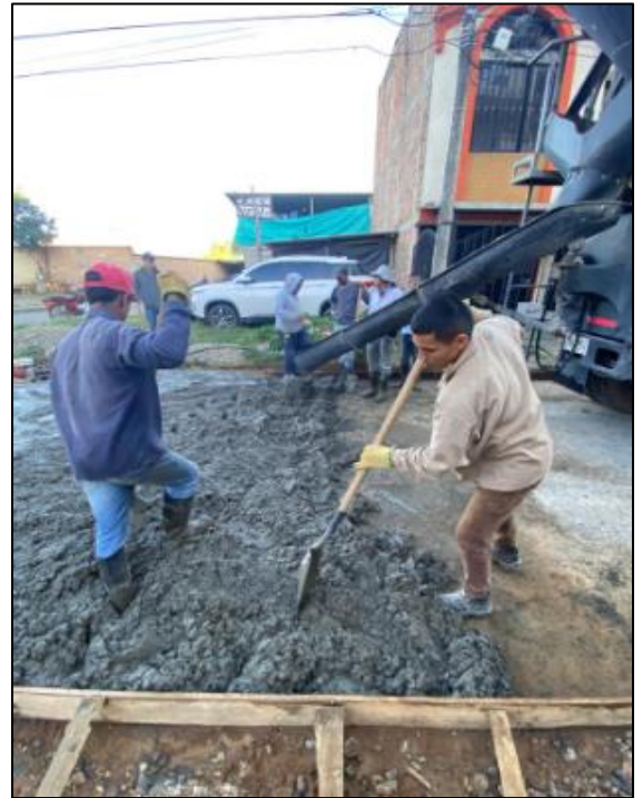
Imagen 29. Fuente propia: Fundición de losa
