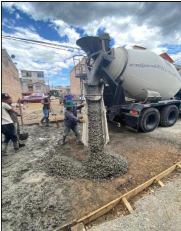
Imagen 26. Fuente propia: Fundición del tramo.
