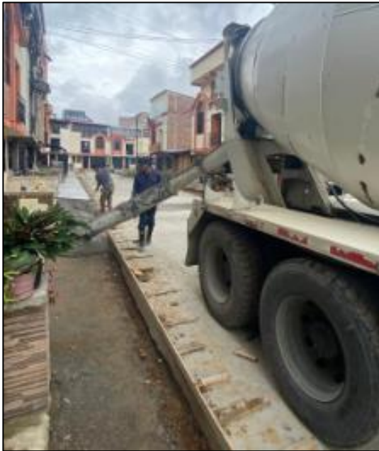
Imagen 44. Fuente propia: fundición de Anden
