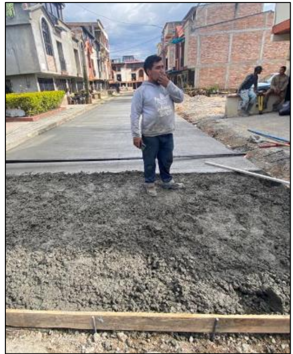
Imagen 33. Fuente Propia: Fundición ultima losa
