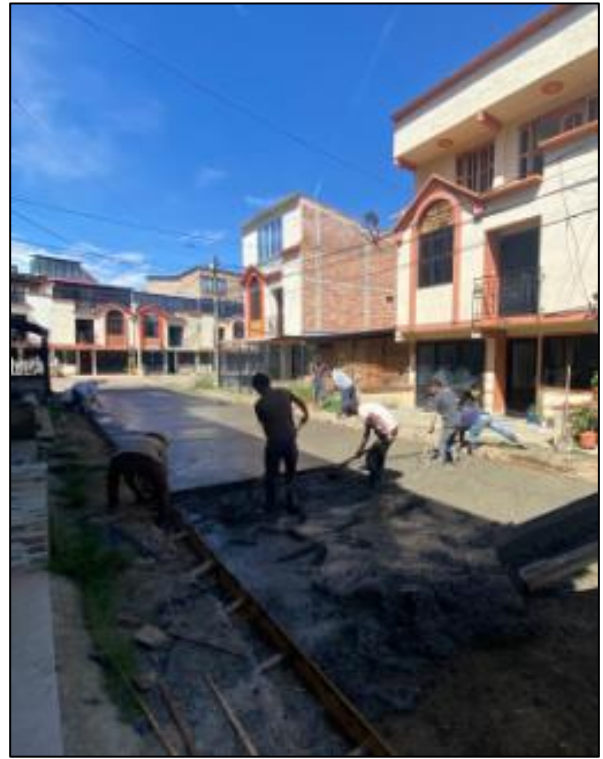
Imagen 31. Fuente propia Fundición del tramo
