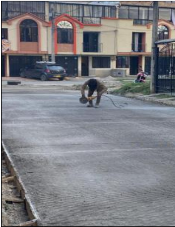
Imagen 34. Fuente propia: Realización de cortes en el pavimento
