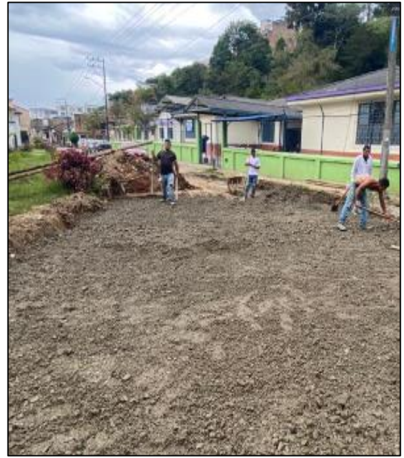
Imagen 72. Fuente propia: Conformación de la subbase
