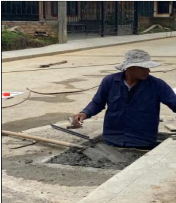
Imagen 52. Fuente propia: fundición de sumidero
