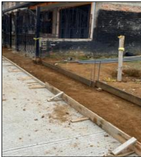
Imagen 40. Fuente propia: excavación y Conformación de andén
