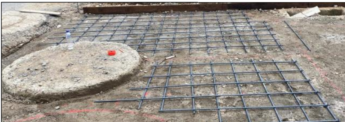
Imagen 23. Fuente propia: Parrilla en acero para losa de la caja y sumideros
