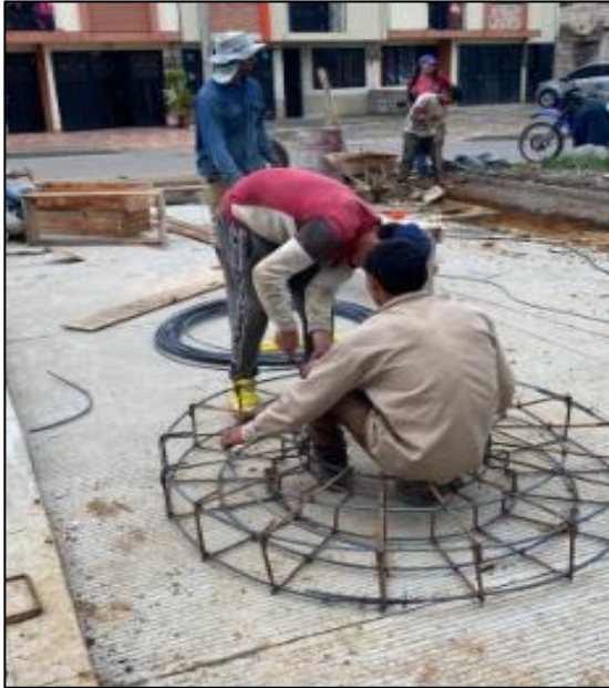
Imagen 48. Fuente propia: Armado de araña de acero
