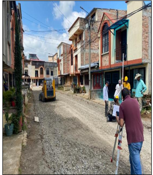
Imagen 14. Fuente Propia: Conformación de la Subbase
