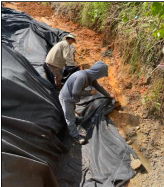
Imagen 63. Fuente propia: Instalación de Filtro
