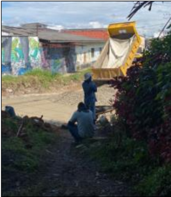
Imagen 71. Fuente propia: Descargue de material Subbase
