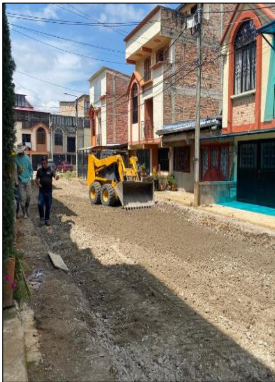
Imagen 15. Fuente propia: Subbase con bobcat
