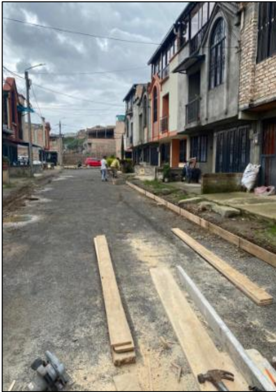
Imagen 19. Fuente propia: Colocación formaleta en madera
