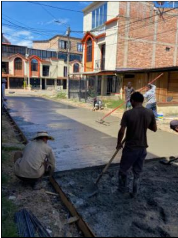
Imagen 30. Fuente propia: Fundición del tramo
