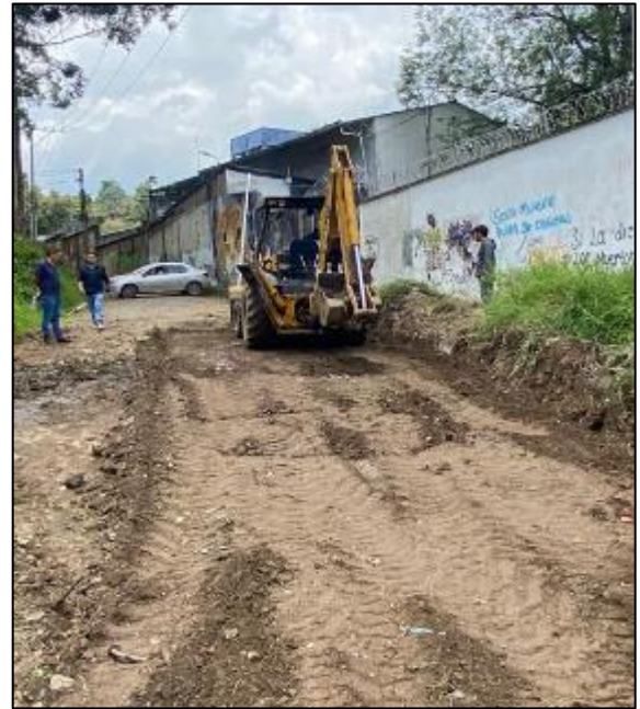
Imagen 59. Fuente propia: Excavación y perfilación del tramo
