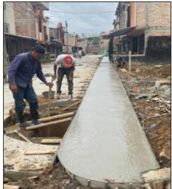
Imagen 47. Fuente propia: Excavación de Sumidero
