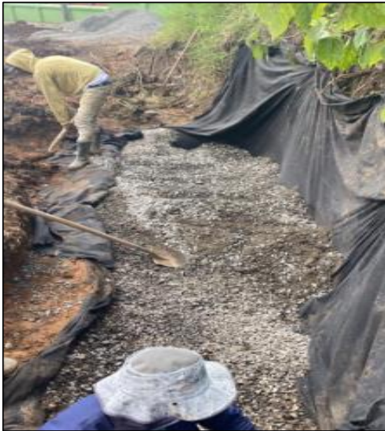
Imagen 65. Fuente propia: Conformación del filtro
