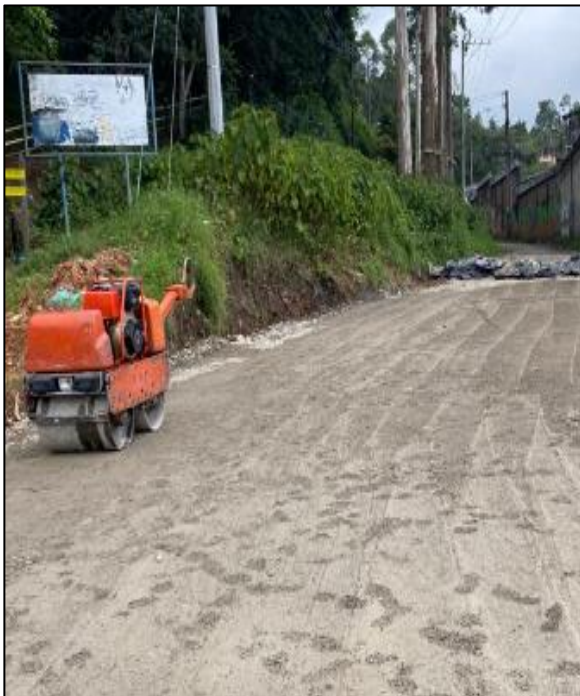
Imagen 73. Fuente propia: Compactación de la subbase
