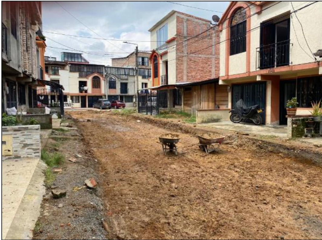
Imagen 12. Fuente propia: Excavación y perfilación del tramo
