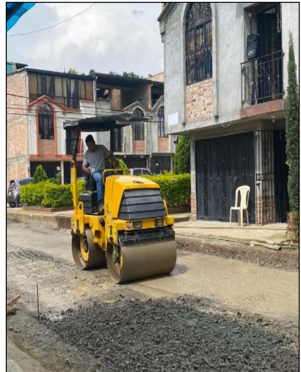
Imagen 16. Fuente propia: Compactación de la Subbase
