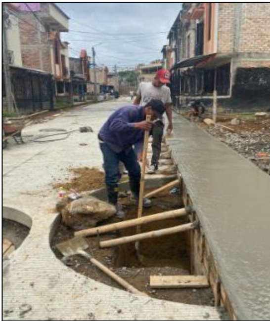
Imagen 46. Fuente propia: Excavación de sumidero
