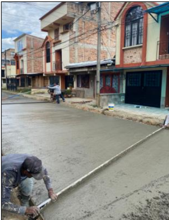
Imagen 32. Fuente propia Fundición y texturizado
