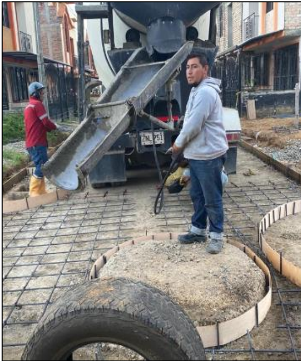
Imagen 28. Fuente propia: Fundición de las losas
