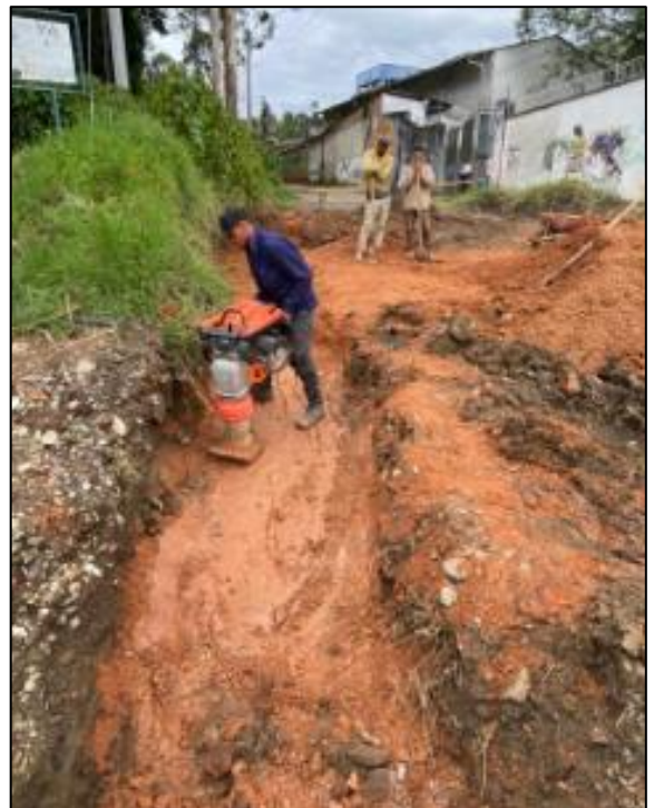
Imagen 58. Fuente propia: Compactación relleno filtro
