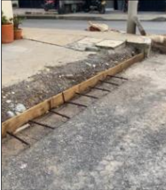
Imagen 21. Fuente Propia: Refuerzo en Acero
