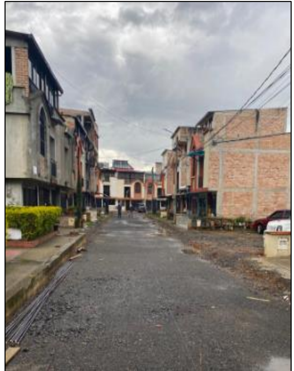
Imagen 18. Fuente propia: Conformación de la Subbase
