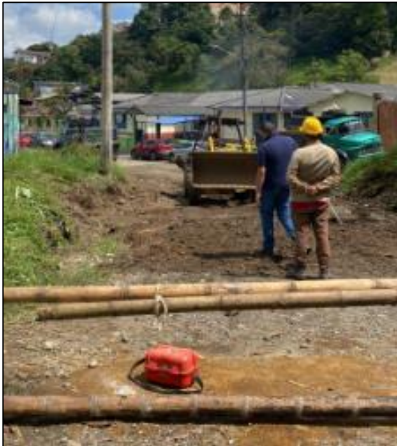
Imagen 58. Fuente propia: Excavación del tramo
