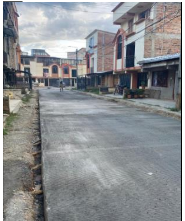
Imagen 37. Fuente propia: Curado del pavimento
