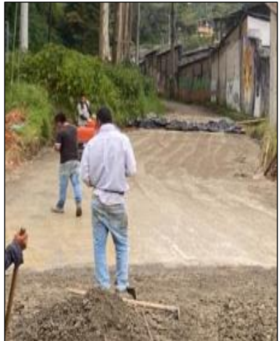
Imagen 74. Fuente propia: Compactación subbase
