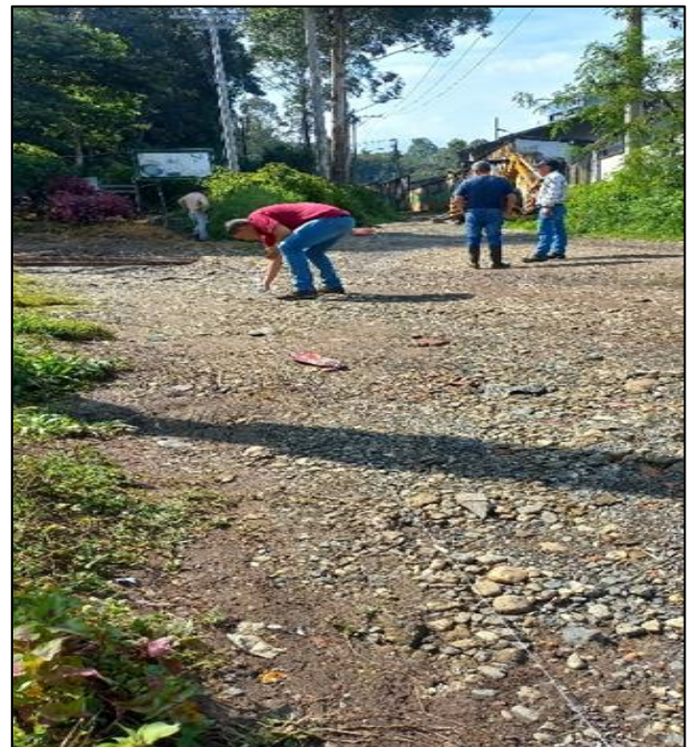
Imagen 8. Fuente Propia: Estado Inicial Barrio La Pamba
