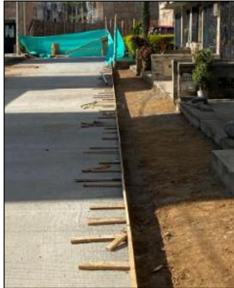
Imagen 39. Fuente propia: Excavación andén
