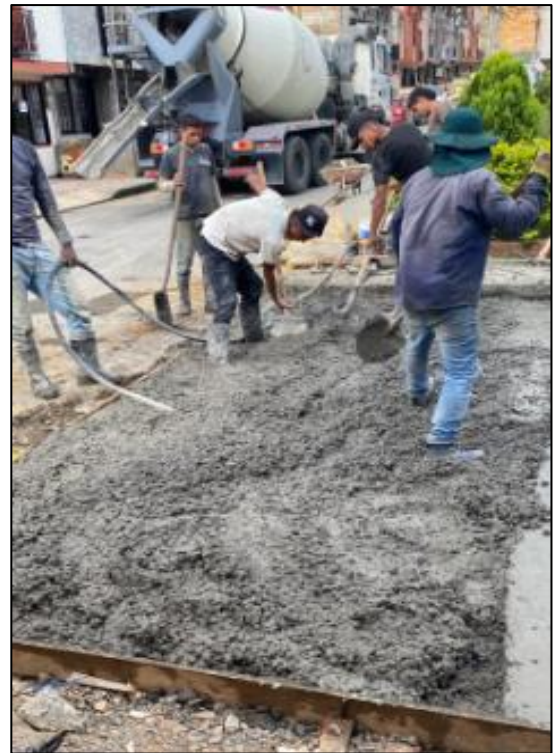
Imagen 27. Fuente propia Fundición y vibrado del concreto
