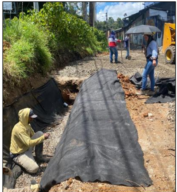
Imagen 64. Fuente propia: Instalación de filtro y geotextil
