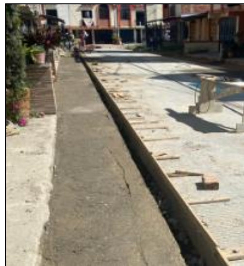
Imagen 41. Fuente propia: Subbase para Andén
