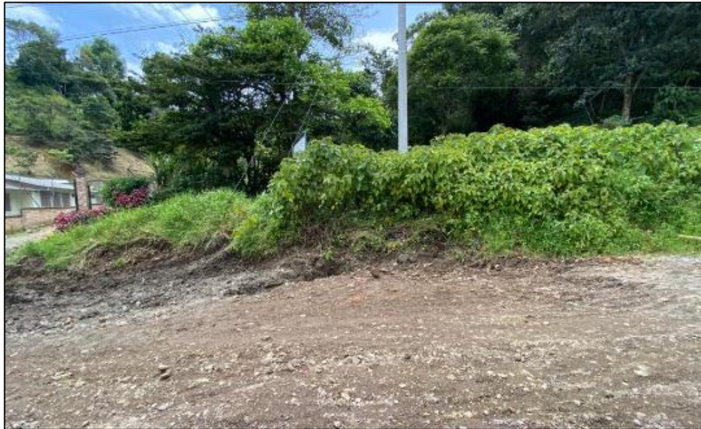
Imagen 62. Fuente propia: Tramo de filtración de agua
