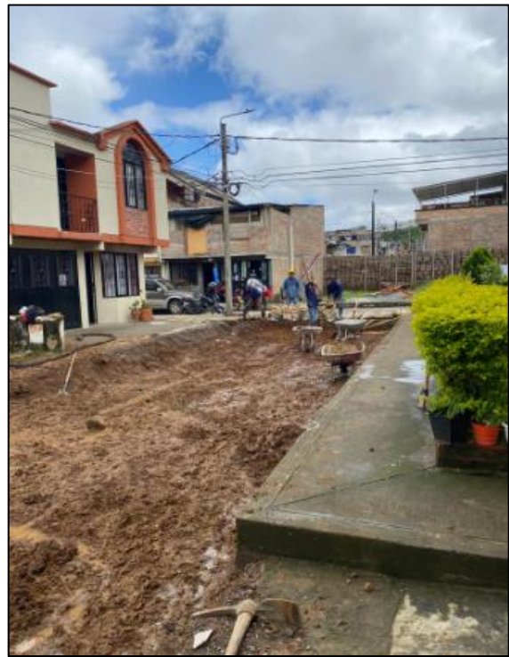
Imagen 9. Fuente Propia: Excavación y cajeo Pinar de la Vega
