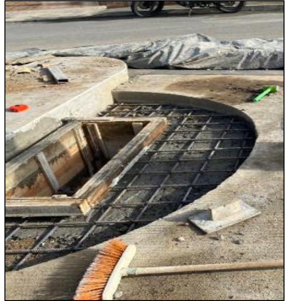
Imagen 49. Fuente propia: Refuerzo para sumidero
