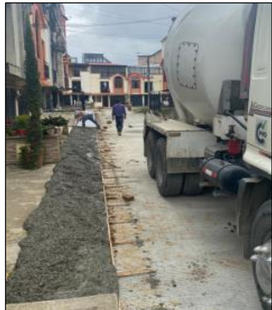
Imagen 45. Fuente propia: fundición Anden
