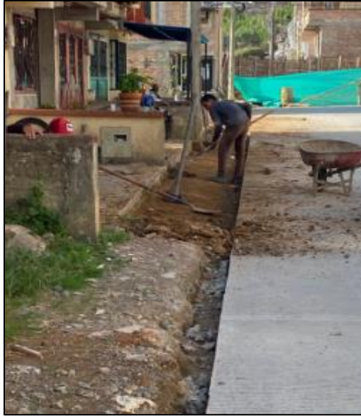
Imagen 38. Fuente propia: excavación de andén
