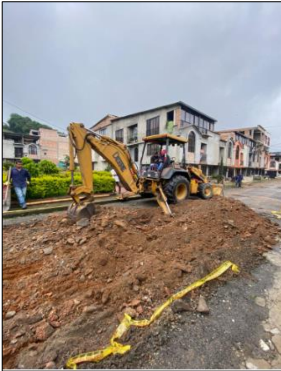
Imagen 8. Fuente propia: Excavación y cajeo Pinar de la Vega
