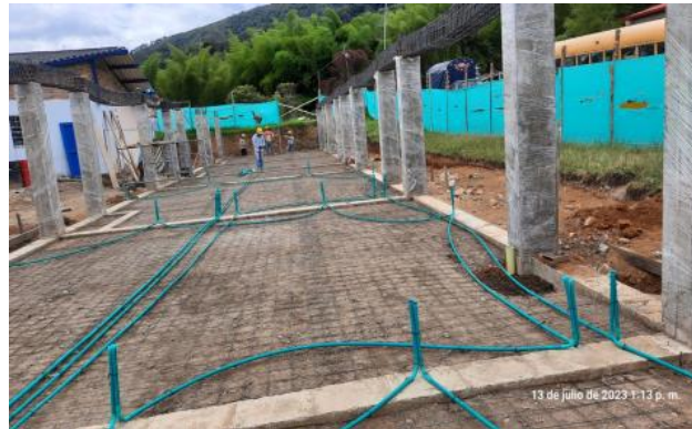
Figura 55. Colocación de malla electrosoldada
