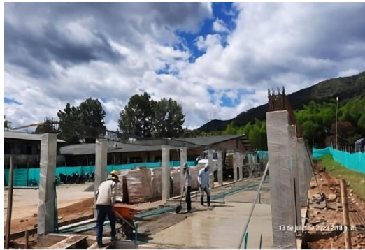
Figura 48. Fundición de losa contrapiso
