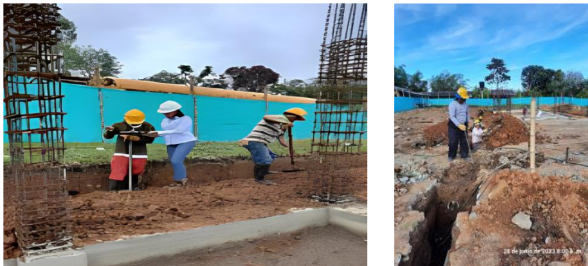
Figura 63. Excavación para red pluvial y cajas de inspección
