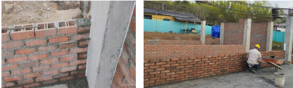
Figura 59. Relleno de dovelas que tienen refuerzo con concreto
