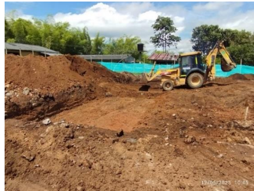
Figura 25. Excavación a máquina
