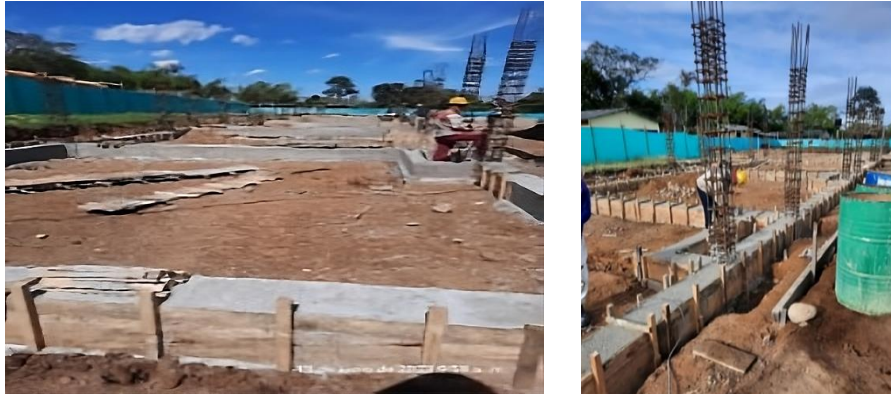
Figura 40. Desencofrado de vigas de cimentación
