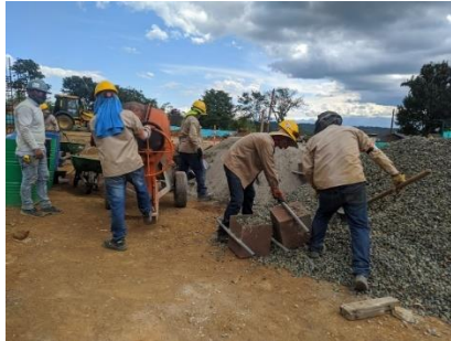
Figura 34. Dosificación y mezcla de concreto 3000 PSI
