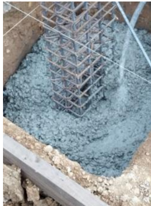
Figura 35. Zapatas en concreto 3000 PSI
