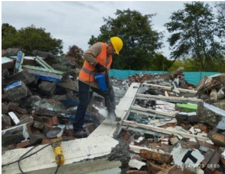
Figura 23. Demol.columna concreto amarre
