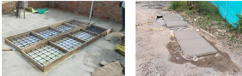
Figura 65. Elaboración de las tapas de las cajas de inspección
