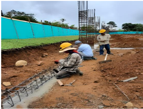
Figura 38. Instalación de refuerzos
