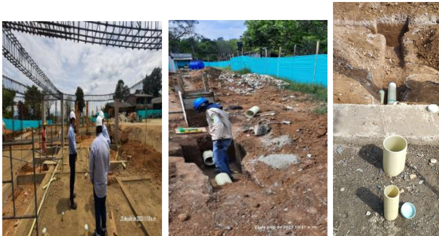
Figura 66. Colocación de tuberías
