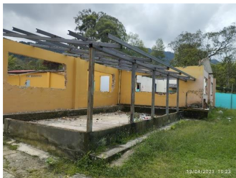
Figura 18. Desm.estructura madera/metálica cubierta
