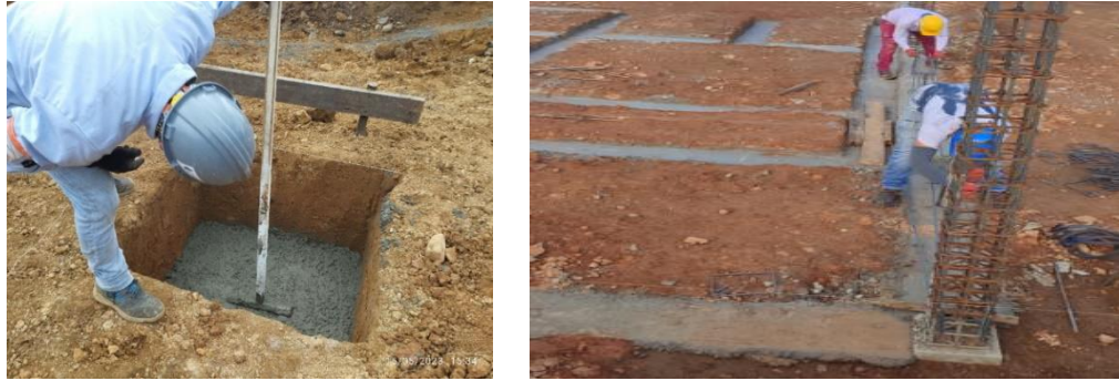
Figura 33. Solado de zapata y vigas de cimentación 3000 PSI
