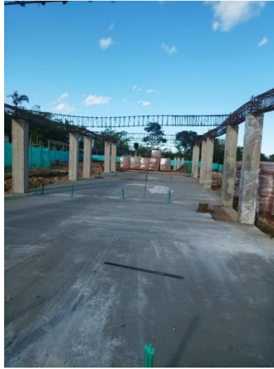
Figura 49. Losa de contrapiso fundida
