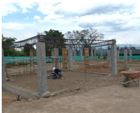
Figura 52. Curado de columnas en concreto
