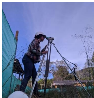
Figura 26. Nivelación con nivel topográfico
