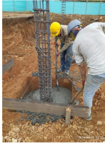
Figura 36. Vibrado del concreto
