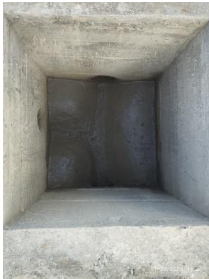
Figura 64. Caja de inspección
