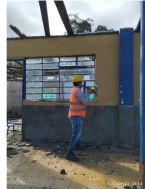
Figura 21. Demol.muro lad. existente
