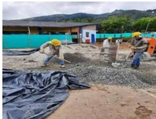
Figura 46. Alistamiento de materiales para elaboración de concreto
