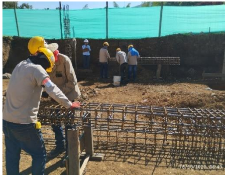
Figura 47. Armado de acero
