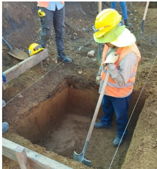
Figura 44. Excavación de zapatas
