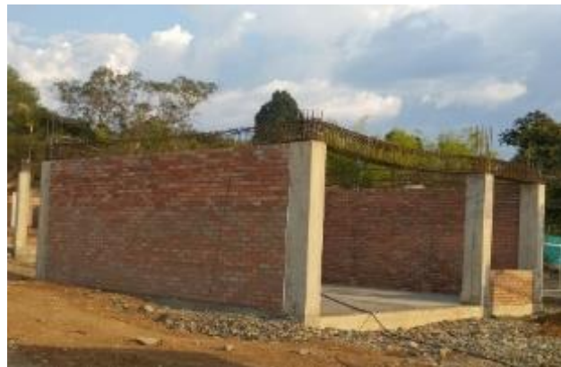
Figura 58. Hiladas de ladrillo y muro terminado
