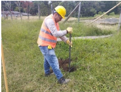
Figura 13. Delimitación y excavación para postes
