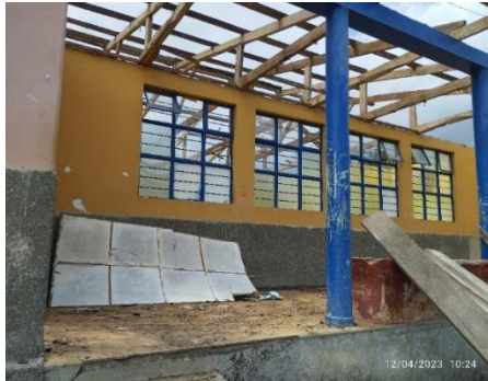
Figura 17. Desm cielo falso existente
