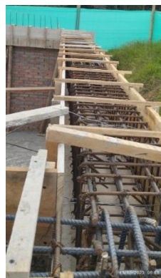
Figura 54. Formaleta de viga aérea
