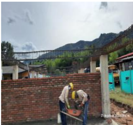
Figura 58. Hiladas de ladrillo y muro terminado
