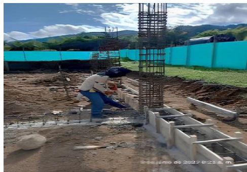
Figura 39. Formaleta para fundición de vigas de cimentación
