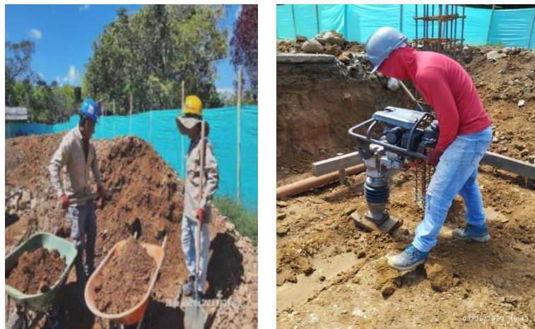
Figura 41. Relleno material
