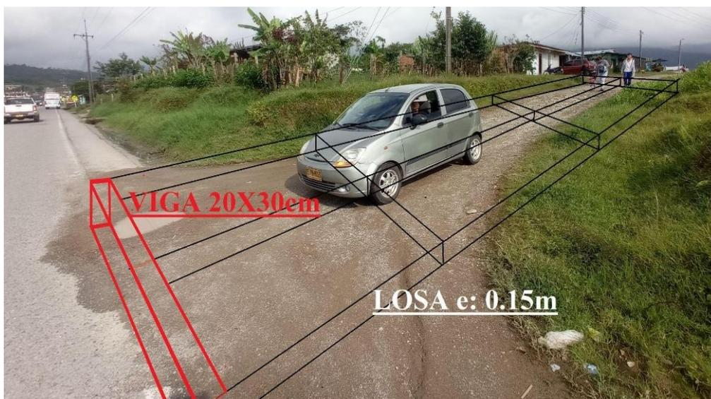
Ilustración 18. Localización de la viga de concreto de empalme.
