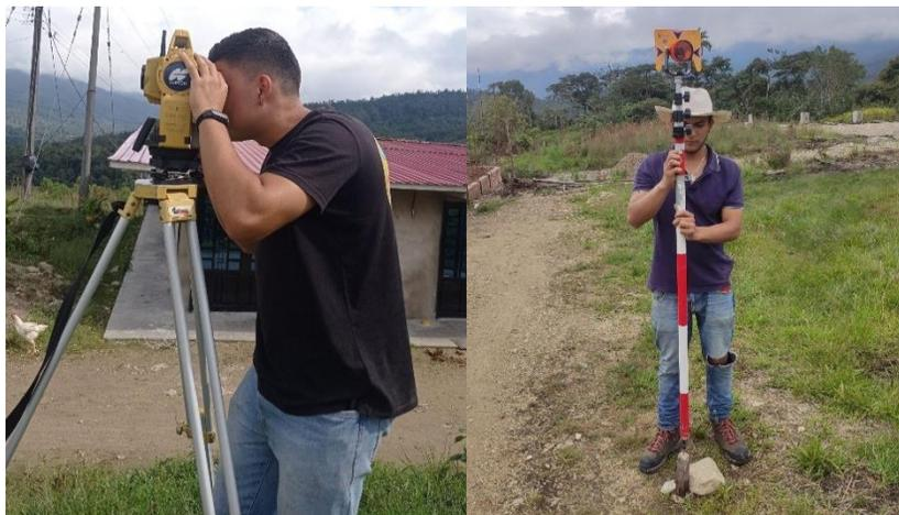
*Imagen 8. Levantamiento topográfico en campo.*
