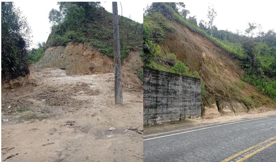
*Imagen 6. Fuente de material para mejoramiento explotada y material desprendido sobre la vía.*
