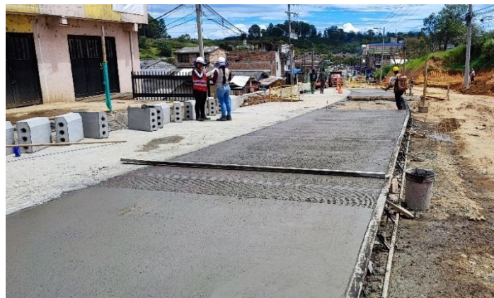
Ilustración 56. Acabado final de las losas.
