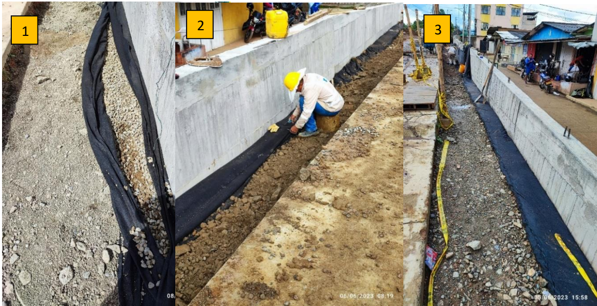
Ilustración 43. Elaboración del filtro, Foto 1: Material granular del filtro, Foto 2: Cosido del geotextil, Foto 3: Filtro terminado.
