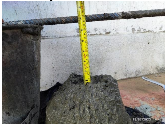
Ilustración 47. Ensayo de asentamiento concreto muro.
