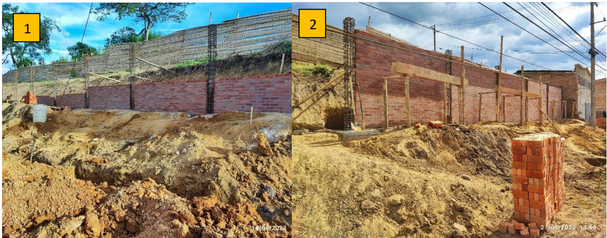
Ilustración 38. Construcción de pantallas en mampostería, Foto 1: Primera mitad, Foto 2: Pantalla terminada.
