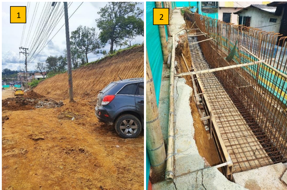
Ilustración 7. Avance de obra TRAMO 7B durante la iniciación de la práctica, Foto 1: Corte y perfil de taludes, Foto 2: Armado de aceros 1er muro.
