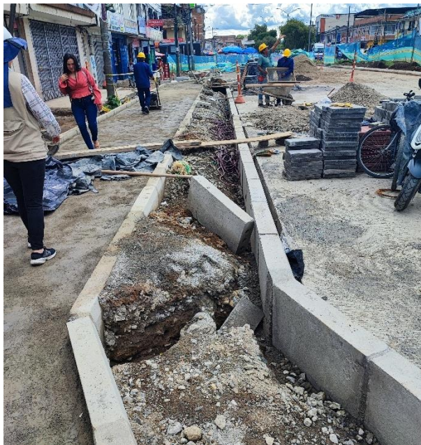
Ilustración 24. Instalación de bordillos.
