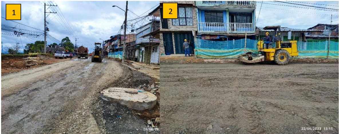
Ilustración 53. Humedecimiento y compactación de la subbase, Foto 1: Humedecimiento con carrotanque, Foto 2: Compactación con rodillo vibratorio.
