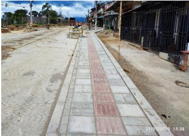
Ilustración 27. Acabado final del espacio público.
