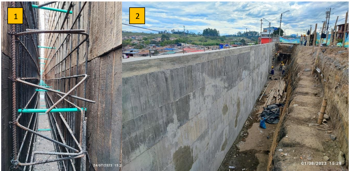
Ilustración 48. Lagrimales y muro construido, Foto 1: Lagrimales de pantalla, Foto 2: Modulo 1 terminado.
