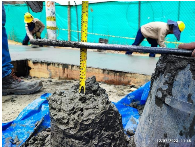
Ilustración 54. Ensayo de asentamiento.
