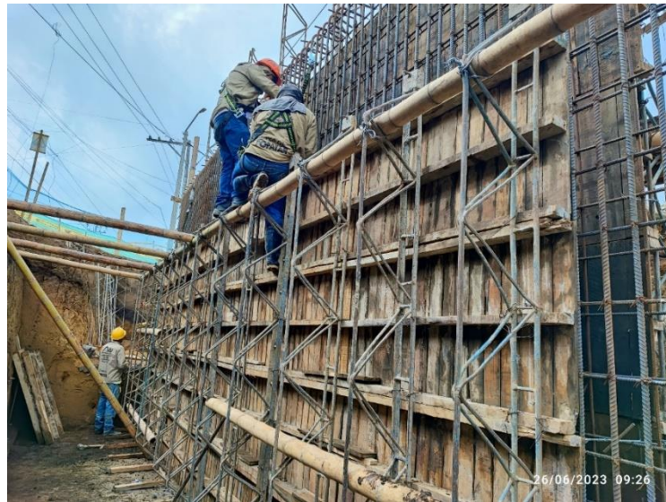
Ilustración 46. Formaleta para fundición de pantalla.
