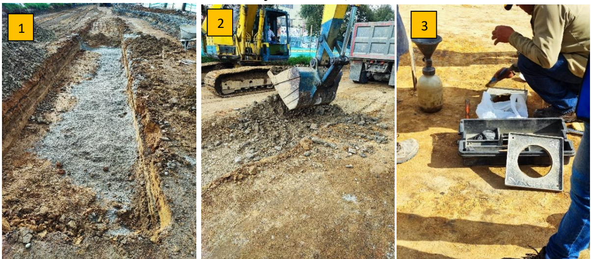
Ilustración 13. Proceso de reparación del fallo Foto 1: Colocación de arena, Foto 2: Material de mejoramiento, Foto 3: Toma de densidades.
