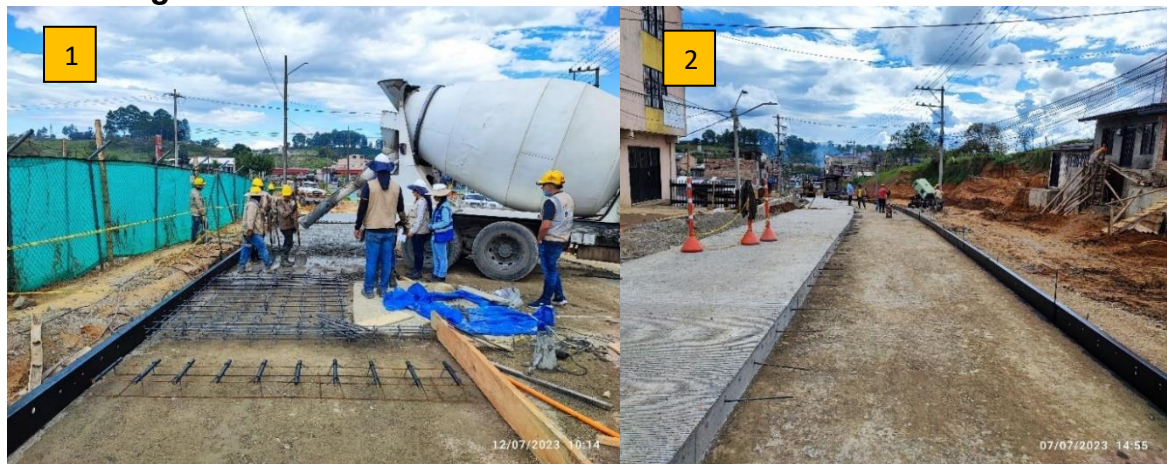
Ilustración 55. Acero de refuerzo de losa y aceros de amarre longitudinales, Foto 1: Aceros de parrillas y pasadores, Foto 2: Amarres longitudinales
