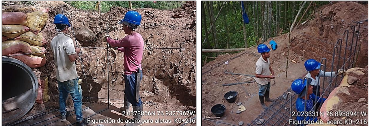
Figura 32 Acero de refuerzo
