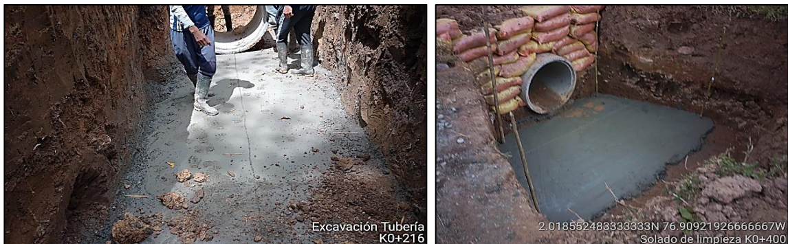
Figura 31 Solado de Limpieza
