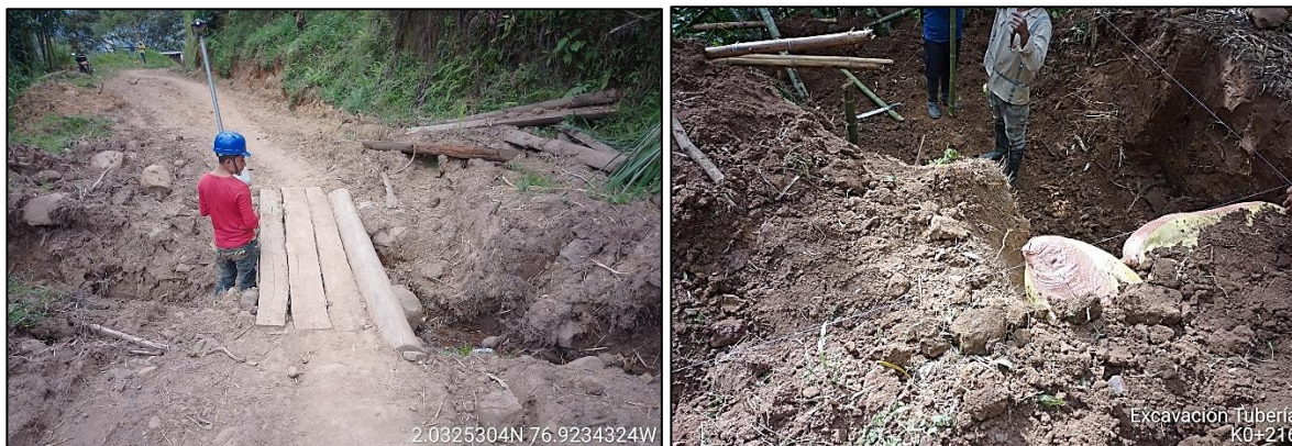
Figura 29 Excavación Varias sin Clasificar
