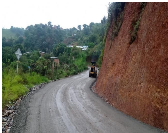
Figura 22. Extendido del material de subbase
