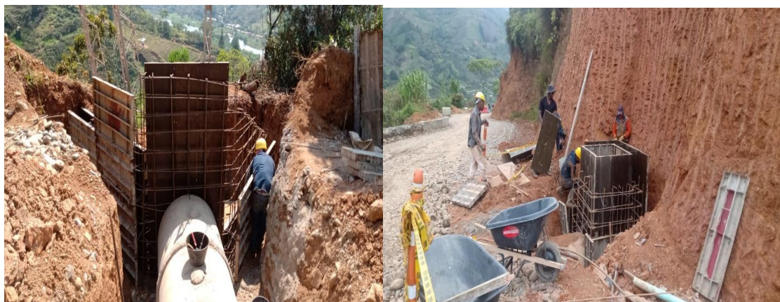
Figura 31. Instalación de acero para la construcción de alcantarillas.
