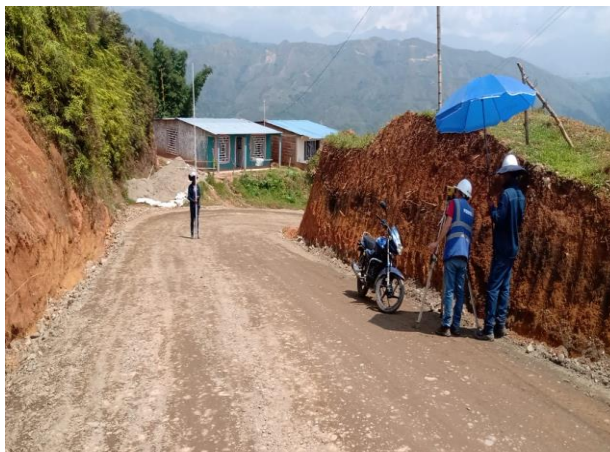
Figura 23. Verificación de cota de terreno por interventoría
