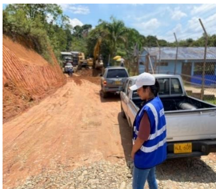
Figura 16. Revisión de los niveles de subrasante
