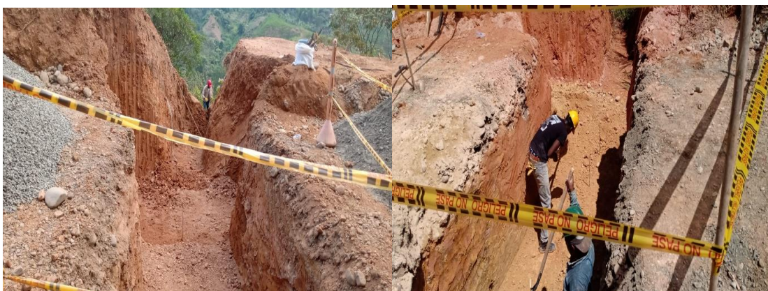
Figura 26. Excavación para construcción de alcantarilla
