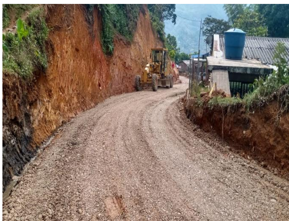
Figura 19. Subrasante compactada.
