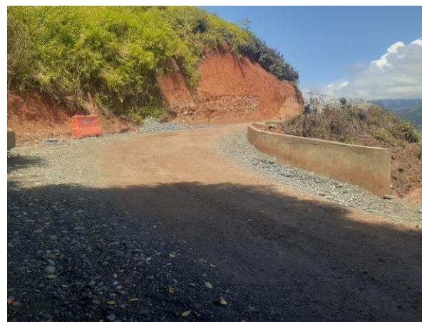
Figura 37. Muro de contención finalizado.
