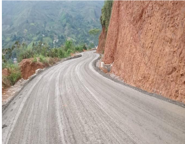
Figura 24. Verificación de bordes sobre la capa de subbase granular.
