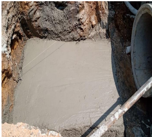
Figura 27. Construcción de losa de piso
