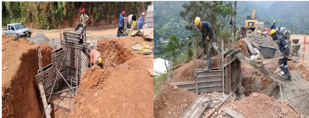
Figura 32. Construcción de alcantarillas.
