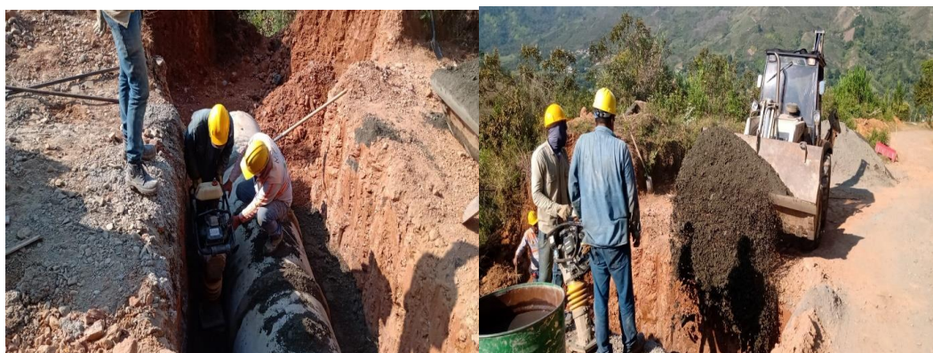
Figura 30. Relleno sobre tubería de alcantarillado
