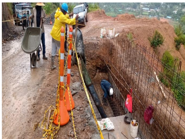
Figura 35. Colocación de aceros para la construcción de los muros de contención.
