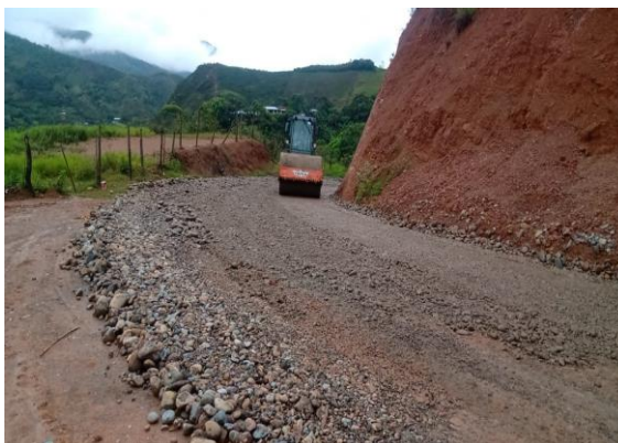
Figura 18. Compactación del material de mejoramiento de subrasante.
