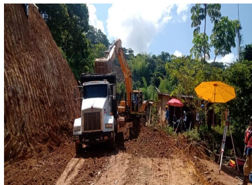
Figura 17. Verificación de la subrasante.
