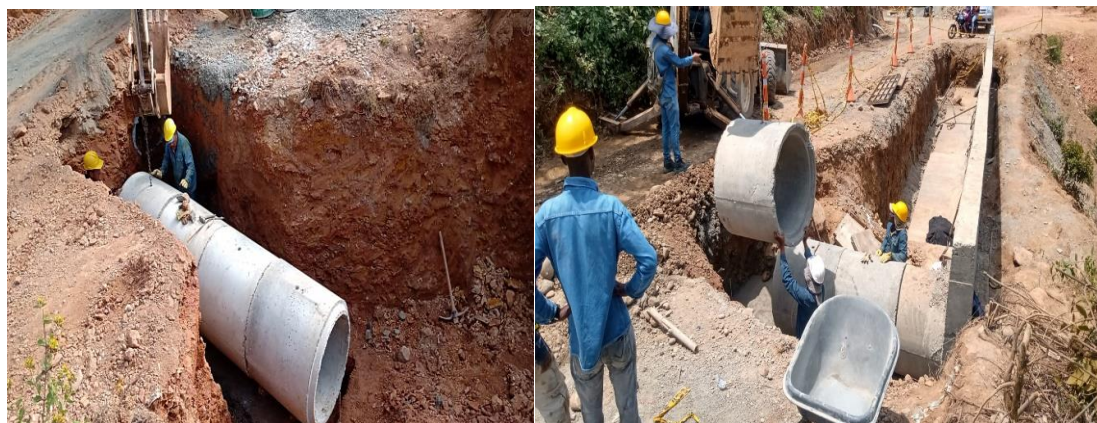
Figura 29. Instalación tubería en concreto reforzado
