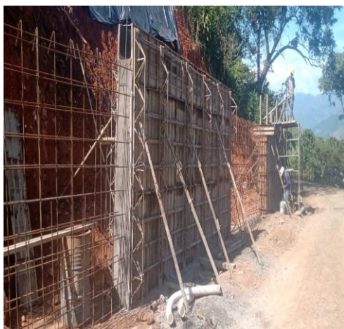
Figura 36. Fundición de los muros de contención.
