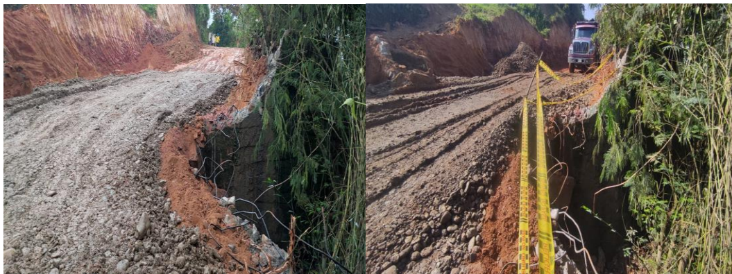
Figura 25. Demolición de alcantarillas existente.
