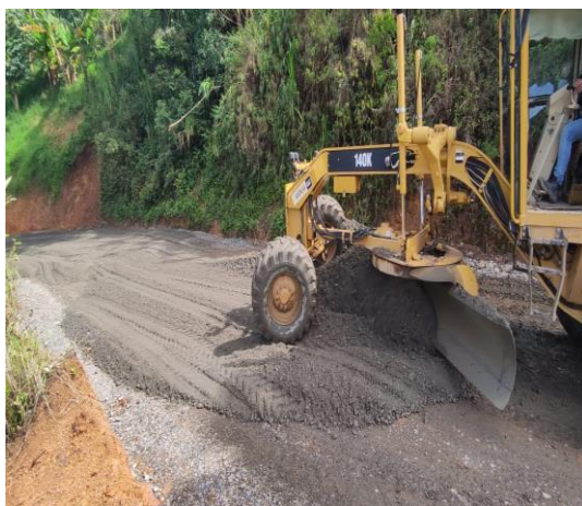
Figura 21. Instalación de subbase granular
