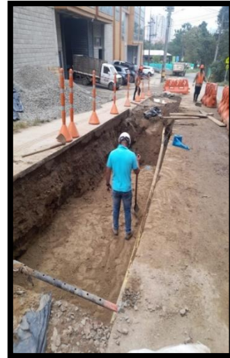
Figura. 19. Excavación segunda zona
