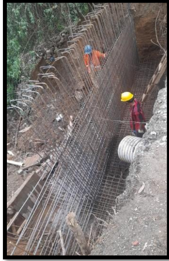
Figura. 7 Disposición muro T1
