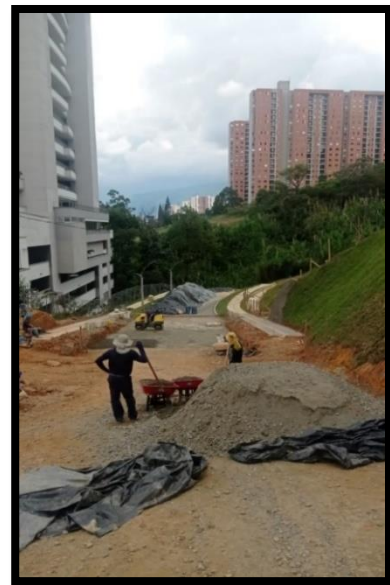
Figura. 32 . Subrasante para colocación de base
