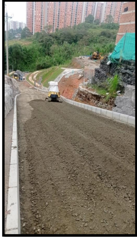
Figura. 34. Compactación de base granular
