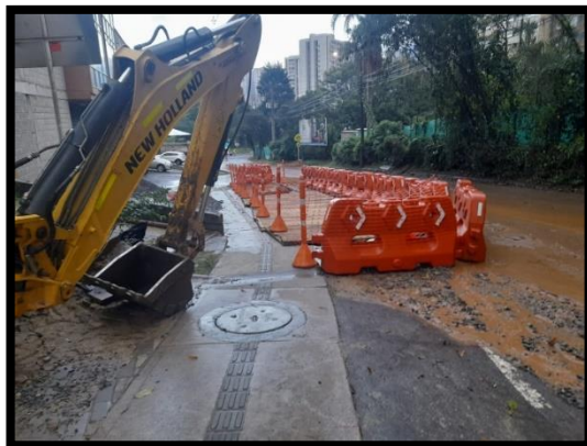
Figura. 20. Cerramiento para excavación
