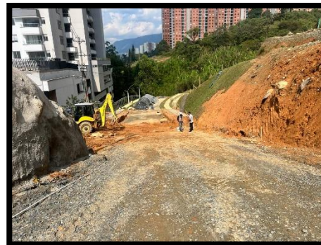
Figura. 14. Zona de Pavimentación
