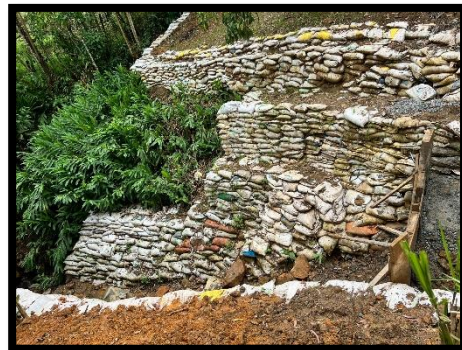
Figura. 26. Refuerzo con costales
