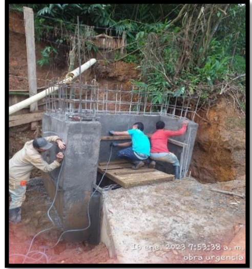
Figura. 8. Construcción de poceta
