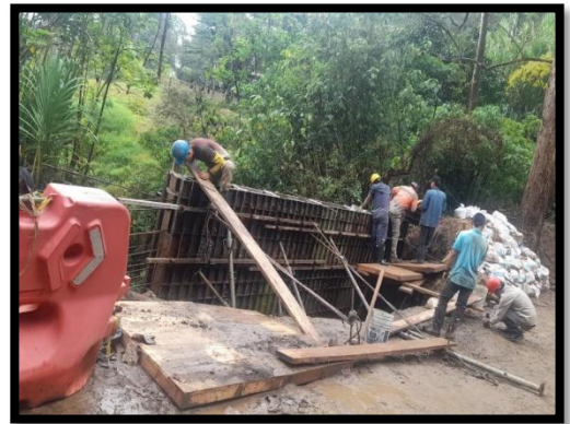
Figura. 10. Fundición del muro T1
