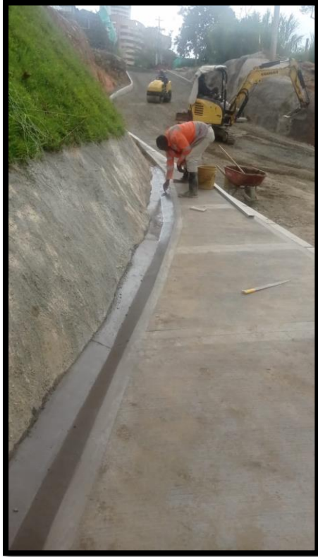
Figura. 33. Construcción de andenes
