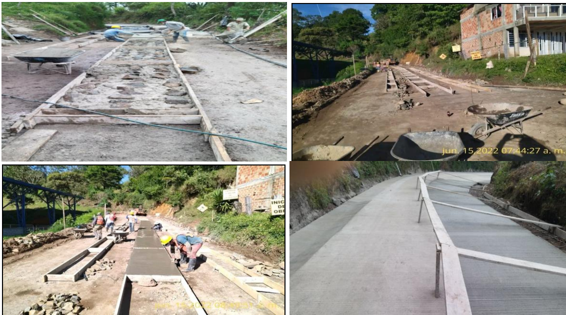
Ilustración 10. Desarrollo de la obra” Colombia Rural”
