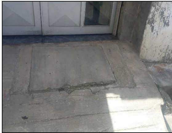
Ilustracion 26. Verificacion acabados sumidero no convencional.
