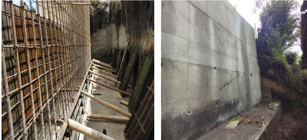
Ilustración 5. Muro de contención vereda Sebastianillo
