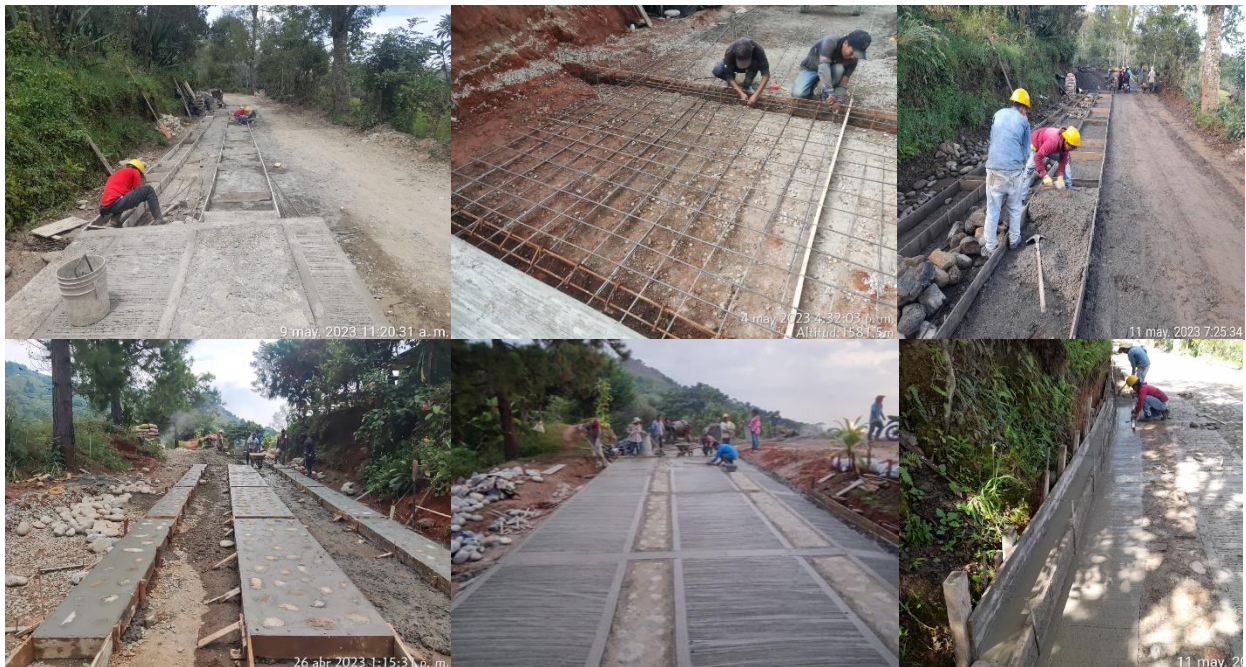
Figura 2. Proceso constructivo de placa huella
