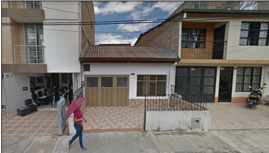
Figura 6. Fachada frontal de la empresa
